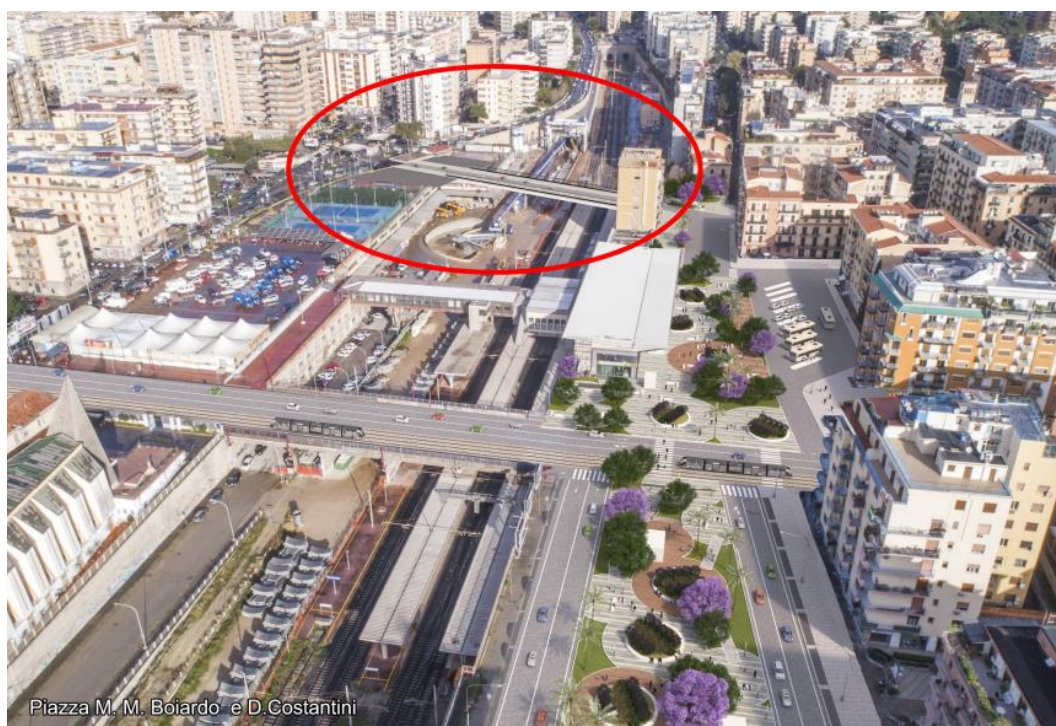
Figura 2.7.1 Realizzazione del ponte Rapisardi
