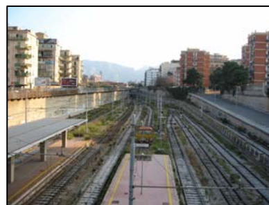
Figura 24. Aree ferroviarie in trincea alla stazione Notarbartolo
