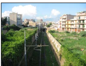
Figura 42. Via Oreto-Ponte sulla ferrovia
