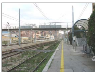
Figura 38. Stazione Tommaso Natale (lato Palermo)
