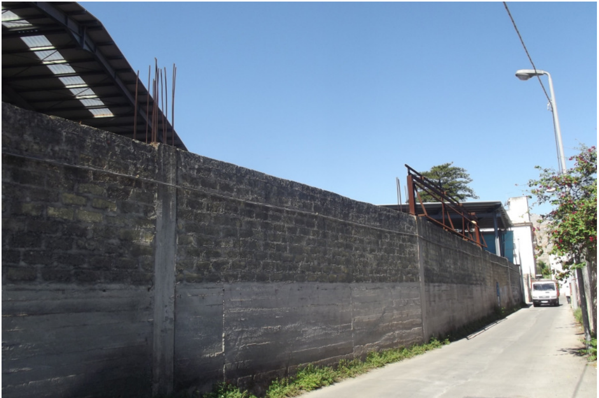
FOTO 17 – Vista edifici esistenti da Via Felice
