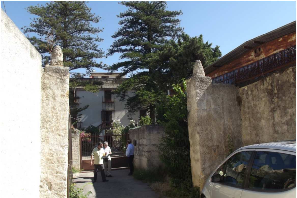
FOTO 3 – Portale di accesso a Villa Anello – Stazzone da Viale Michelangelo
