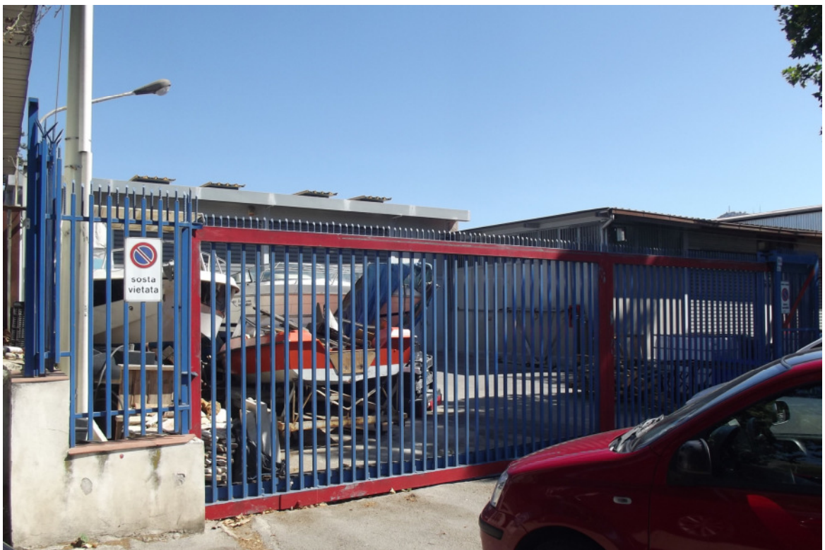
FOTO 6 – Autofficine esistenti su Viale Michelangelo
