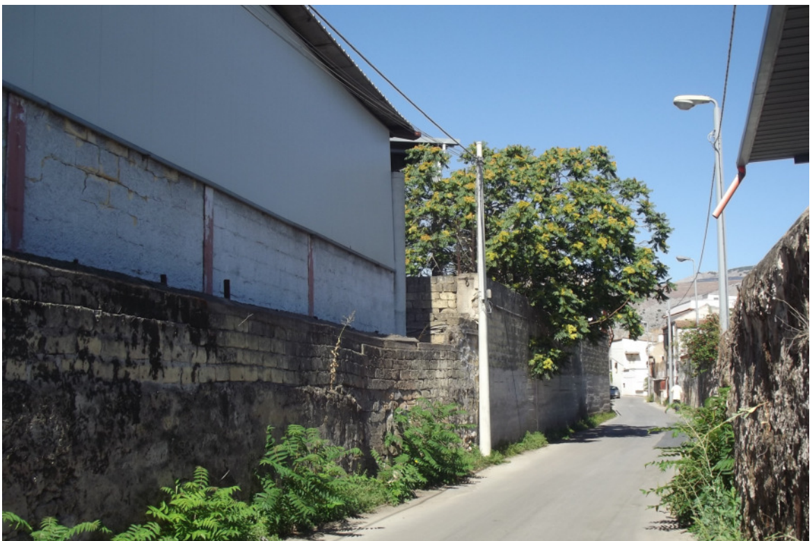
FOTO 16 – Vista edifici esistenti da Via Felice
