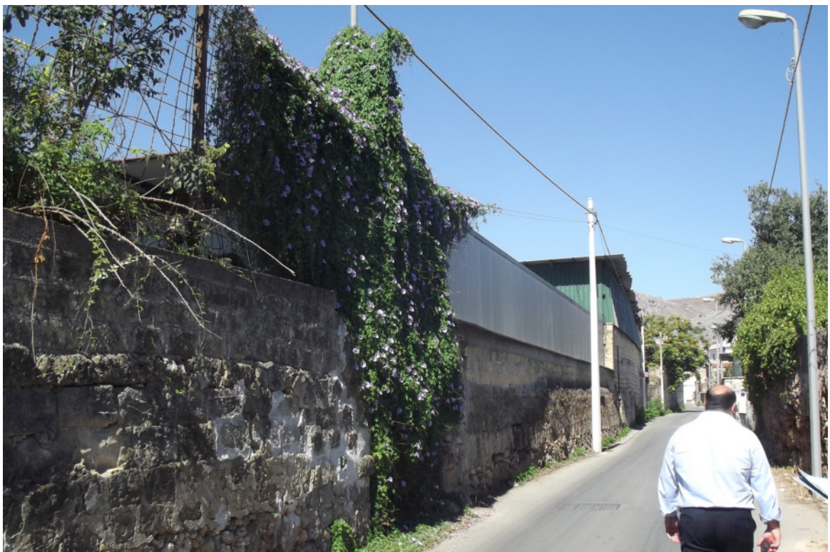
FOTO 14 – Vista edifici esistenti da Via Felice
