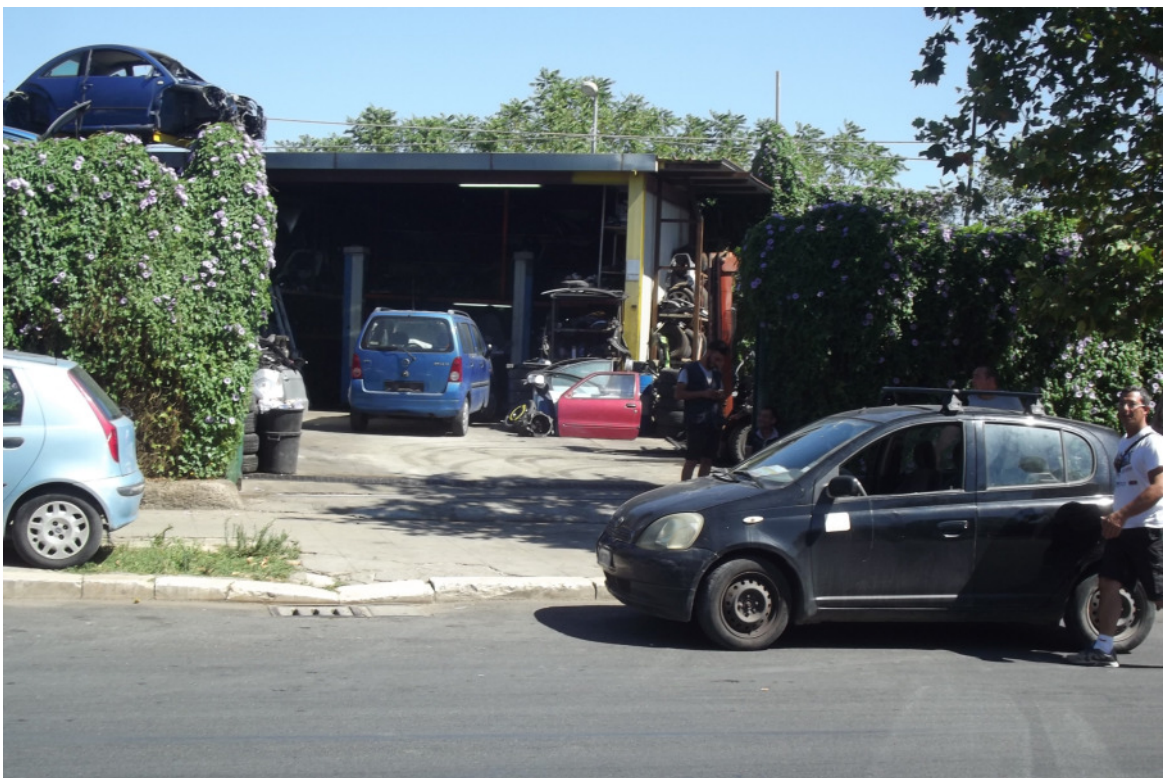
FOTO 12 – Edifici attività autodemozioni su Viale Michelangelo
