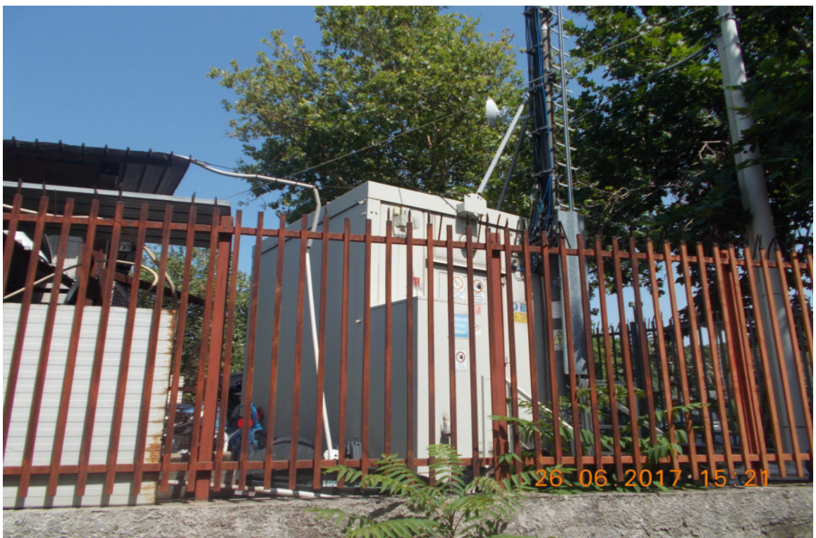
FOTO 4 – Antenna semovente ITALTEL
