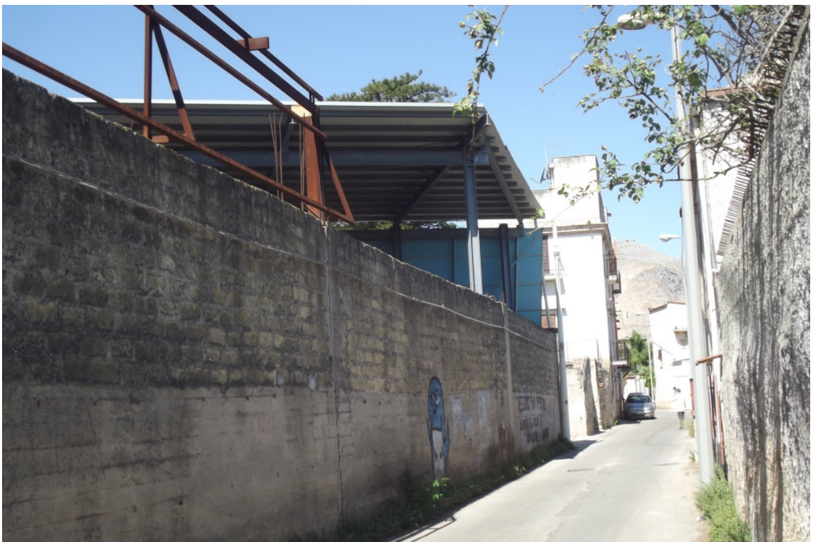
FOTO 18 – Vista edifici esistenti da Via Felice
