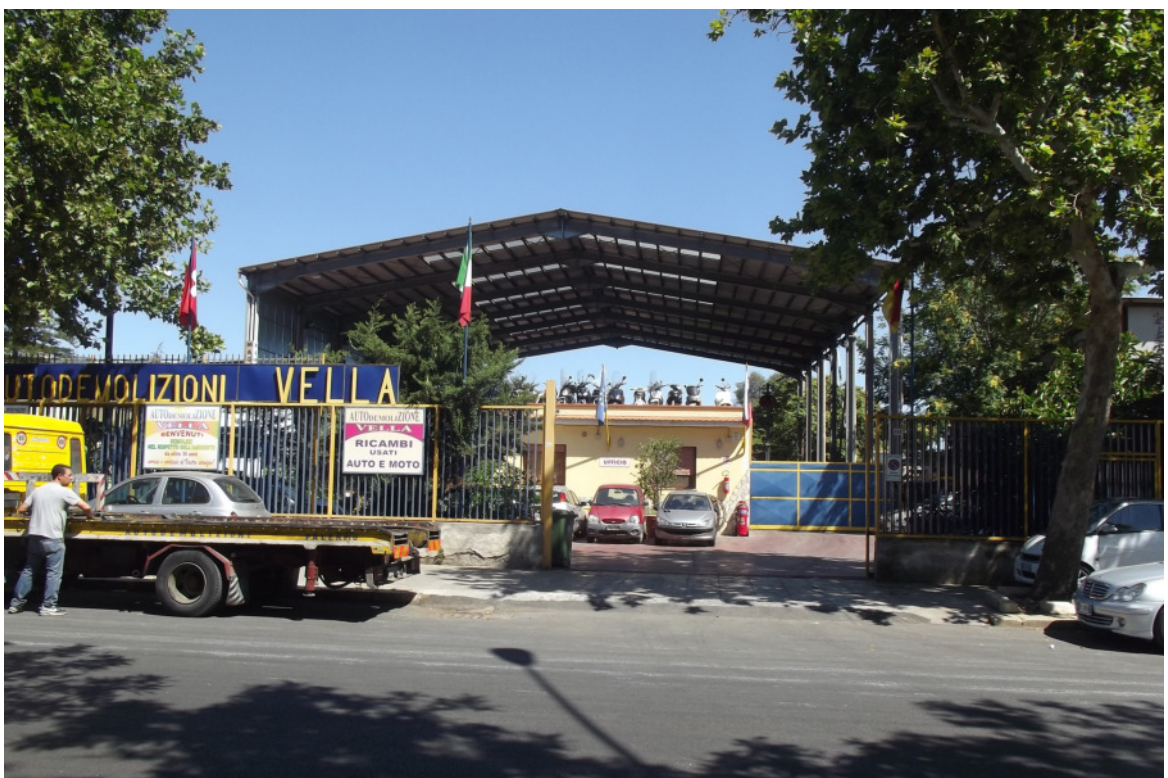
FOTO 10 – Edifici attività autodemozioni su Viale Michelangelo
