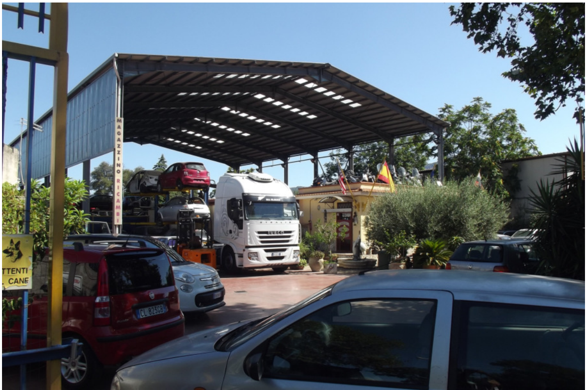
FOTO 9 – Edifici attività autodemozioni su Viale Michelangelo
