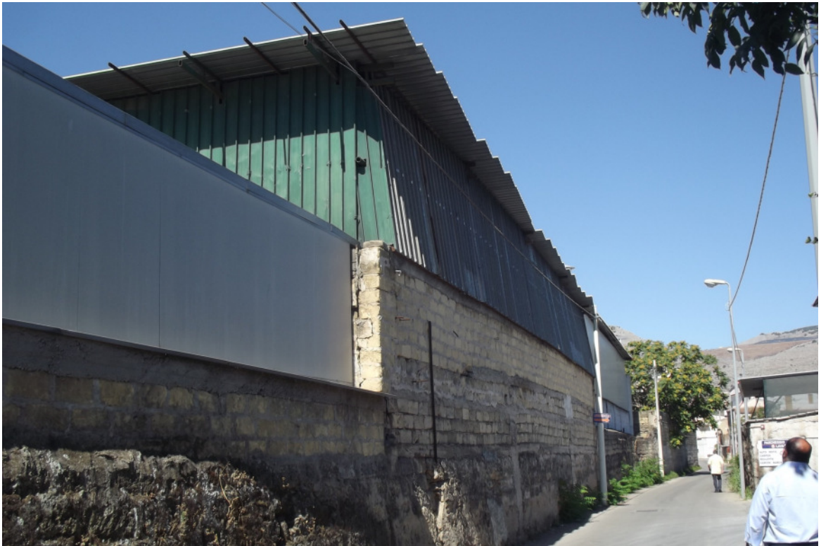
FOTO 15 – Vista edifici esistenti da Via Felice
