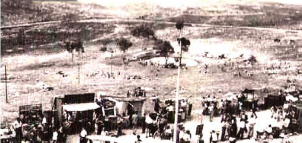
Foto storica del sito
