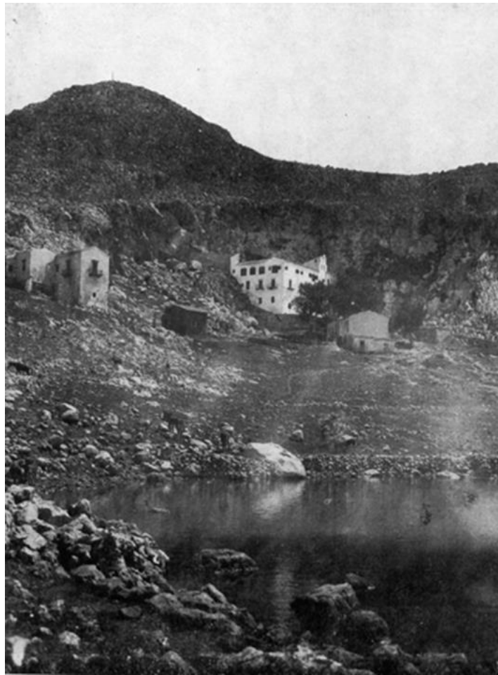
Foto storica del sito
