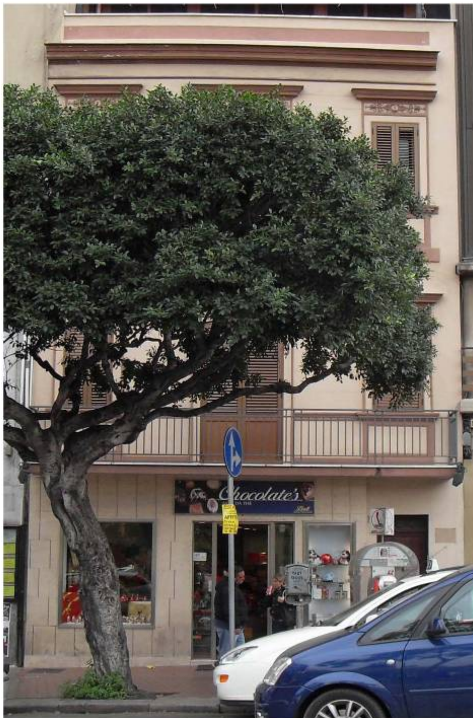
Vista fotografica prospetto edificio
