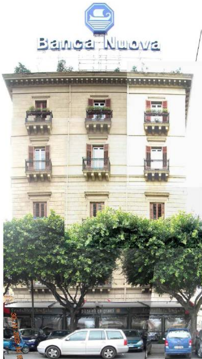
Vista fotografica prospetto edificio
