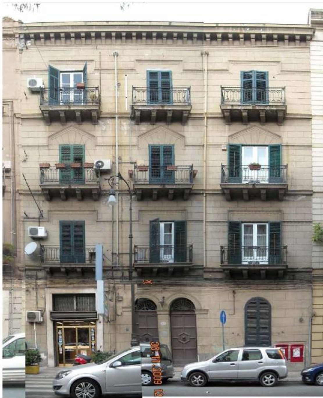
Vista fotografica prospetto edificio
