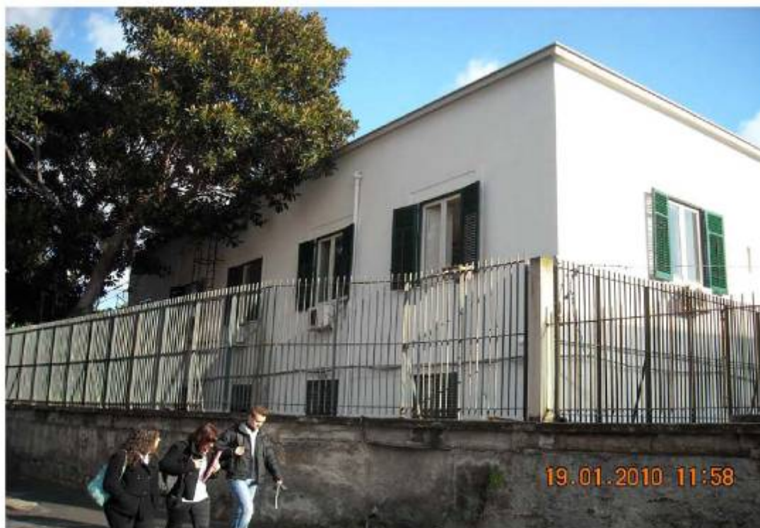
Vista fotografica prospetto edificio
