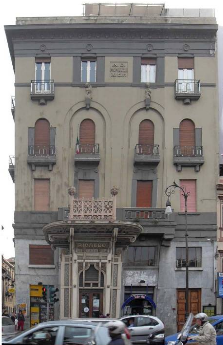
Vista fotografica prospetto edificio
