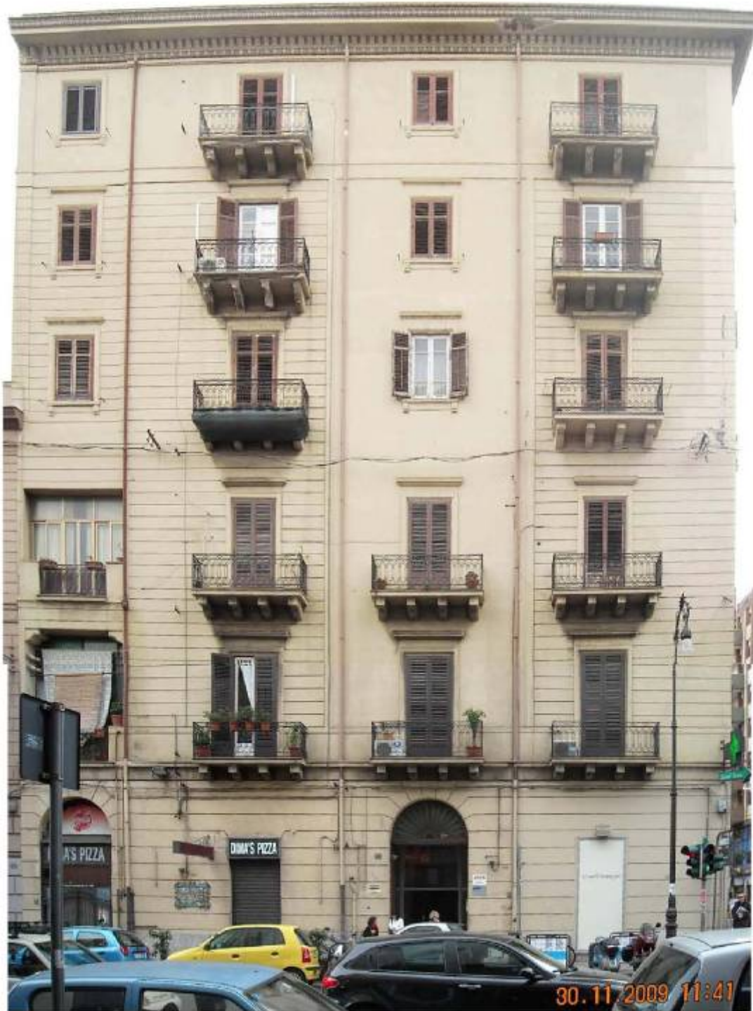
Vista fotografica prospetto edificio
