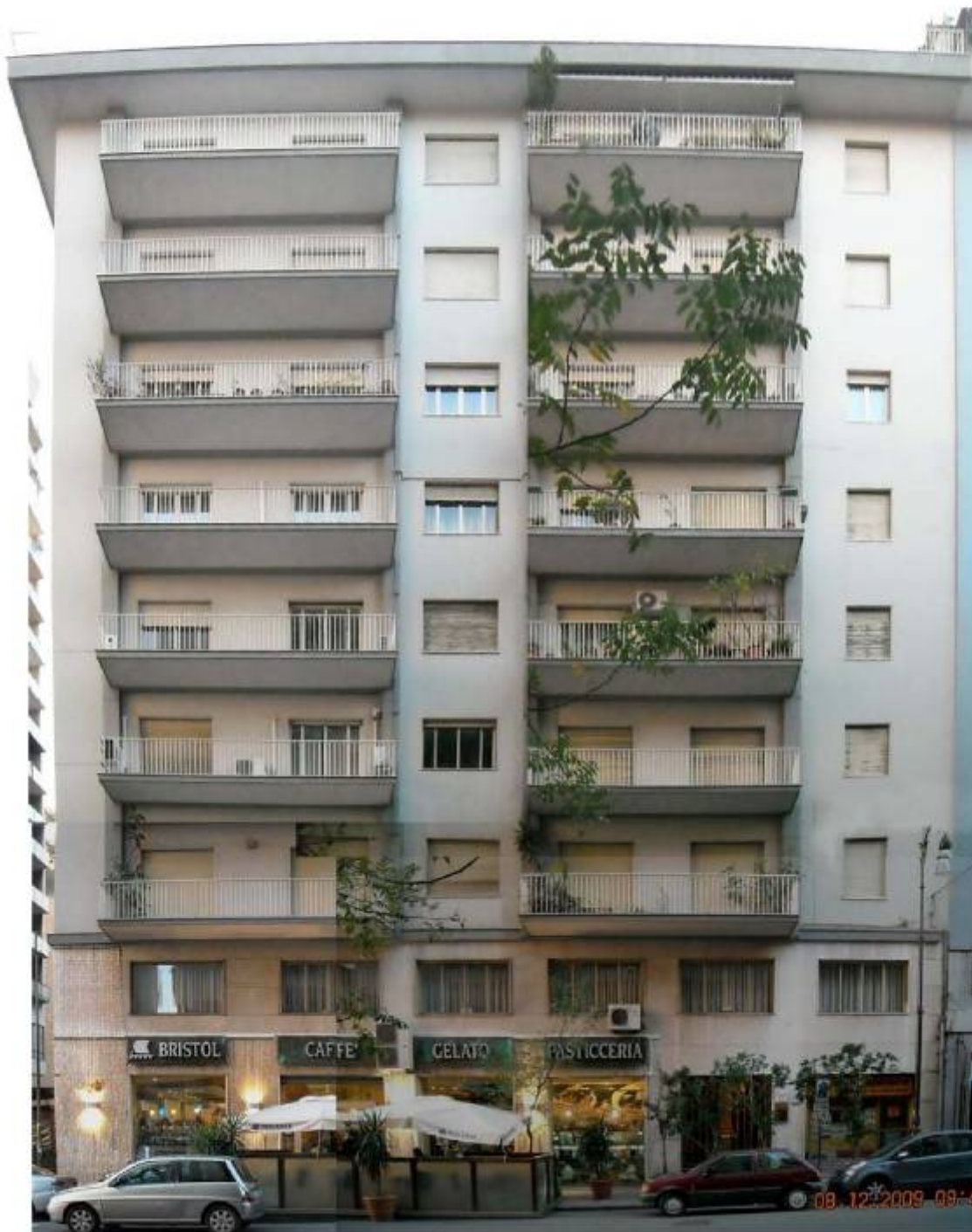
Vista fotografica prospetto edificio
