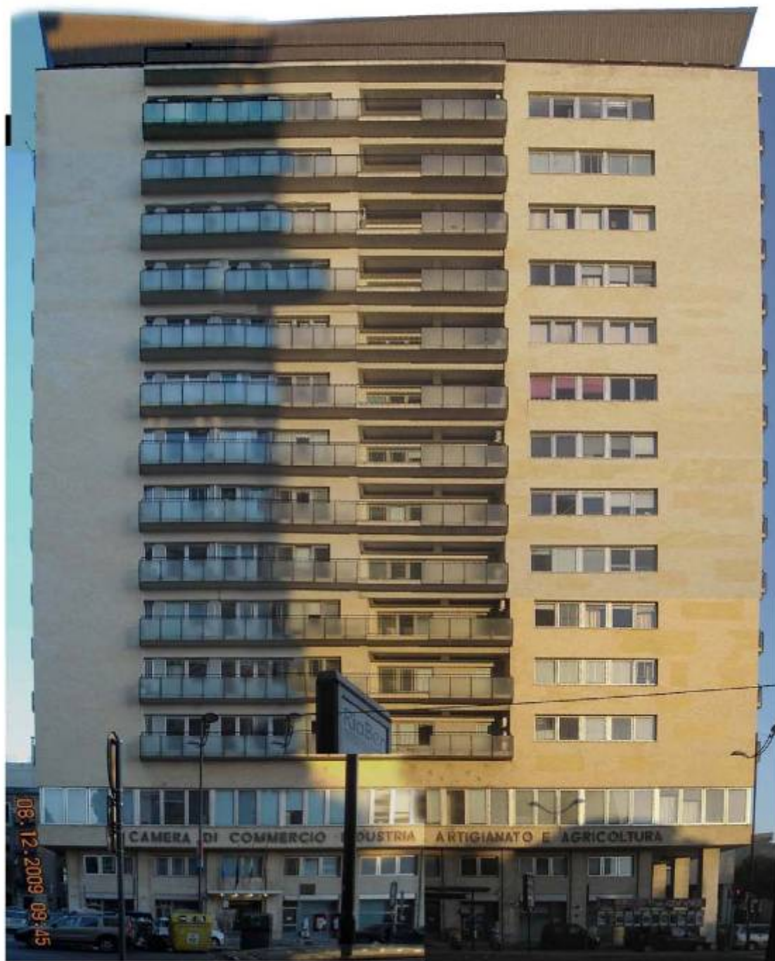
Vista fotografica prospetto edificio
