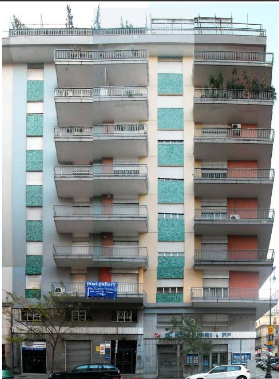
Vista fotografica prospetto edificio
