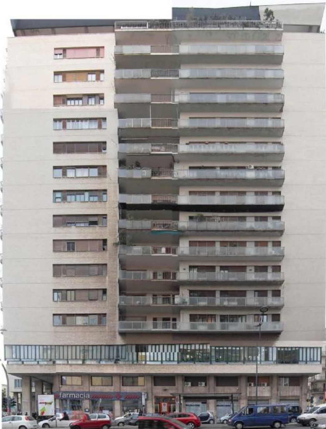
Vista fotografica prospetto edificio
