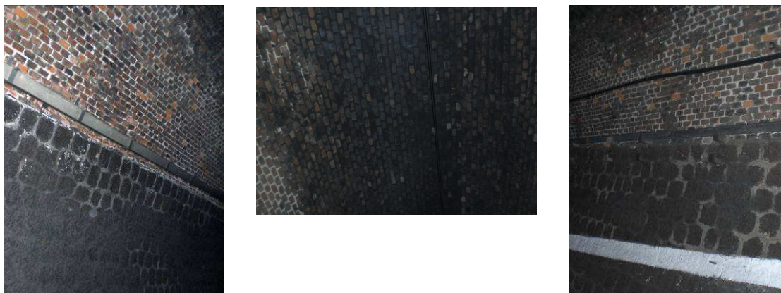
Figura 6 – Galleria Ranchibile – Ispezione visiva
