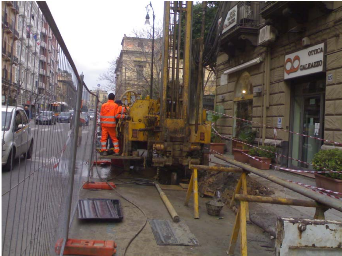
Postazione sondaggio SE10
