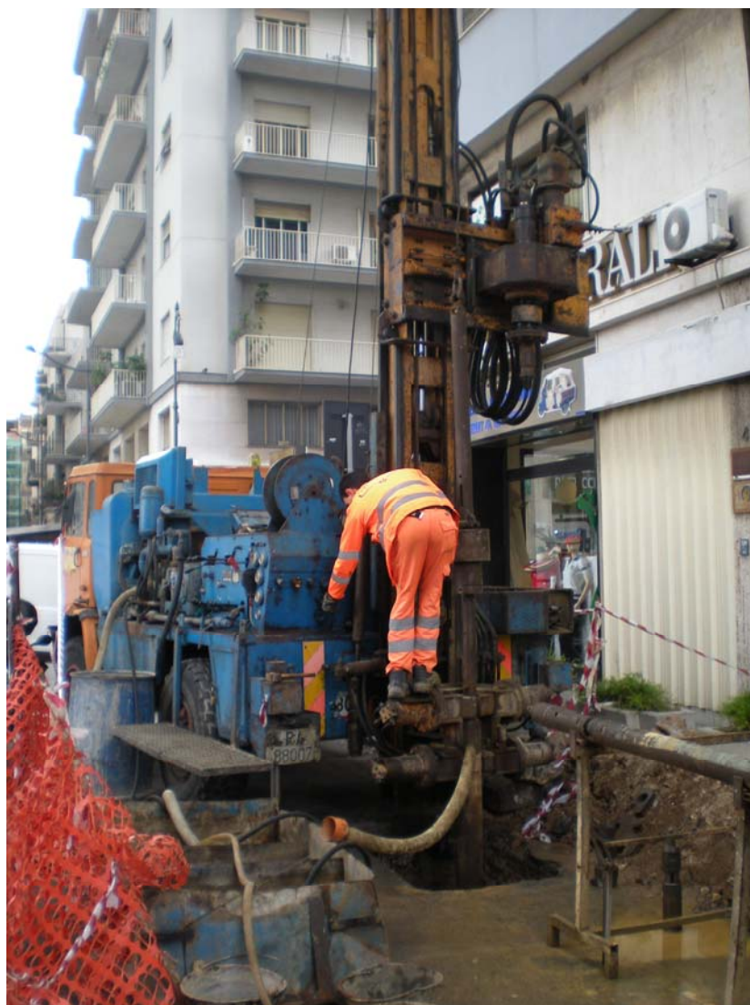
Postazione sondaggio SE07
