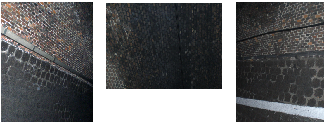
Figura 7 – Galleria Ranchibile – Ispezione visiva
