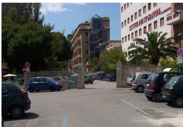
Foto 18 Zona futura botola di accesso VVFF
