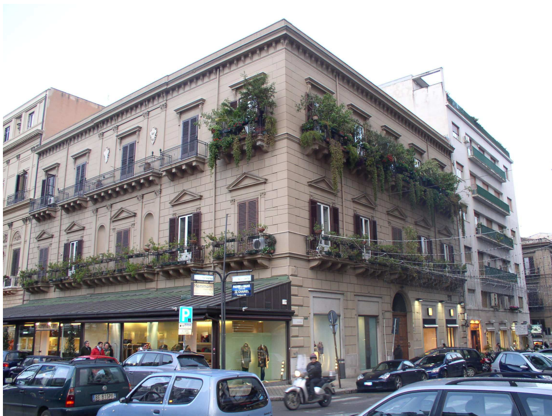
Prospetto su via della Libertà angolo via Torrearsa
