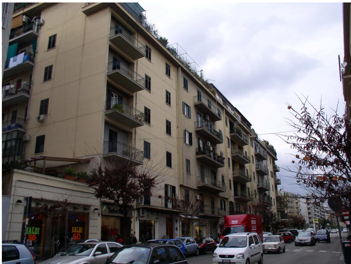
Prospetto su via Sciuti
