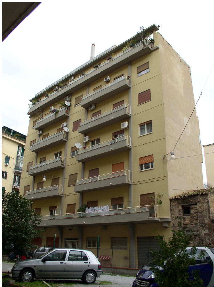
Prospetto su via A. Pecoraro
