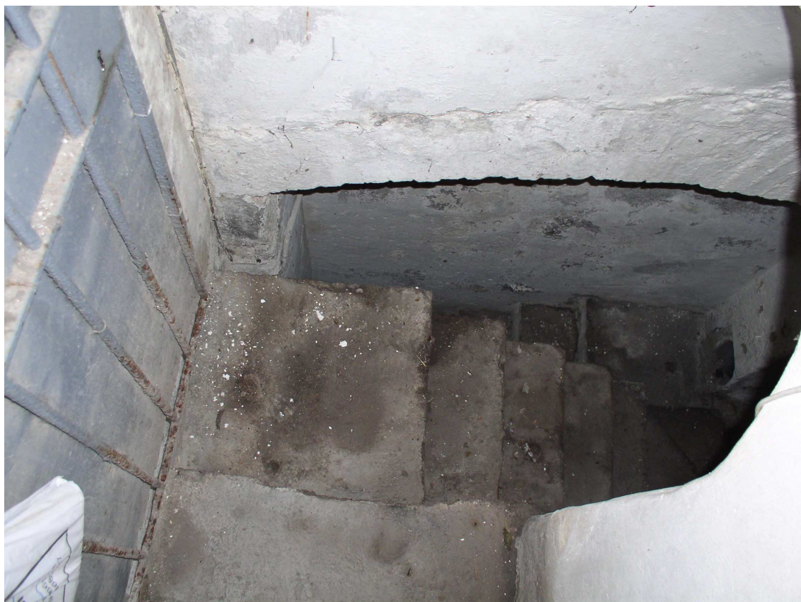
Scale di accesso al secondo seminterrato
