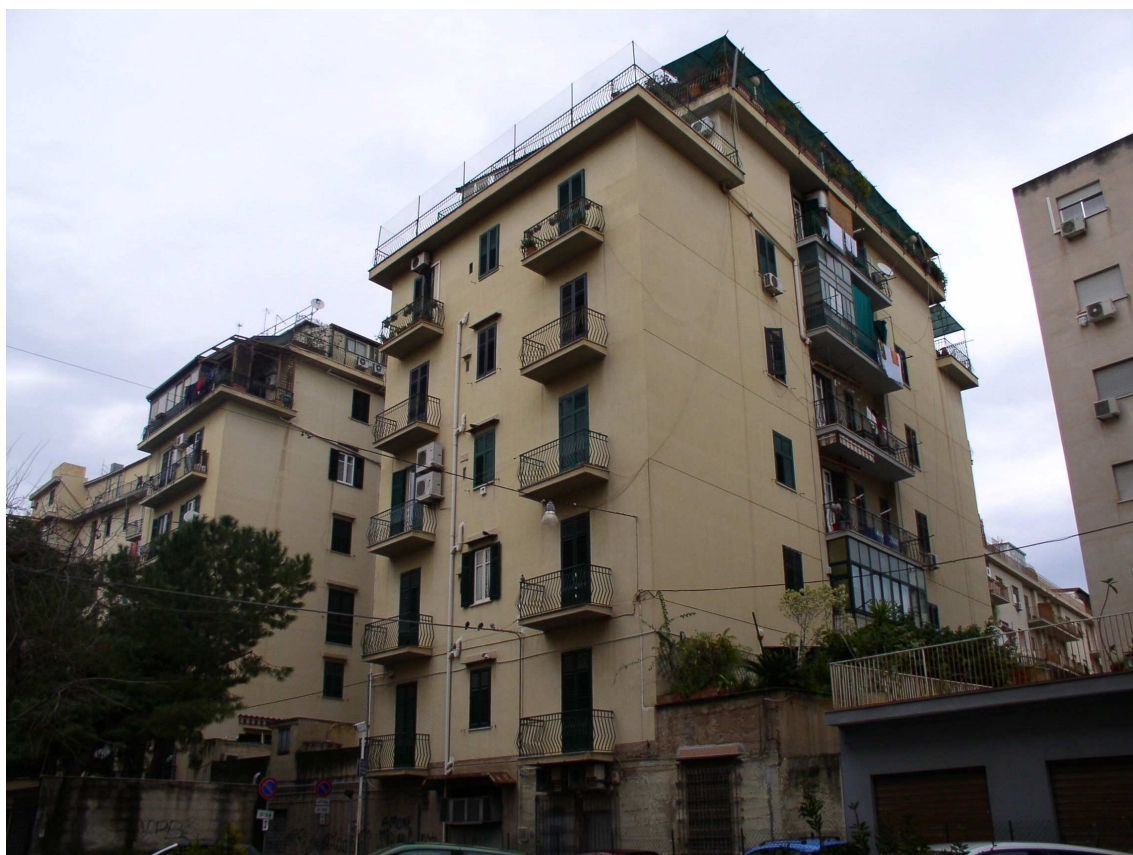
Prospetto su via A. Pecoraro
