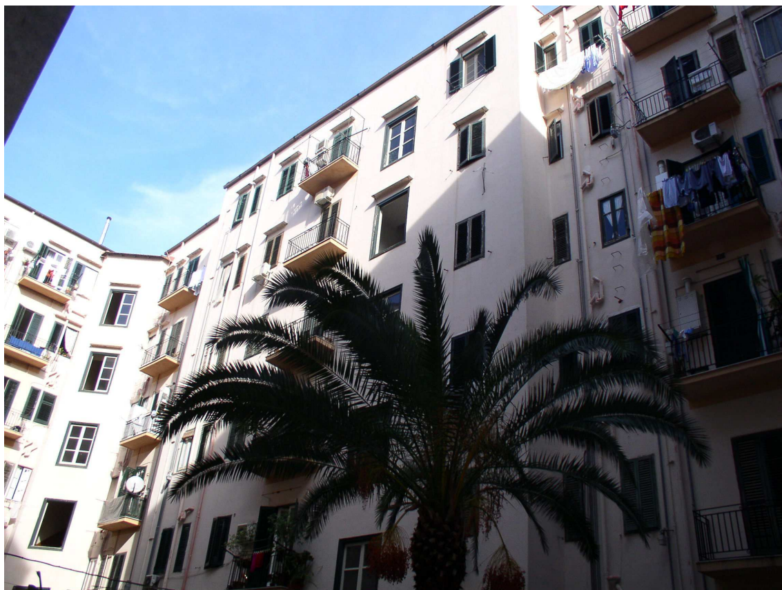
Retroprospetto interno di via Terrasanta
