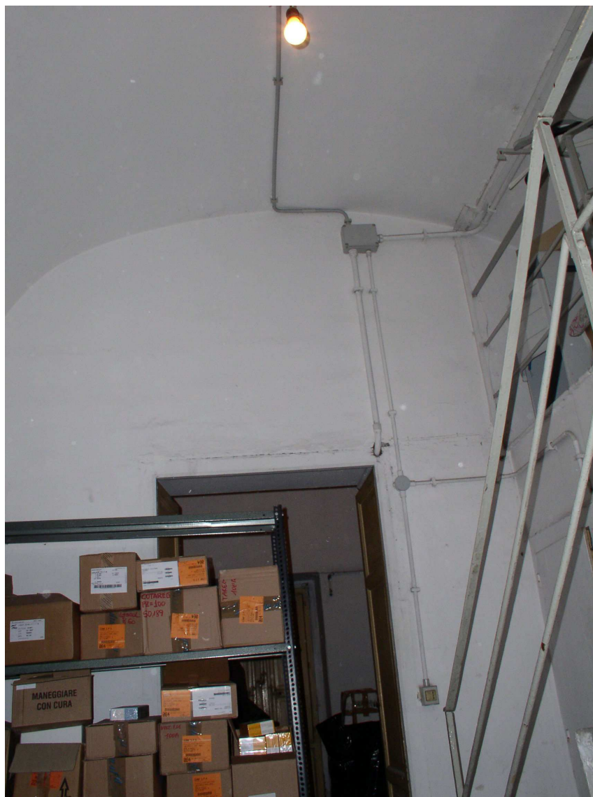
Locale interrato con copertura a volta
