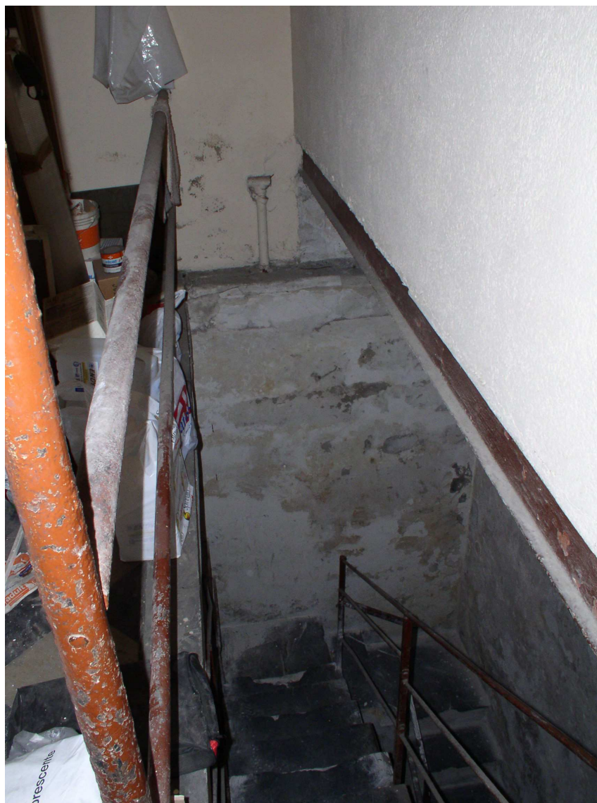
Scala di accesso ai locali interrati
