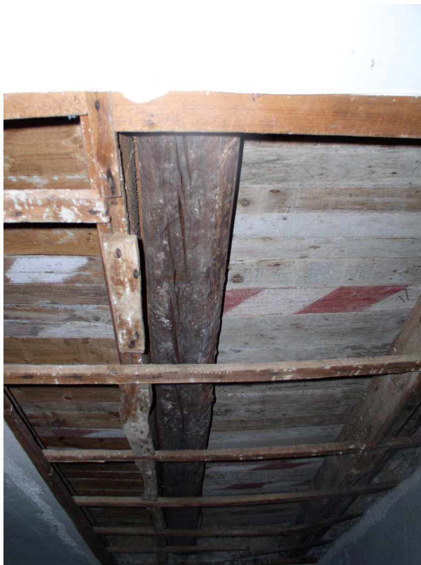
Solaio in legno del piano primo
