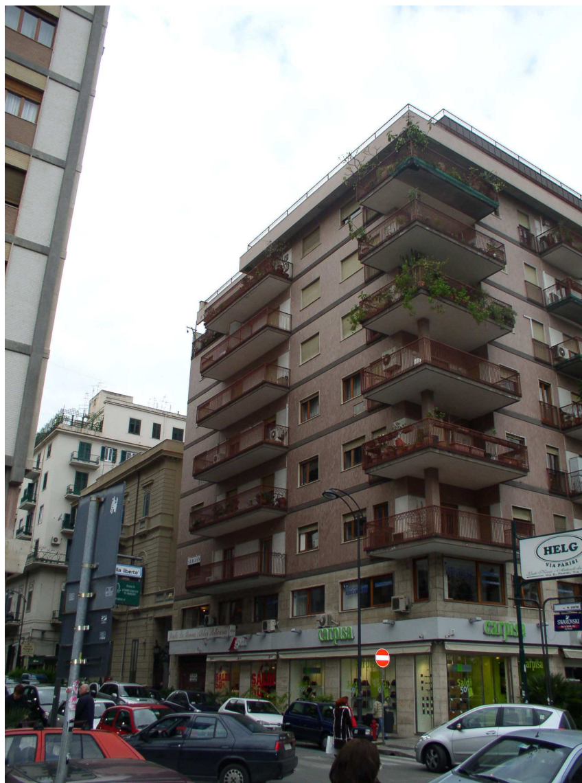
Prospetto su via E. Parisi
