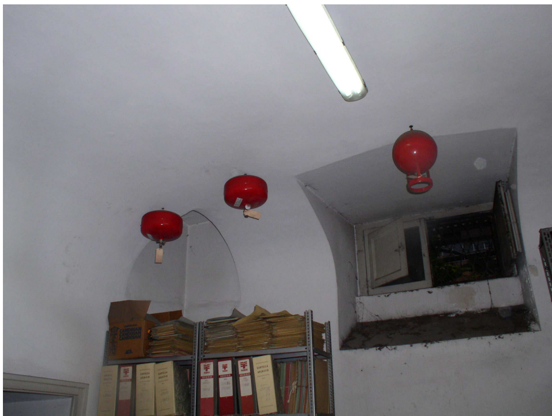
Volte piano interrato
