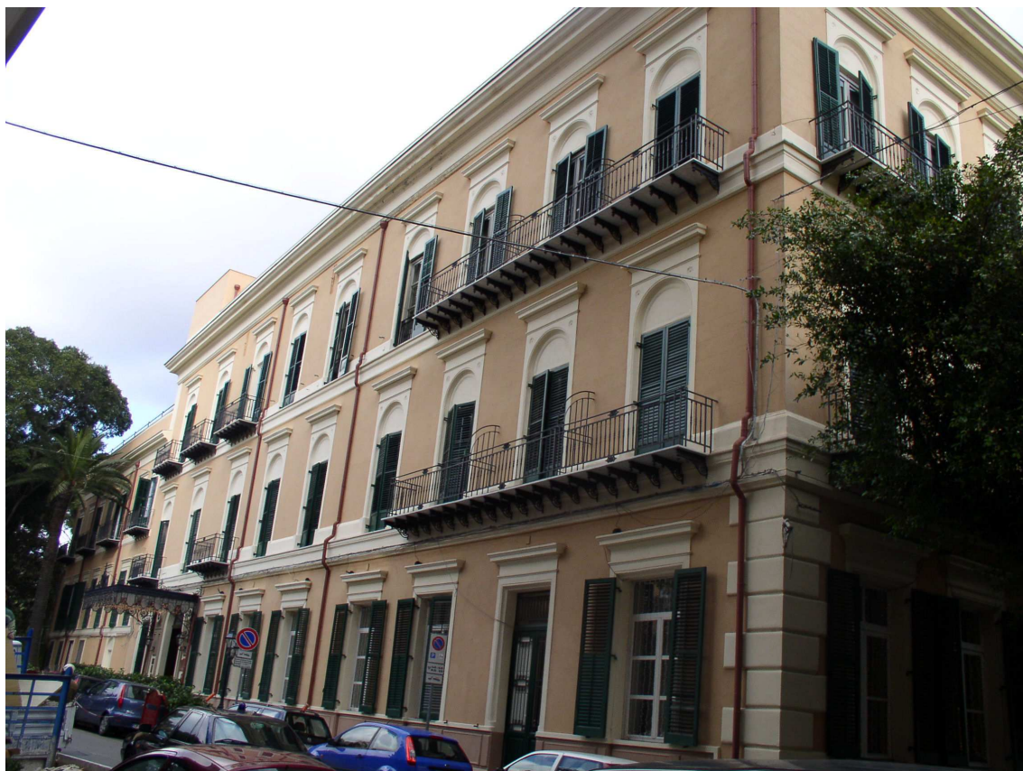
Prospetto su via Marchese Ugo
