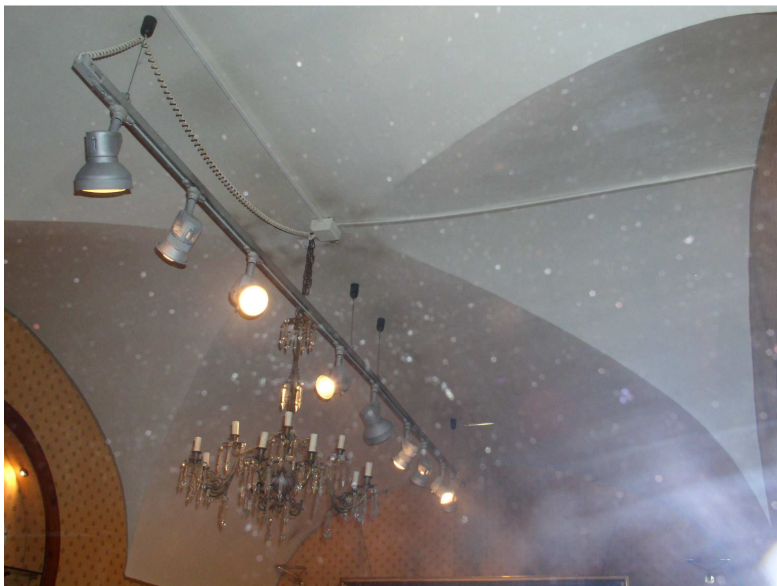
Locale interrato (particolare dei solai)
