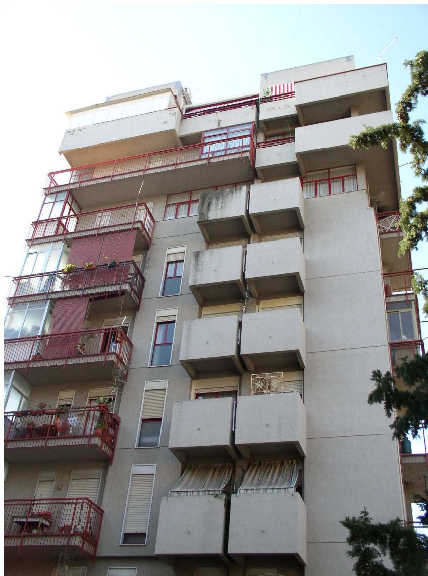
Prospetto su via A. Pecoraro
