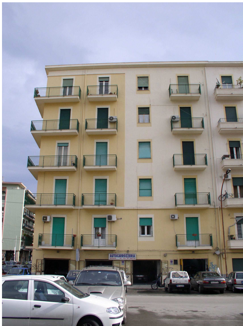
Prospetto su via A. Pecoraro
