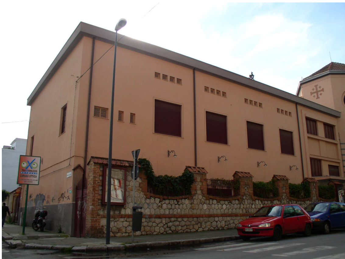
Prospetto su via Almeyda
