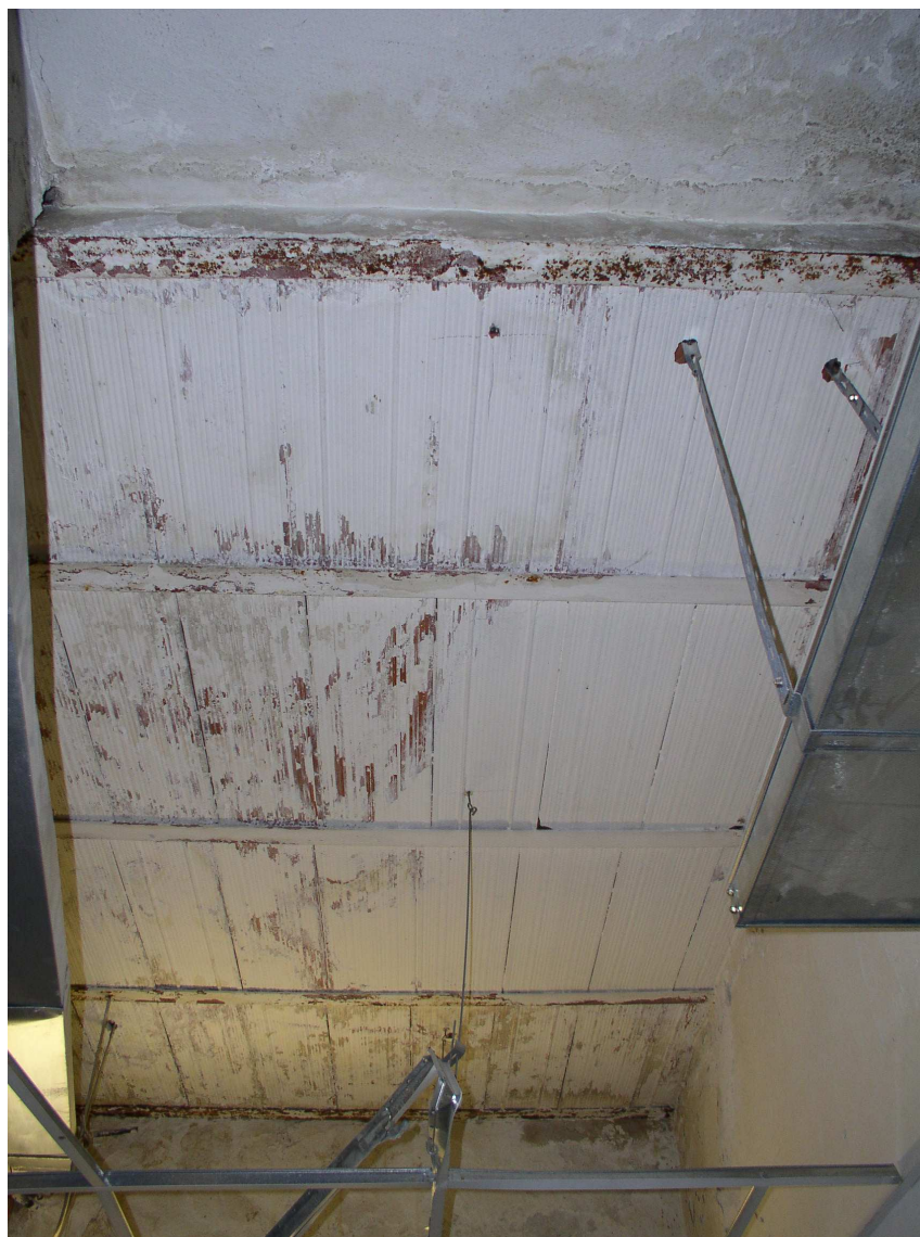
Solaio locale interrato
