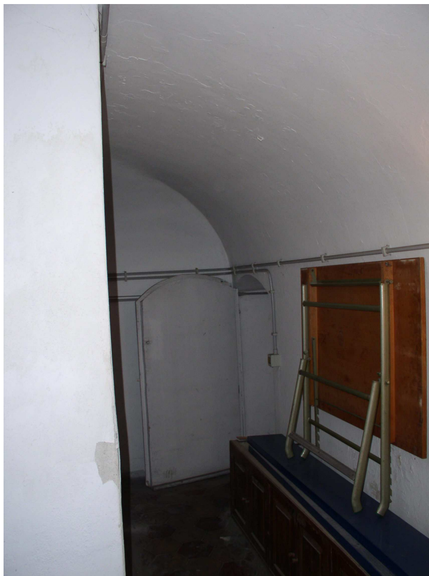
Locale interrato con copertura a volta
