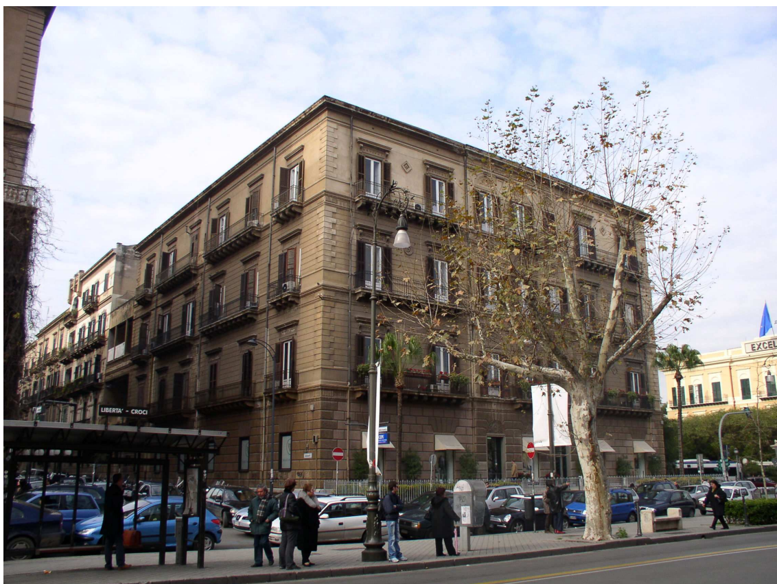
Prospetti su via della Libertà angolo via Caltanissetta
