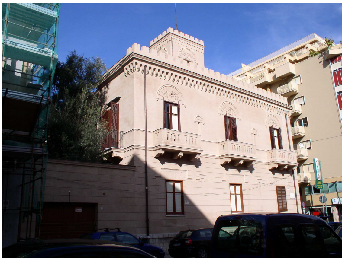
Prospetto su via Almeyda
