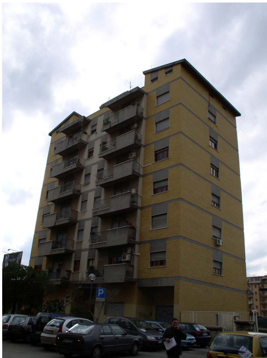
Prospetto su via Pecoraio e prospetto laterale
