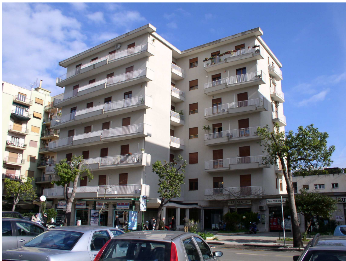
Prospetto su via Sciuti
