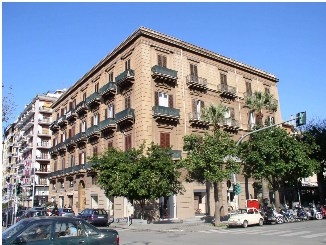
Prospetto su via Archimede
