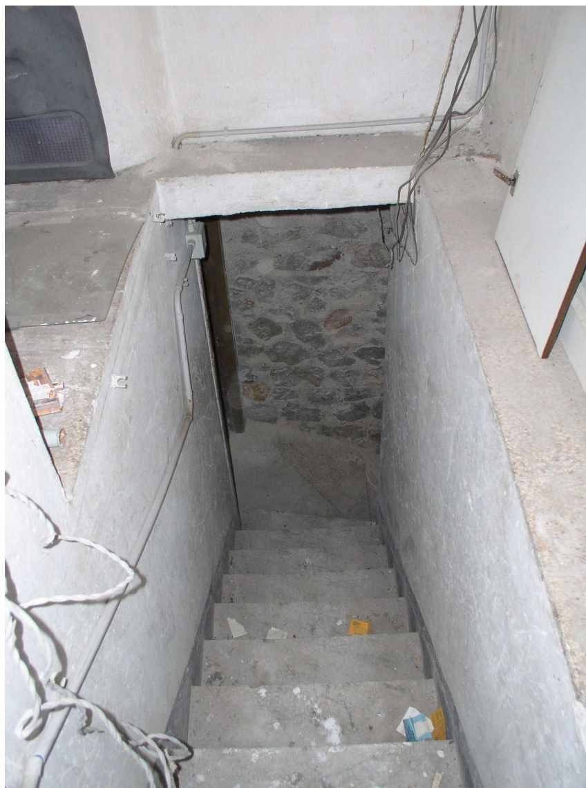
Scala interna di accesso ai locali interrati
