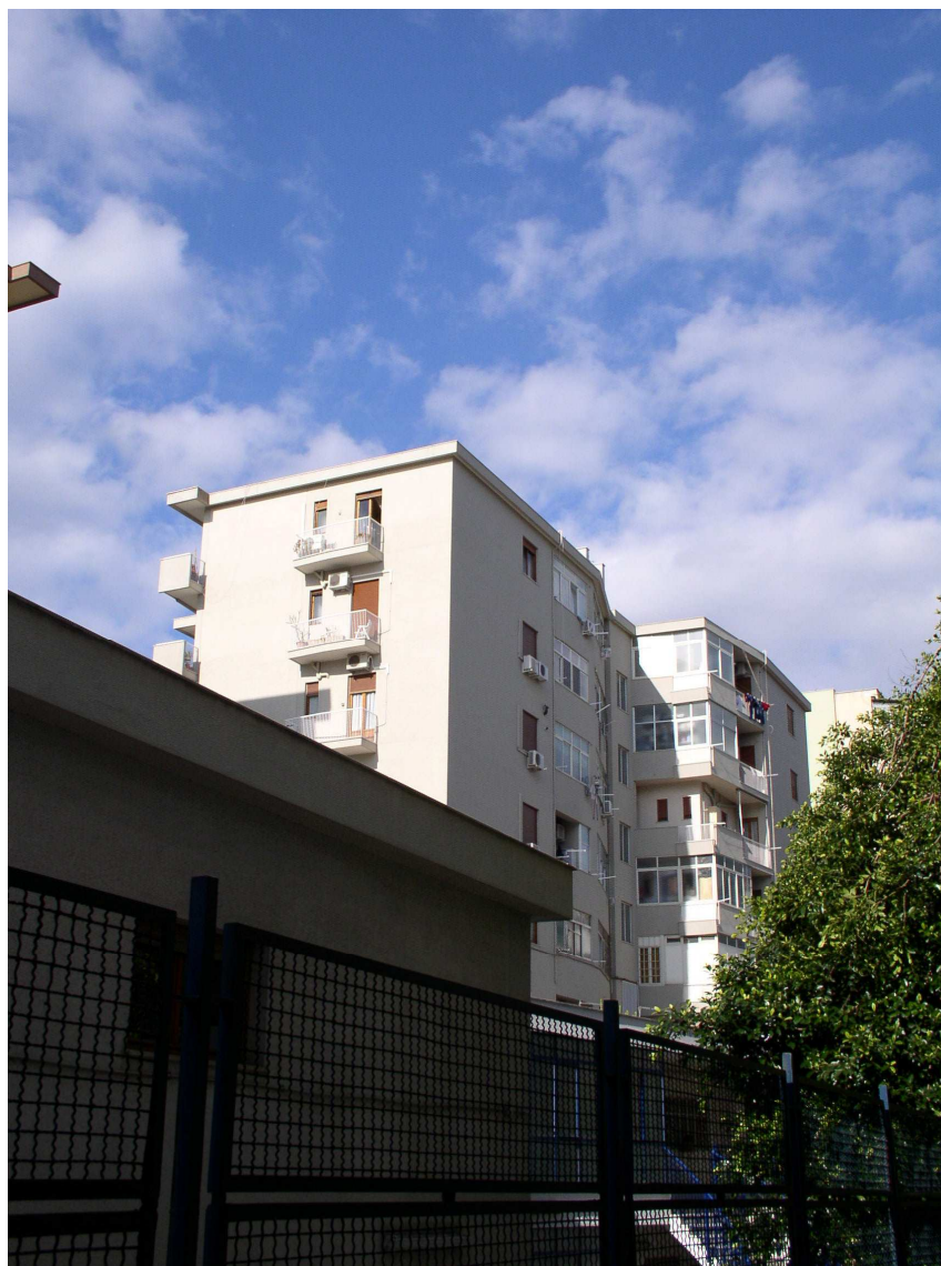
Prospetto laterale e retrospetto di via Sciuti
