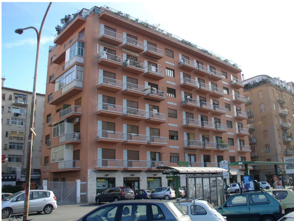
Prospetto su via Generale Di Maria
