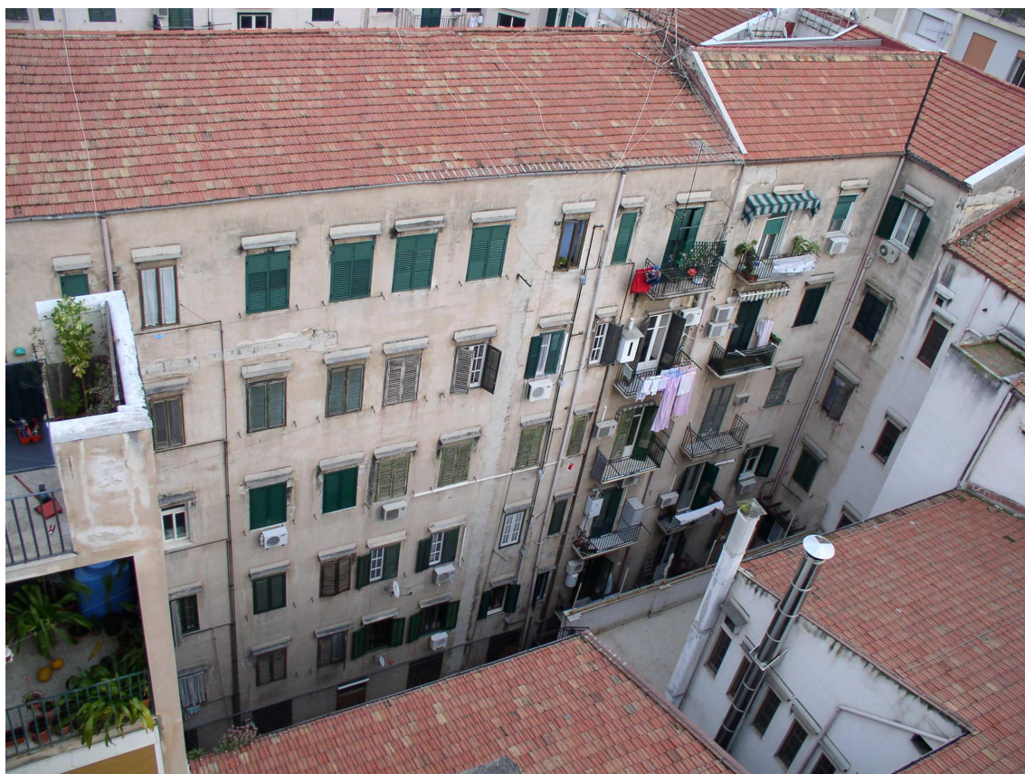
Retroprospetto interno di via Terrasanta
