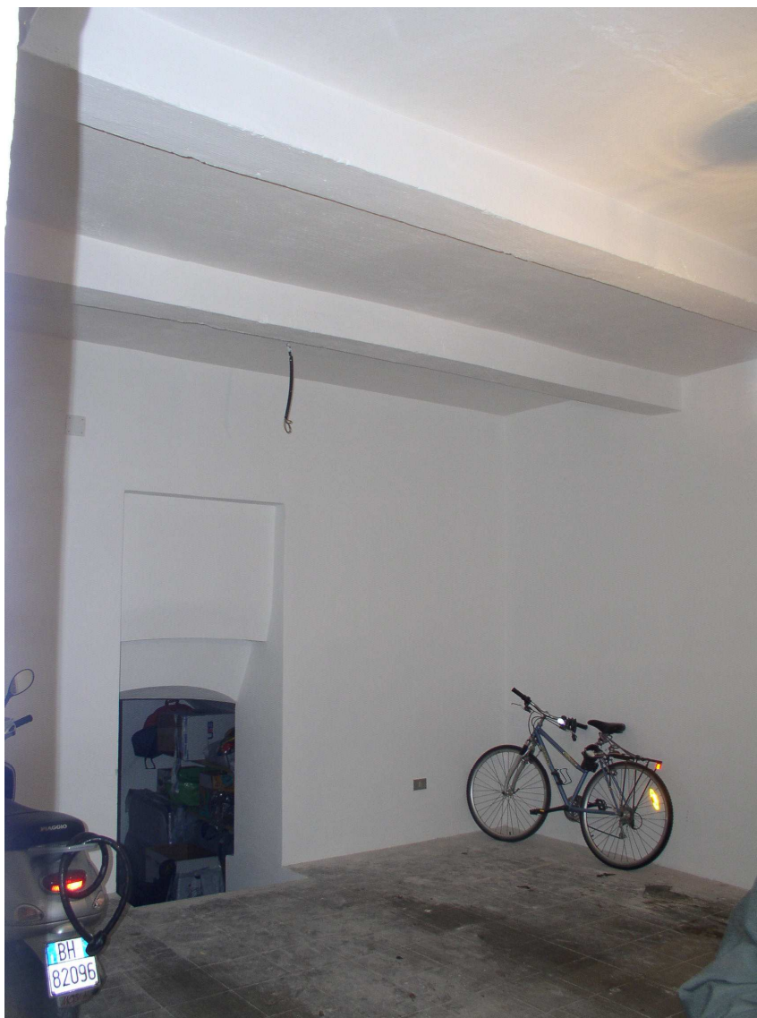
Locale a piano terra con accesso a locale semi-interrato
