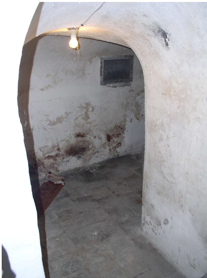
Locale piano primo seminterrato
