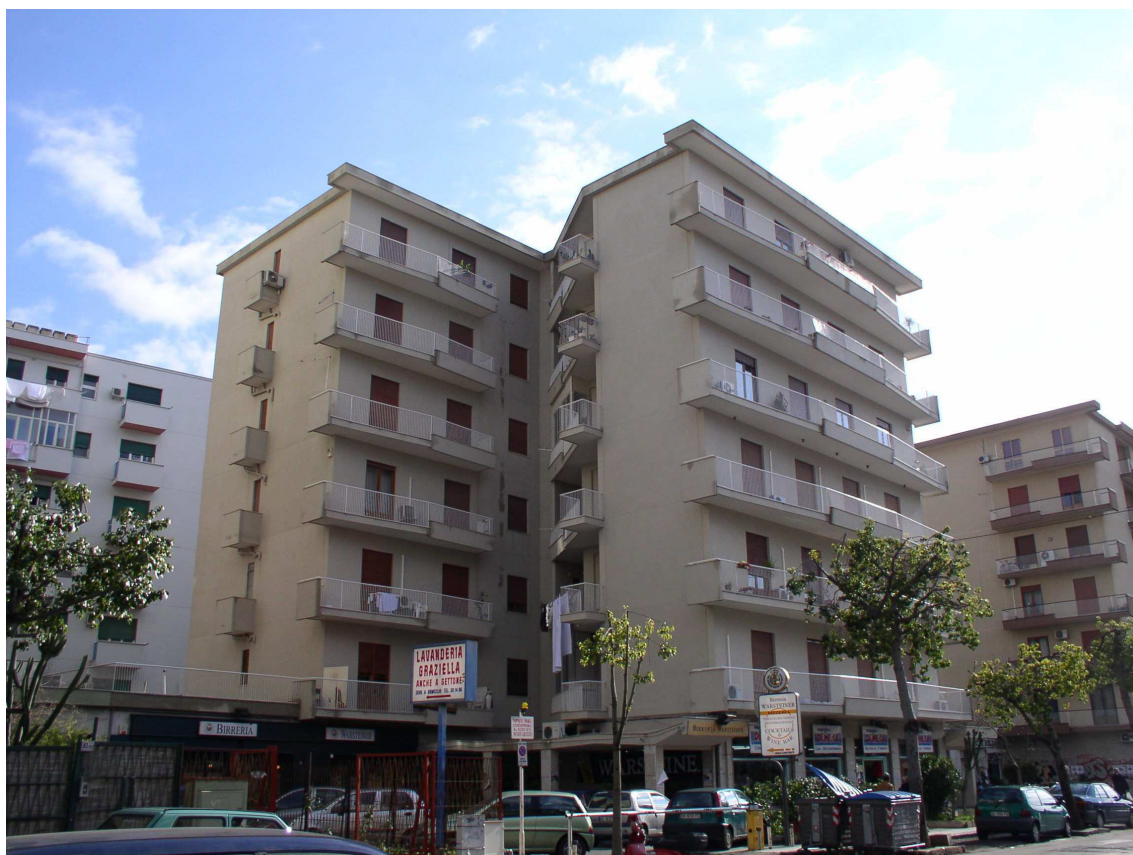
Prospetto su via Sciuti
