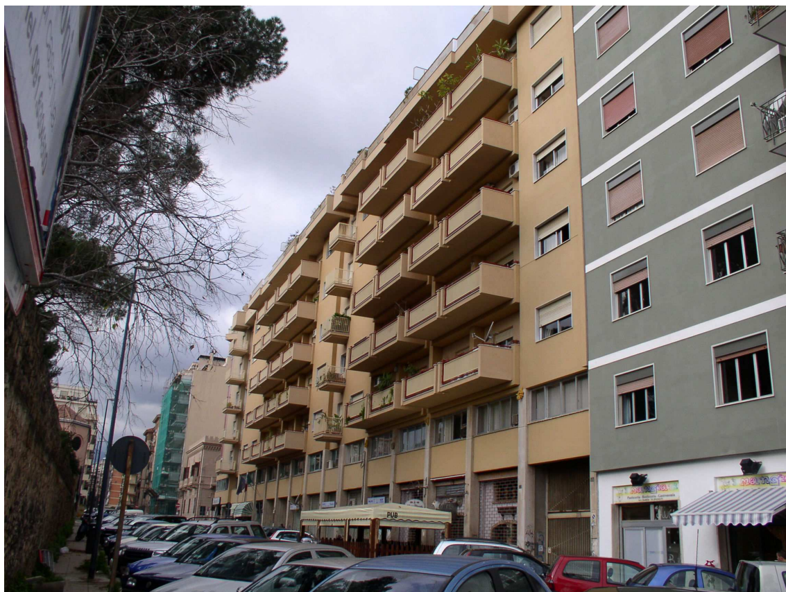
Prospetto su via Almeyda
