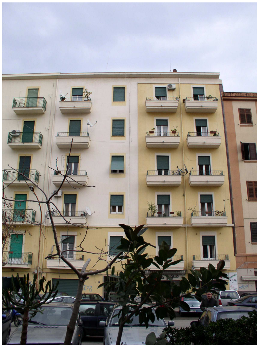
Prospetto su via A. Pecoraro
