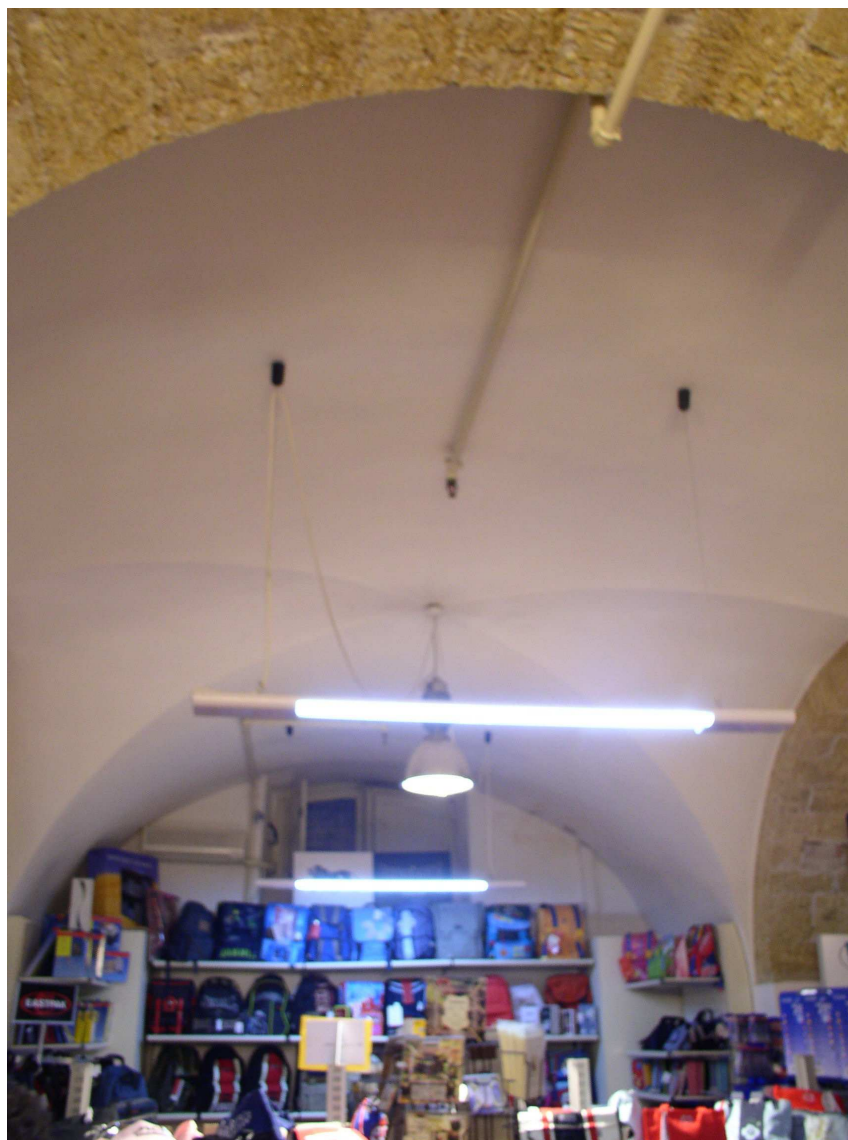
Locale interrato (particolare solai)
