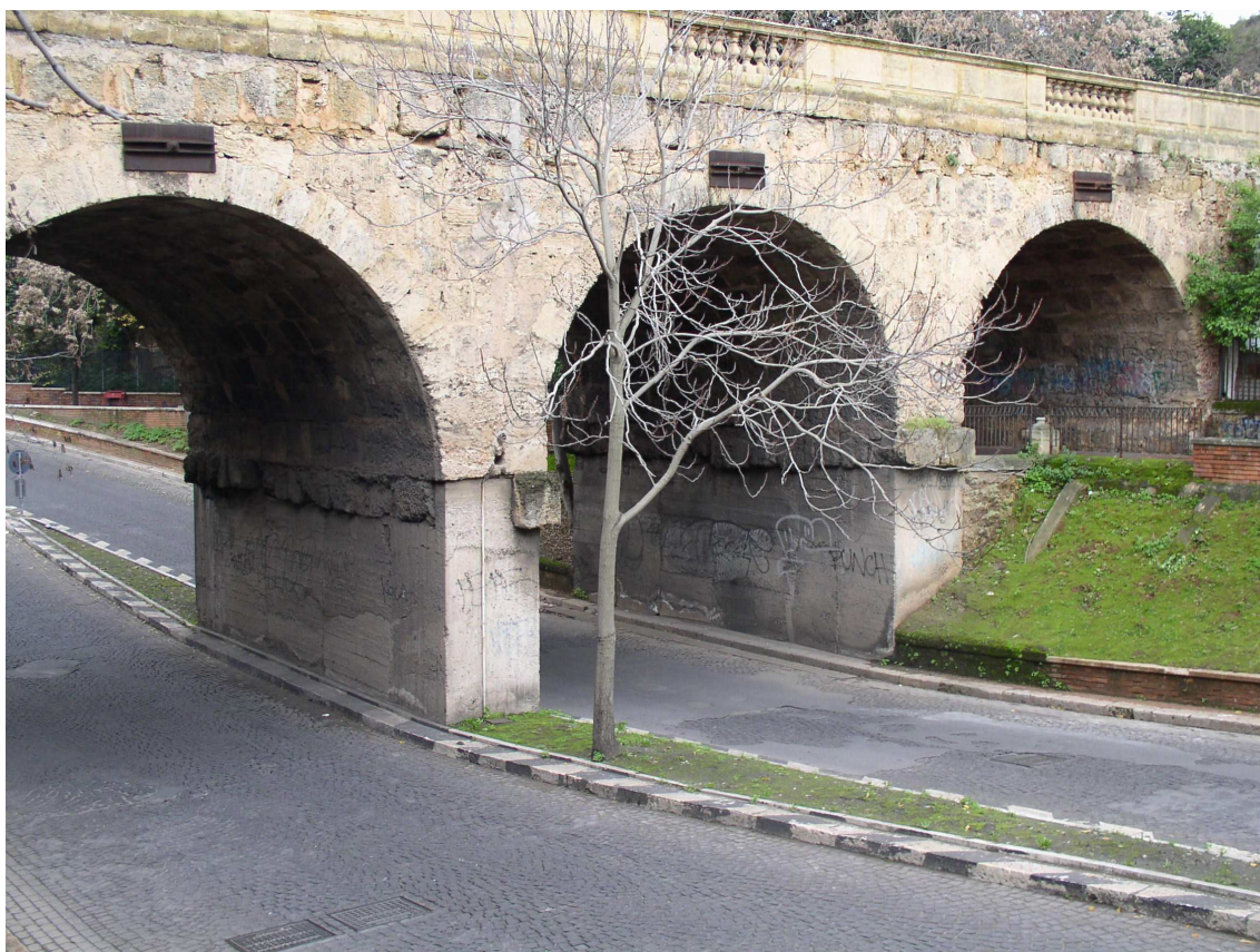
Particolare dei piedritti in C.A.
