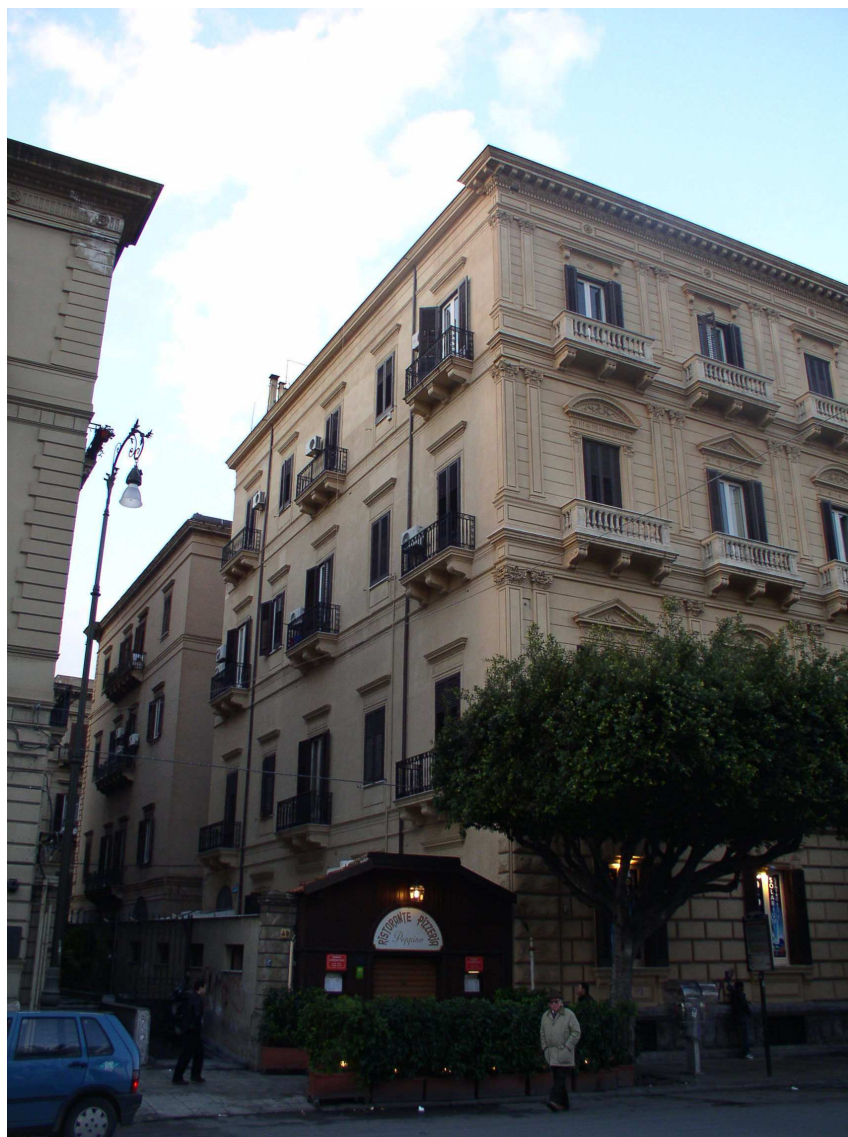
Prospetto laterale da via Dante
