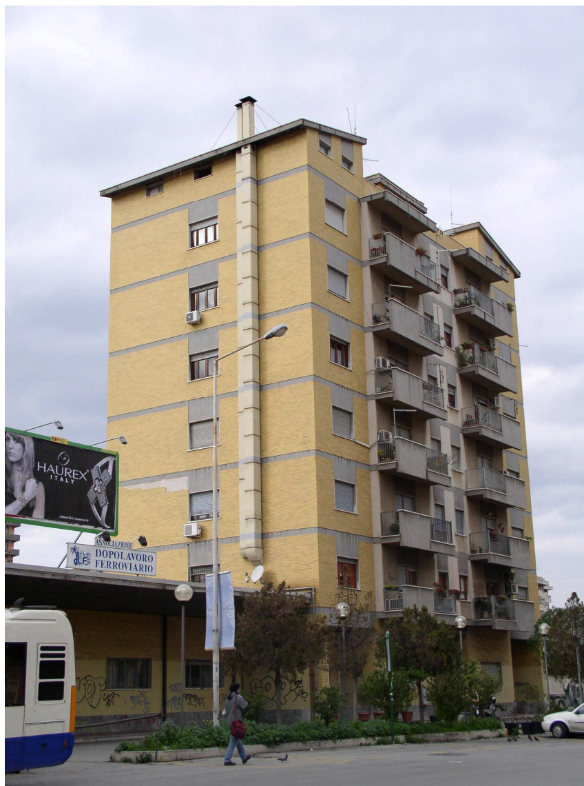
Prospetto su via Pecoraio e prospetto laterale
