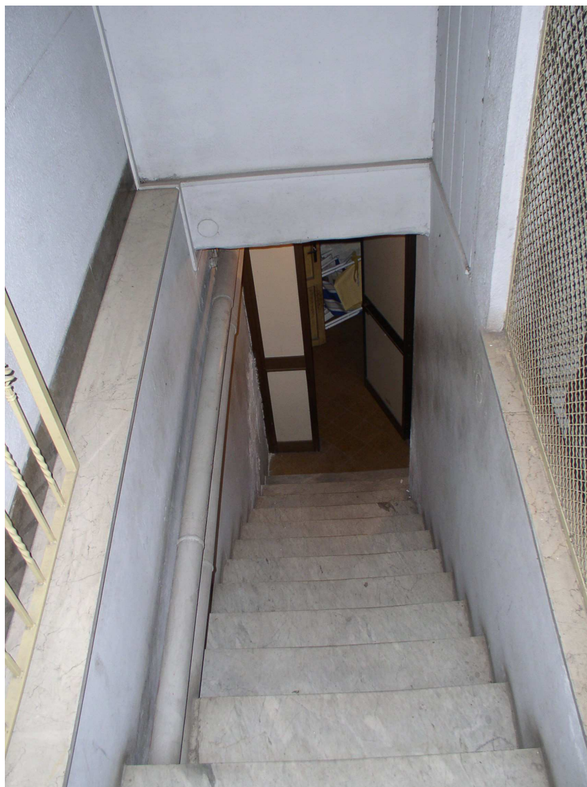
scala di accesso ai locali interrati
