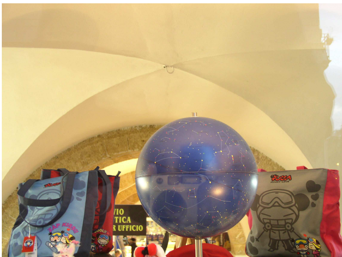
Locale interrato (particolare solai)
