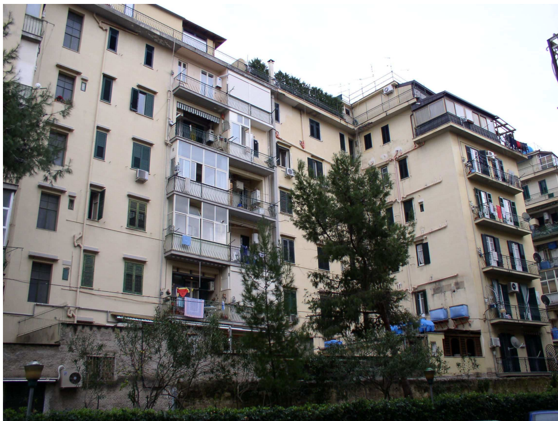
Prospetto su via A. Pecoraro
