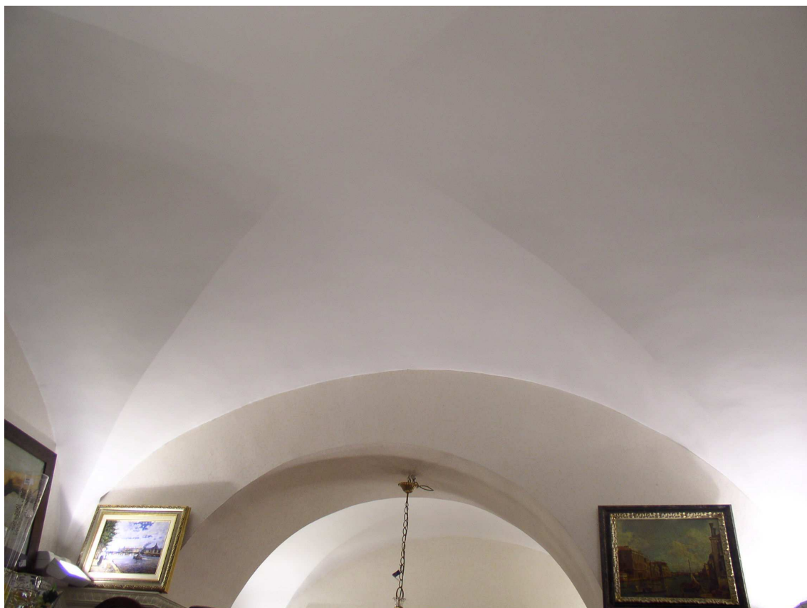
Locale interrato (particolare solaio a volte)
