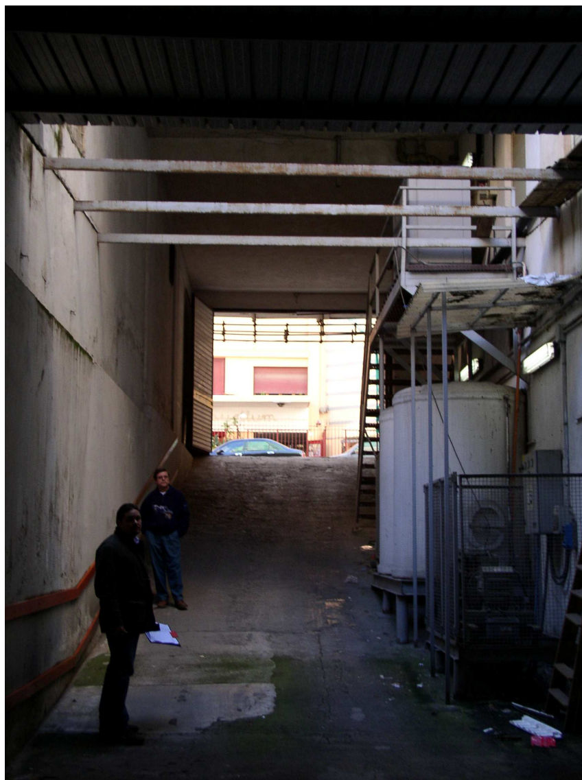
Ingresso da via Almeyda a servizio dei locali interrati dell'edificio I.19 e I.21
