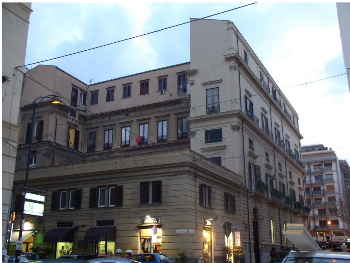
Retroprospetto di via Libertà e prospetto laterale su via G. Daita
