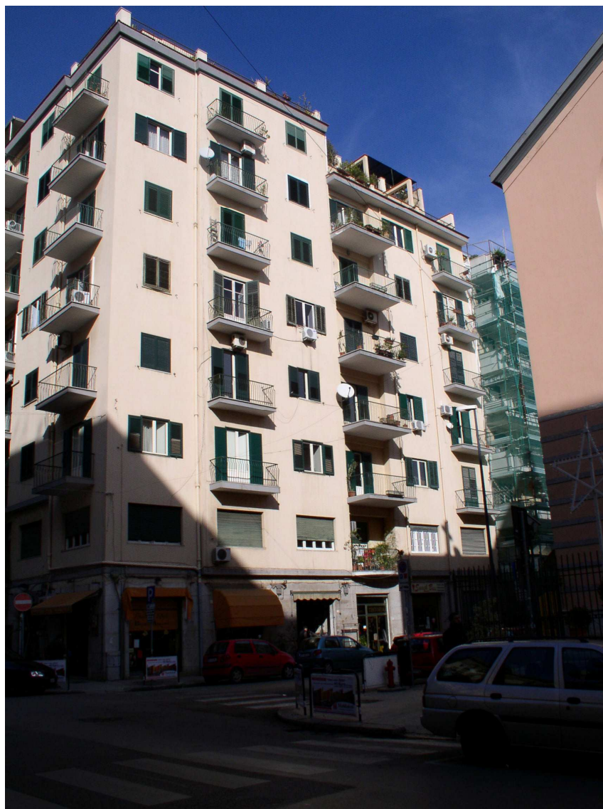
Prospetto su via Almeyda
