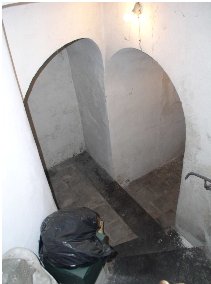
Scale di accesso al primo seminterrato
