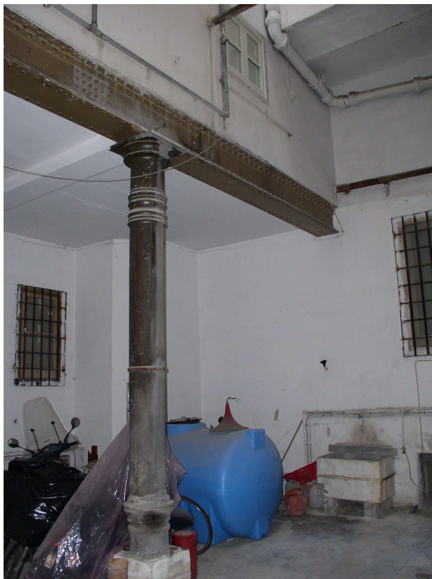
Trave e pilastro in ferro a rinforzo della struttura sovrastante
