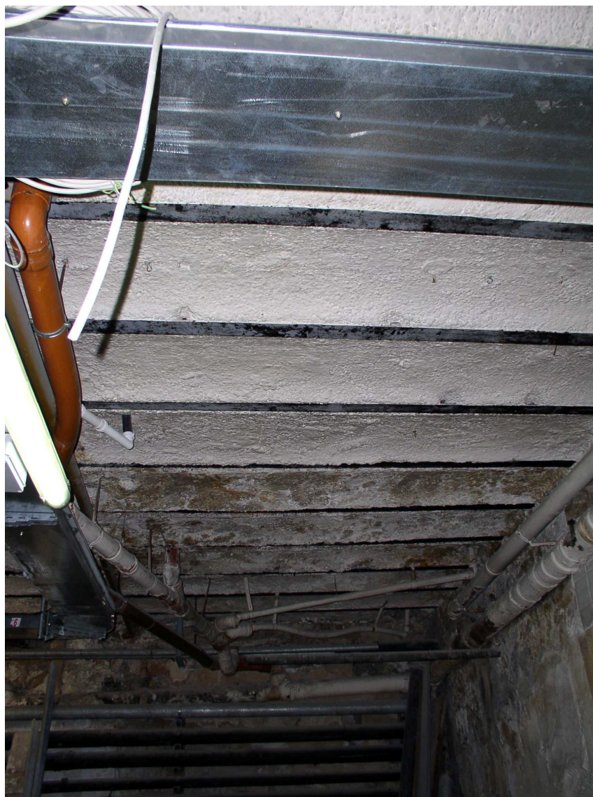
Solaio locale interrato
