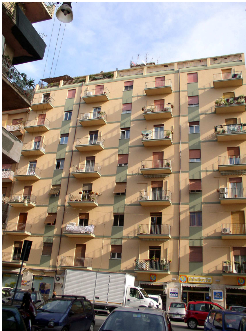
Prospetto su via Generale Di Maria
