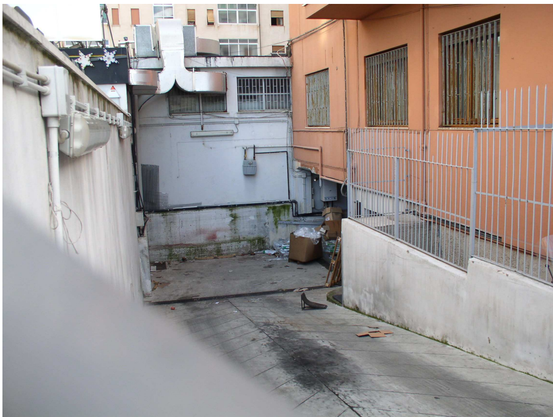
Ingresso da via Generale Di Maria ai locali interrati
