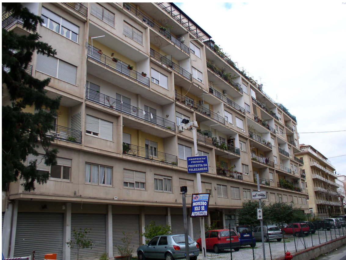
Prospetto su via A. Pecoraro
