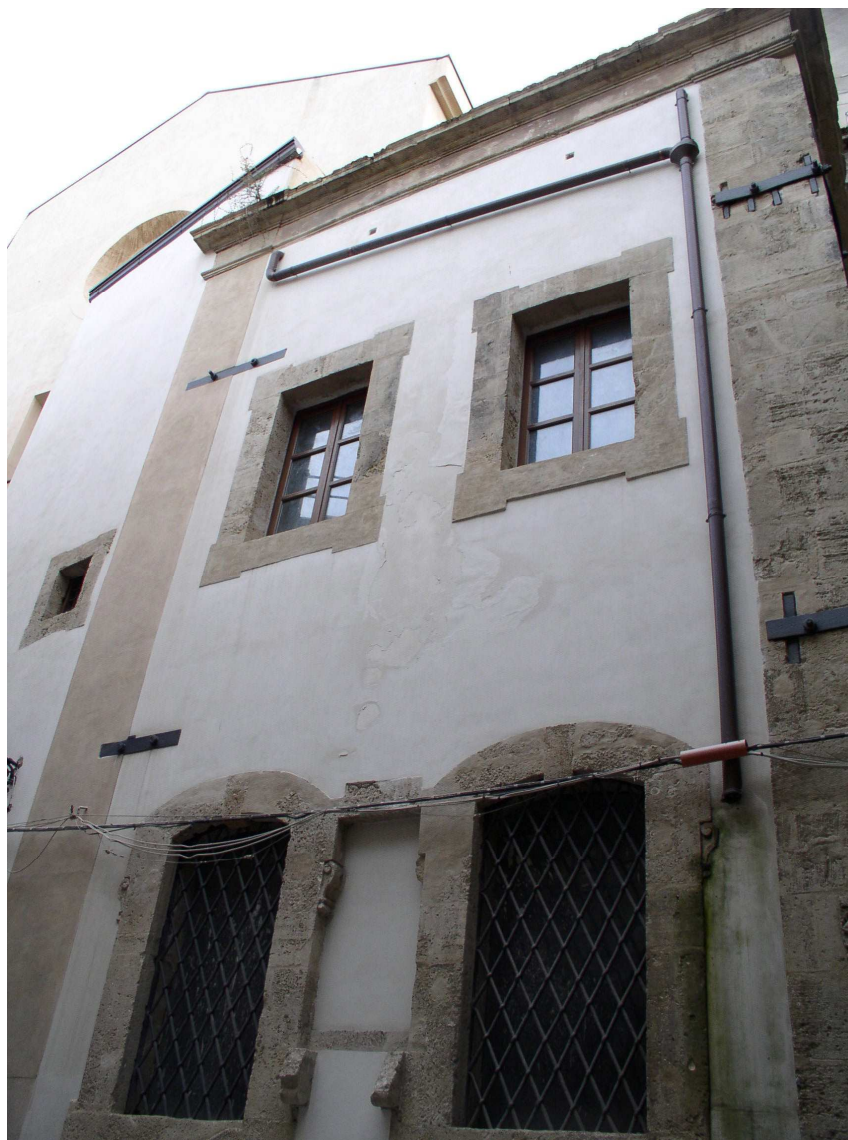
Prospetto su vicolo I° Appalto
