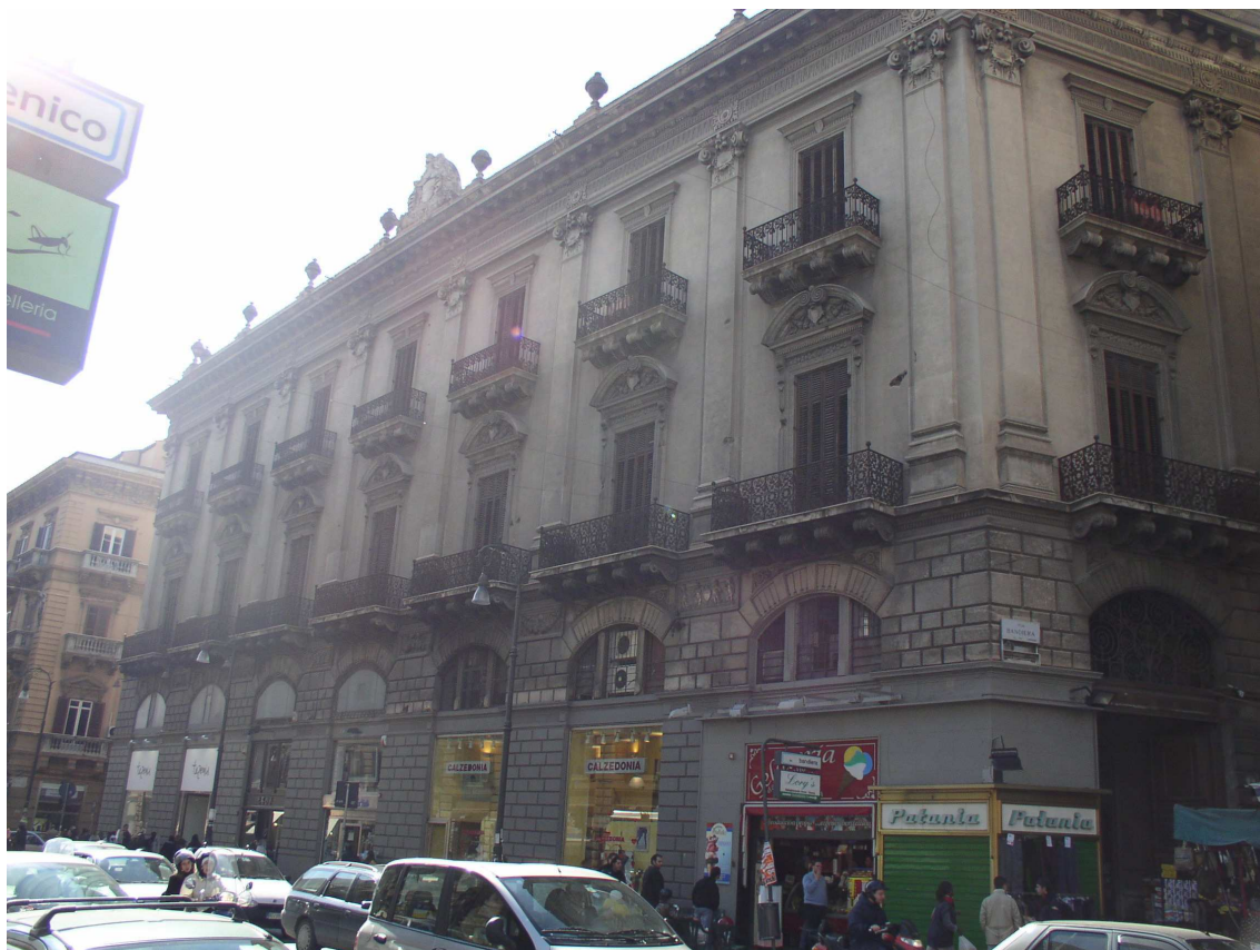
Prospetto su via Roma
