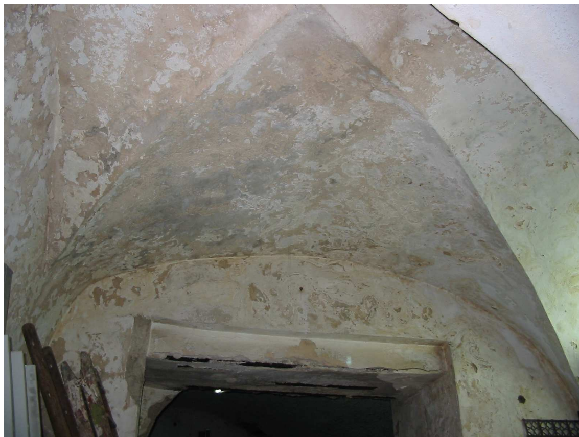
Piano terra (particolare del solaio a volta)
