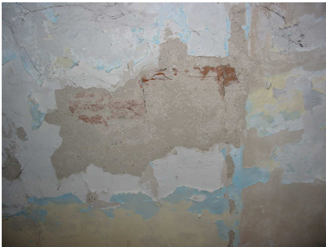
Piano terra (particolare del solaio in latero-cemento)
