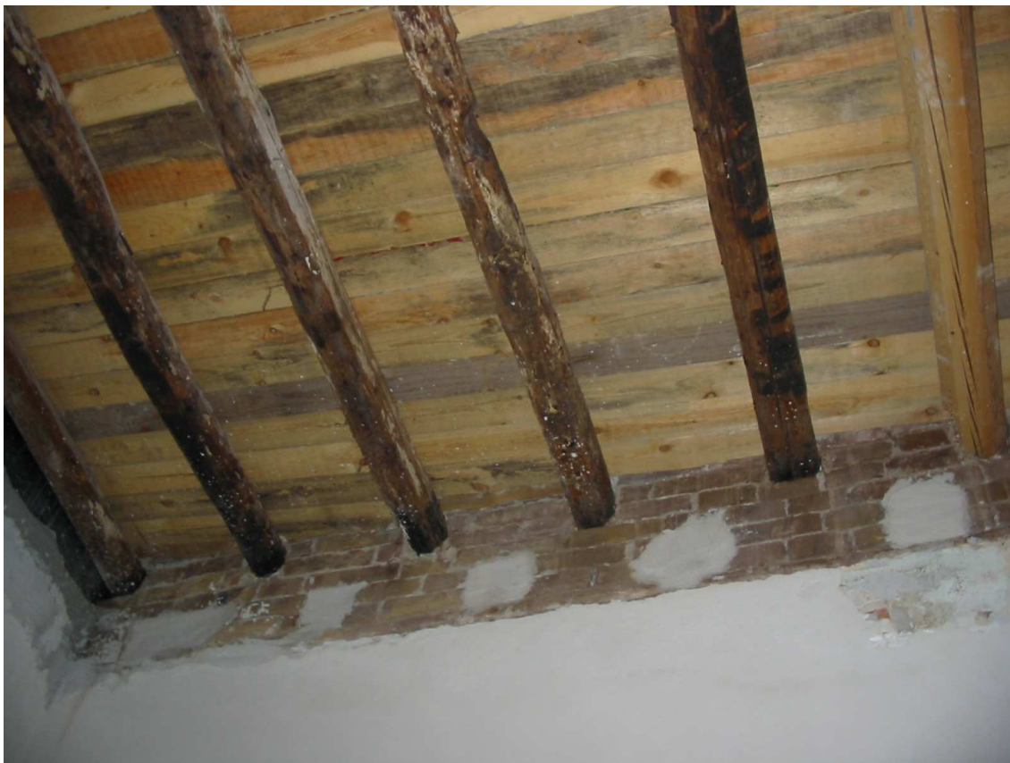
Primo piano (particolare del solaio in legno)
