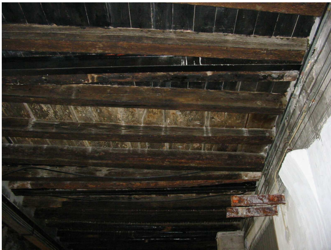
Piano terra (particolare del solaio in legno)
