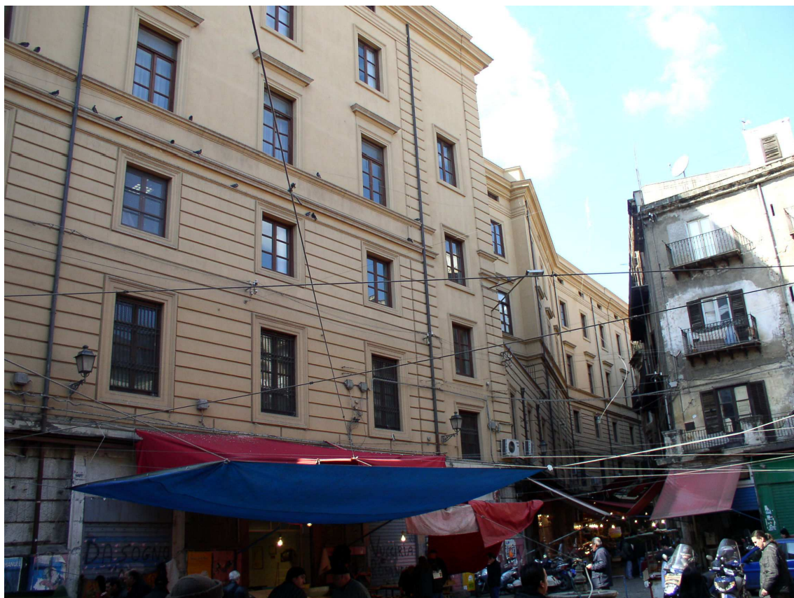
Prospetto su via dei Maccheronai
