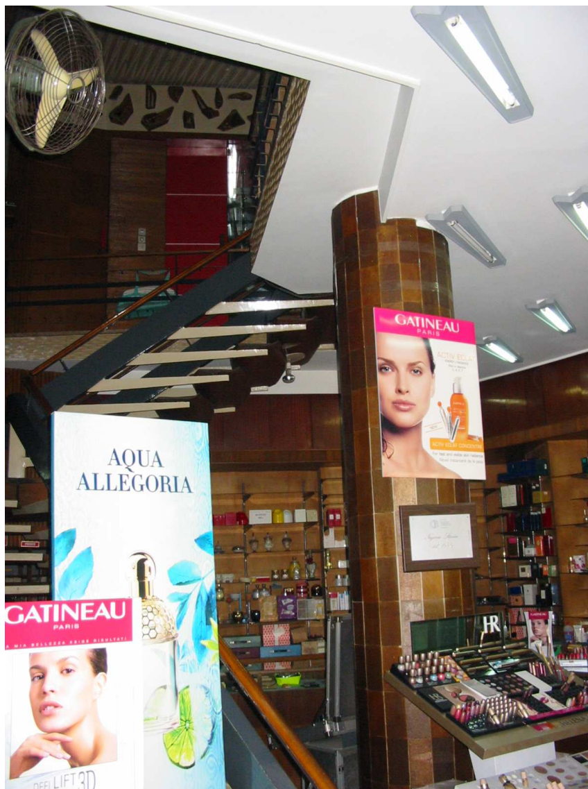
Piano terra (particolare della struttura in c.a.)
