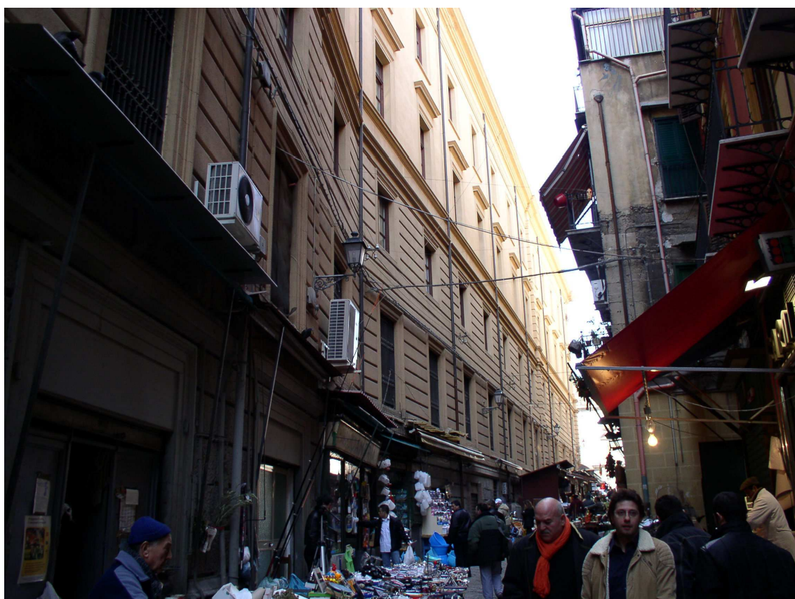
Prospetto su via dei Maccheronai
