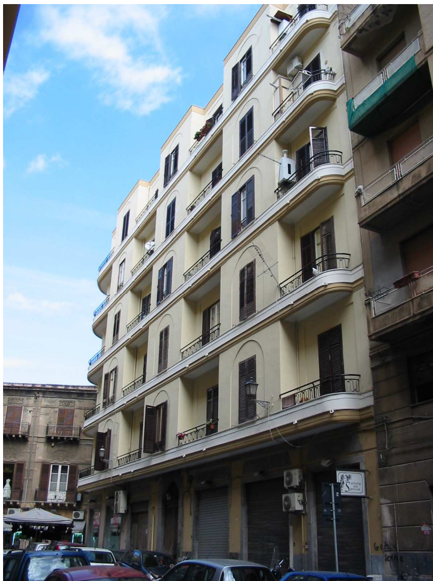
Prospetto su via Borzì
