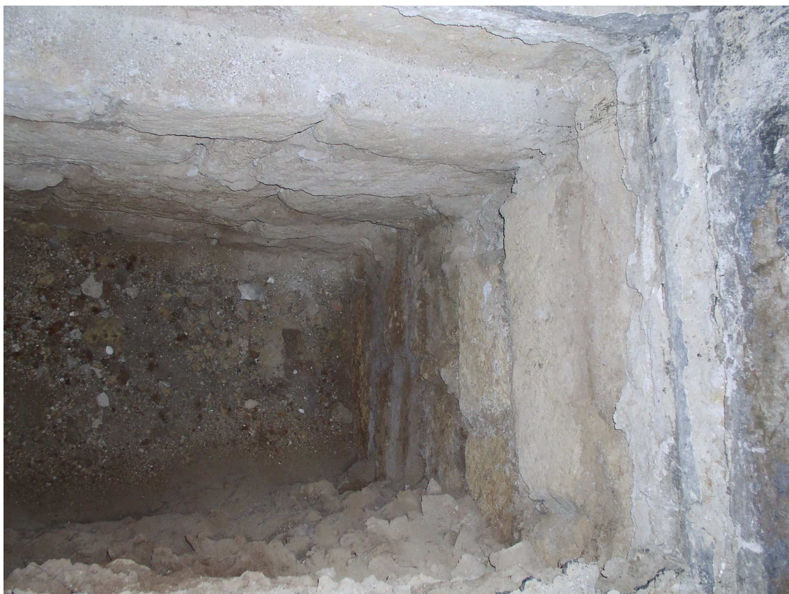
Pozzetto geognostico delle fondazioni
