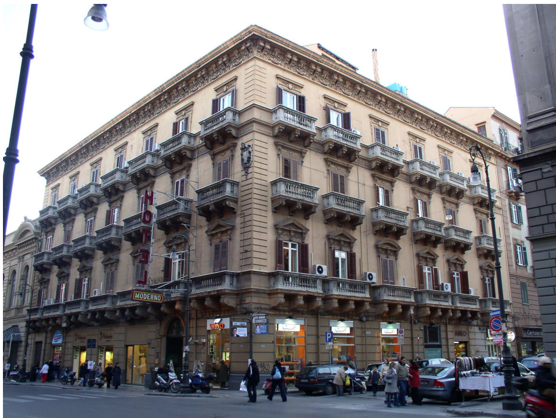
Prospetto su via Roma e su via Napoli
