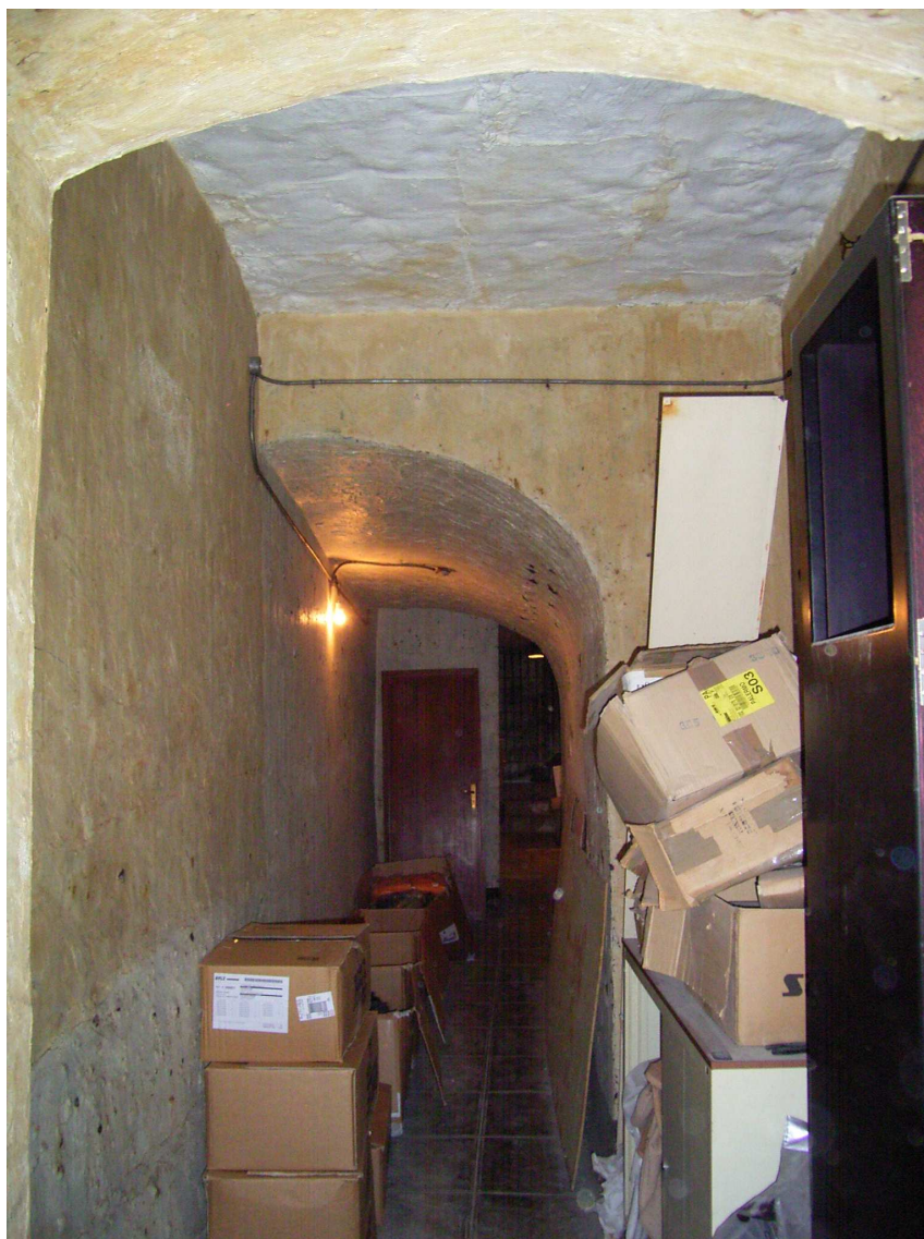
Ingresso locali interrati
