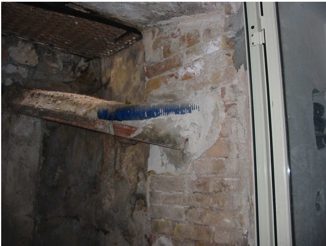
Piano cantinato (particolare della muratura esterna)
