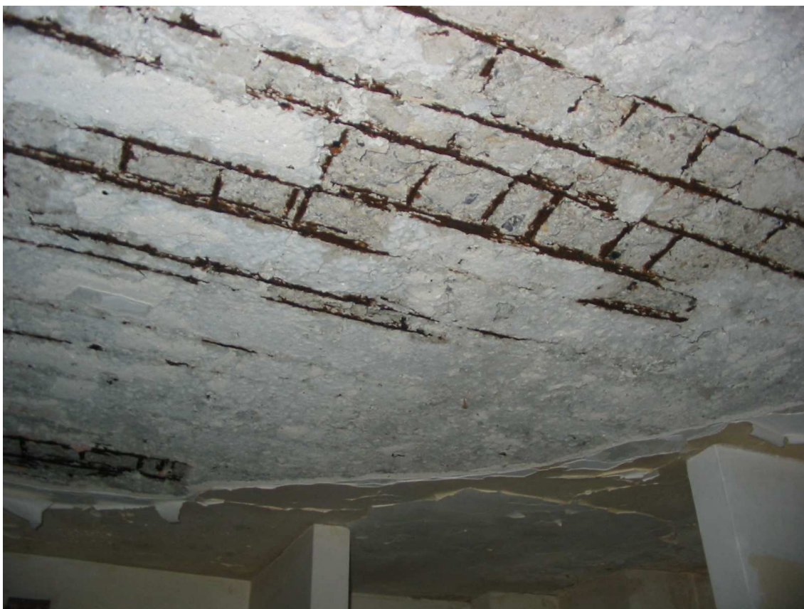
Piano cantinato (particolare del solaio)
