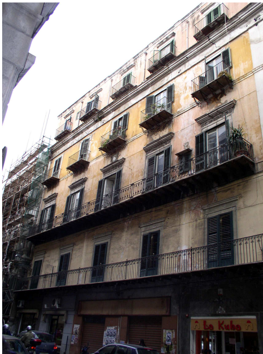
Prospetto su Corso Vittorio Emanuele
