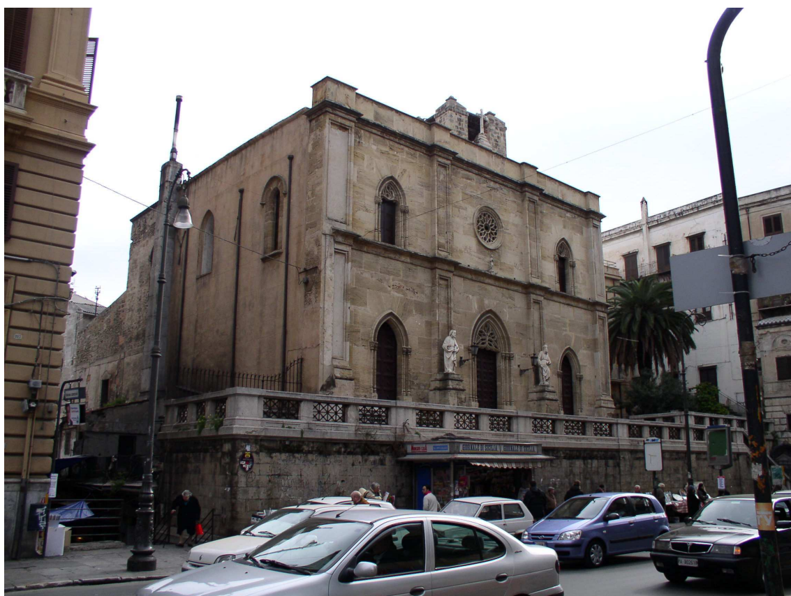
Prospetto su via Roma
