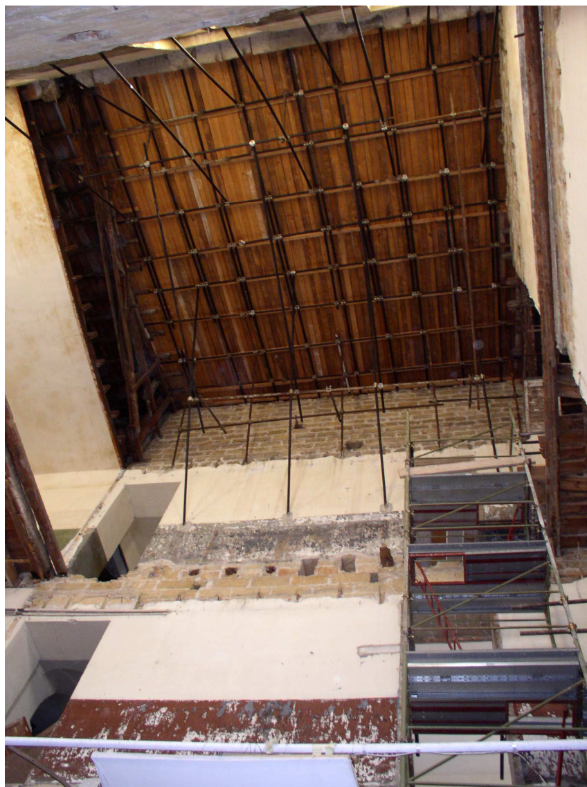
Vista dal piano terra dei vani sovrastanti
