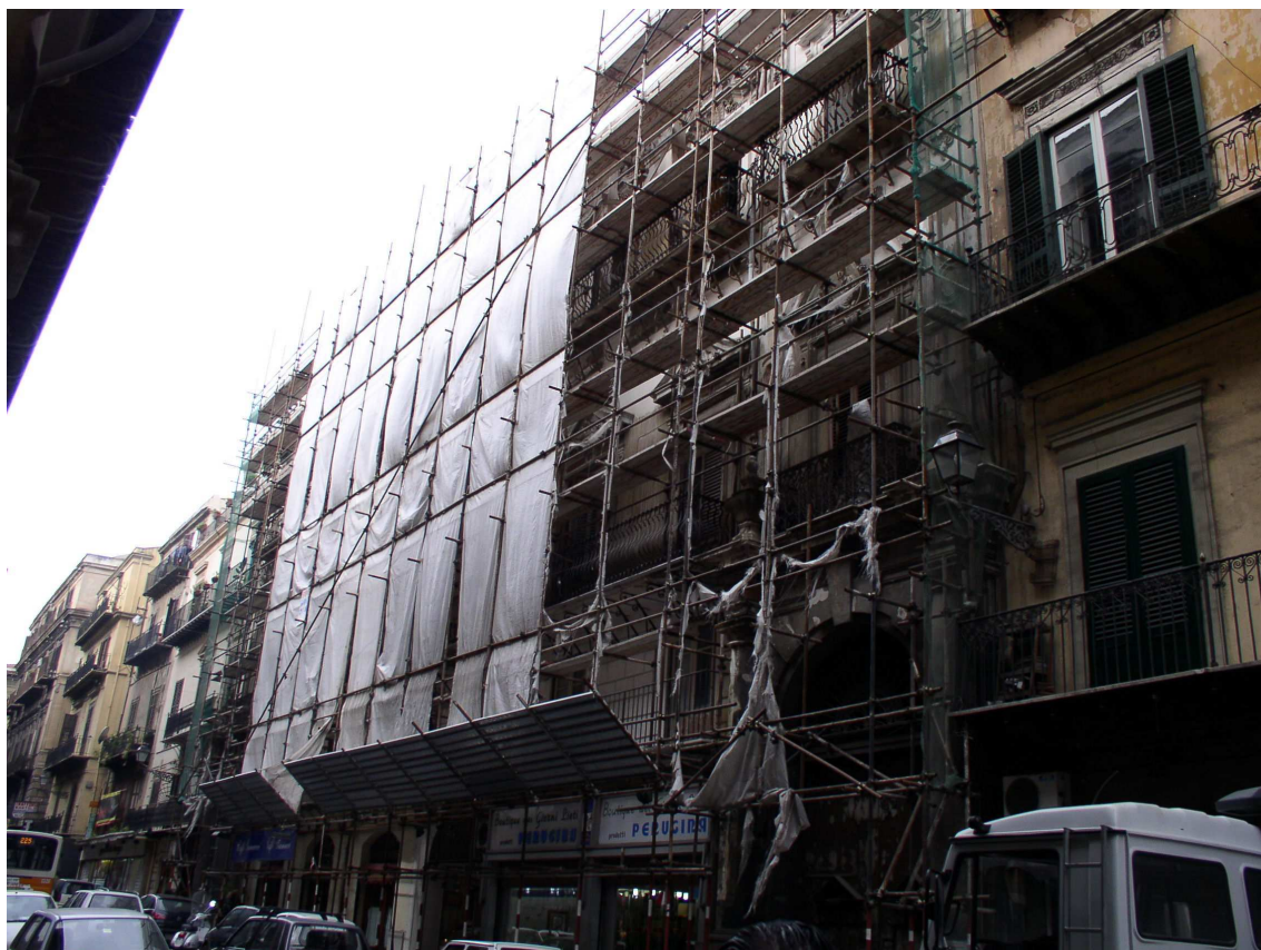
Prospetto su Corso Vittorio Emanuele
