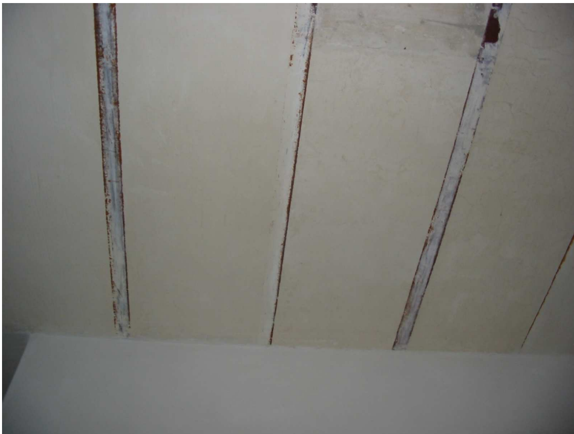
Piano terra (particolare del solaio in ferro e tavelloni)
