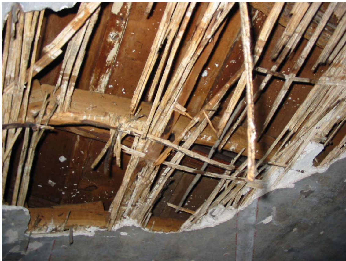
Primo piano (particolare del solaio)
