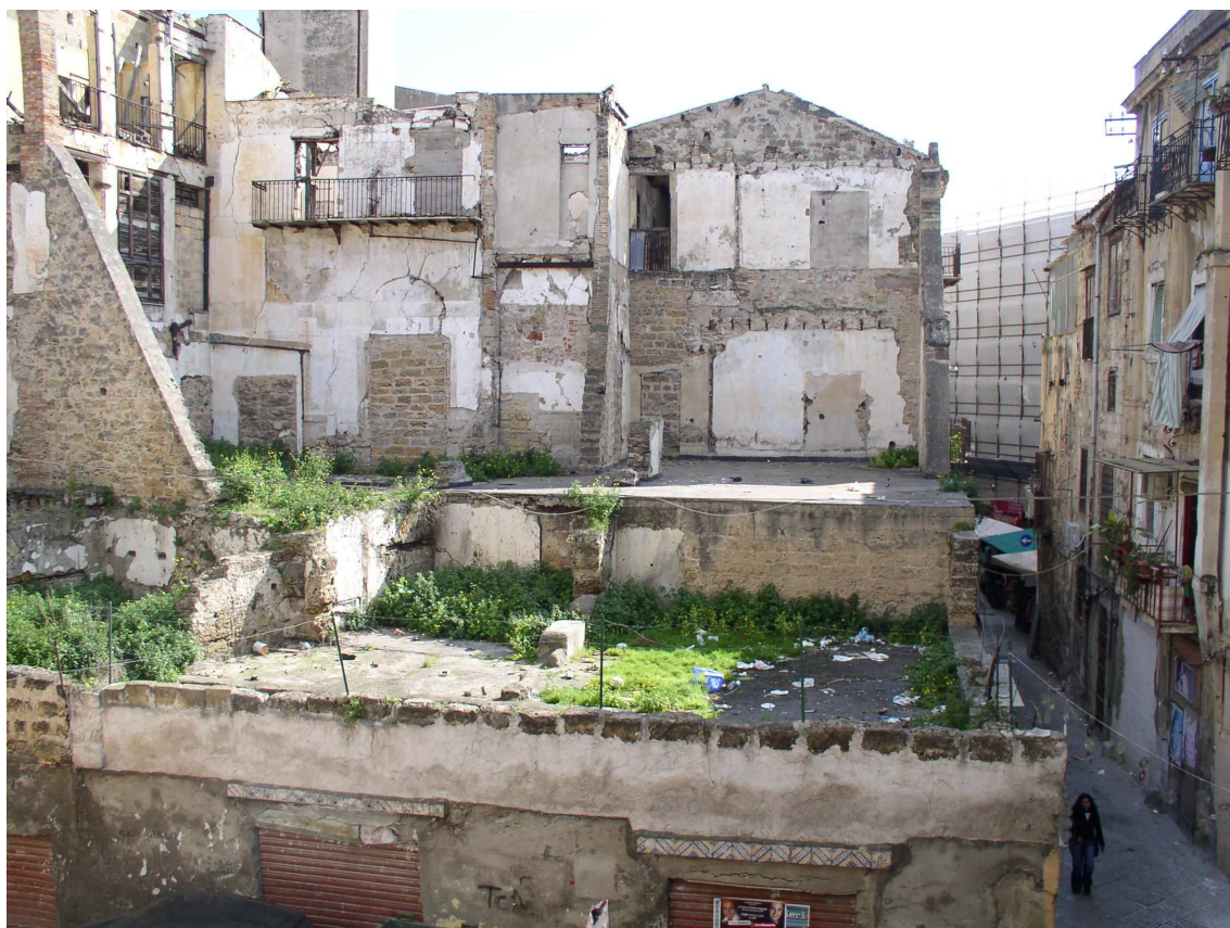
Vista dall'alto dei resti dell'immobile
