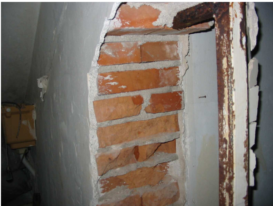
Piano cantinato (particolare della muratura)
