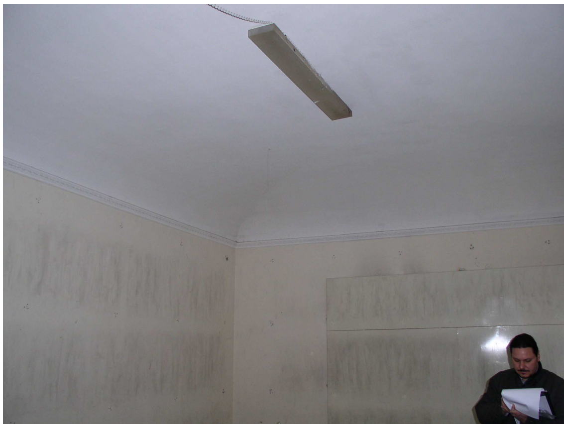
Volta piano ammezzato
