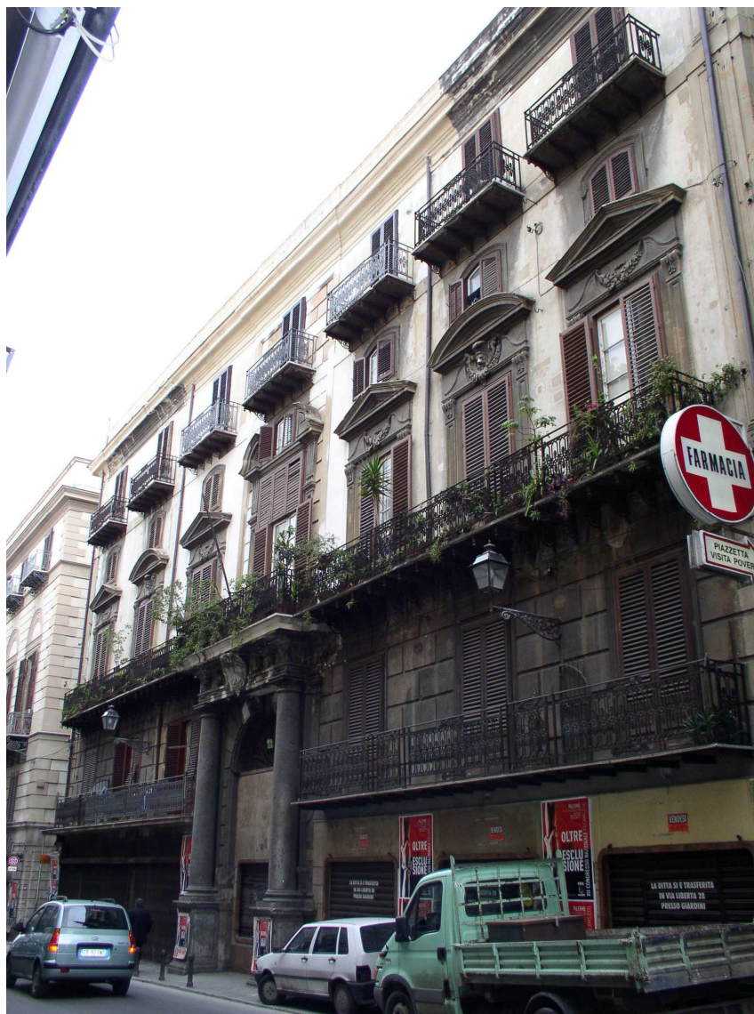
Prospetto su Corso Vittorio Emanuele
