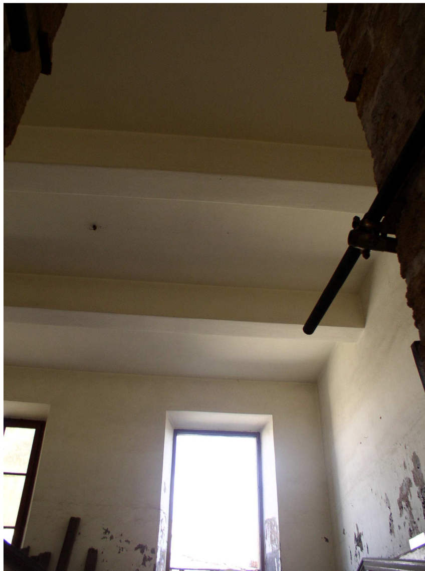
Travi in c.a. presenti nei locali del secondo piano
