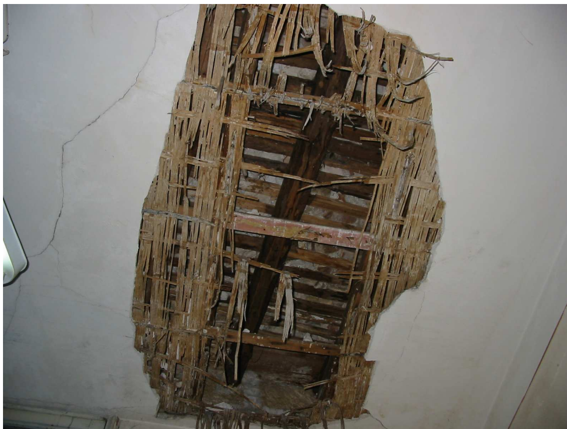
Primo piano (particolare del solaio ligneo)
