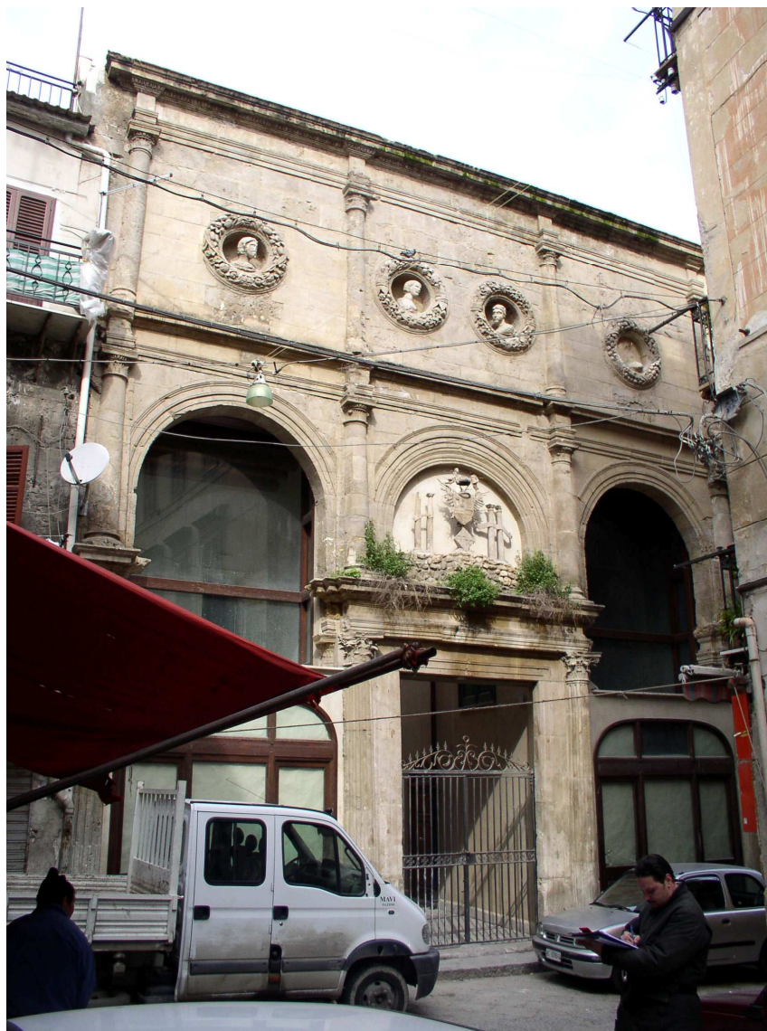
Prospetto del portale su Via Argenteria
