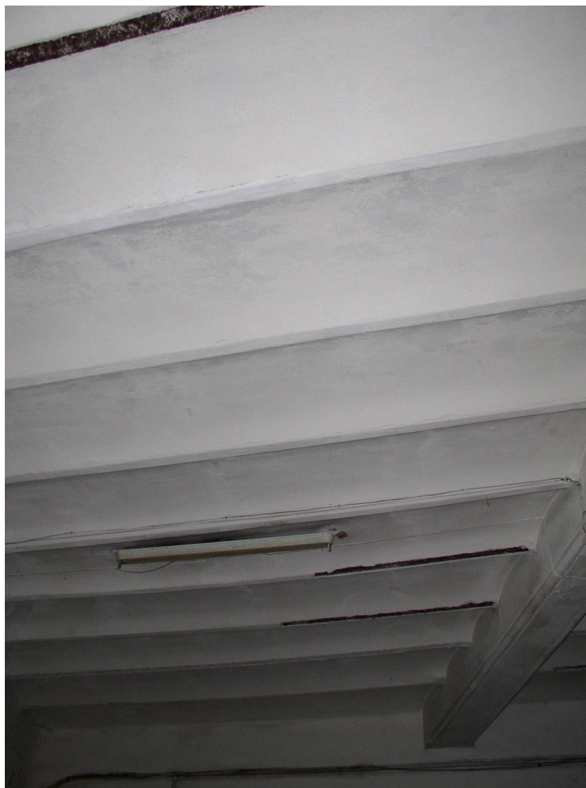
Solaio in ferro e laterizio al piano ammezzato
