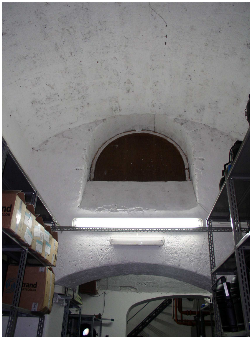
Locali interrati (utilizzati come magazzini)
