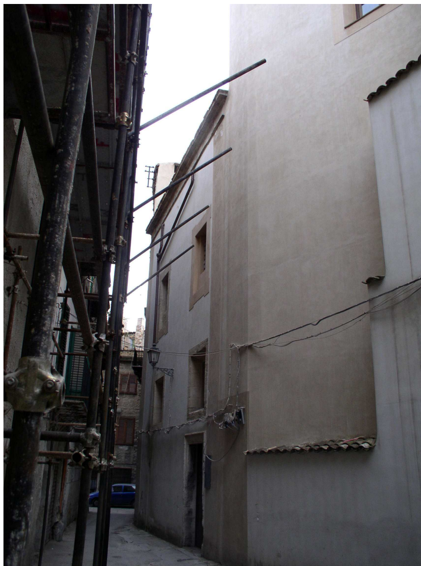
Prospetto su vicolo I° Appalto
