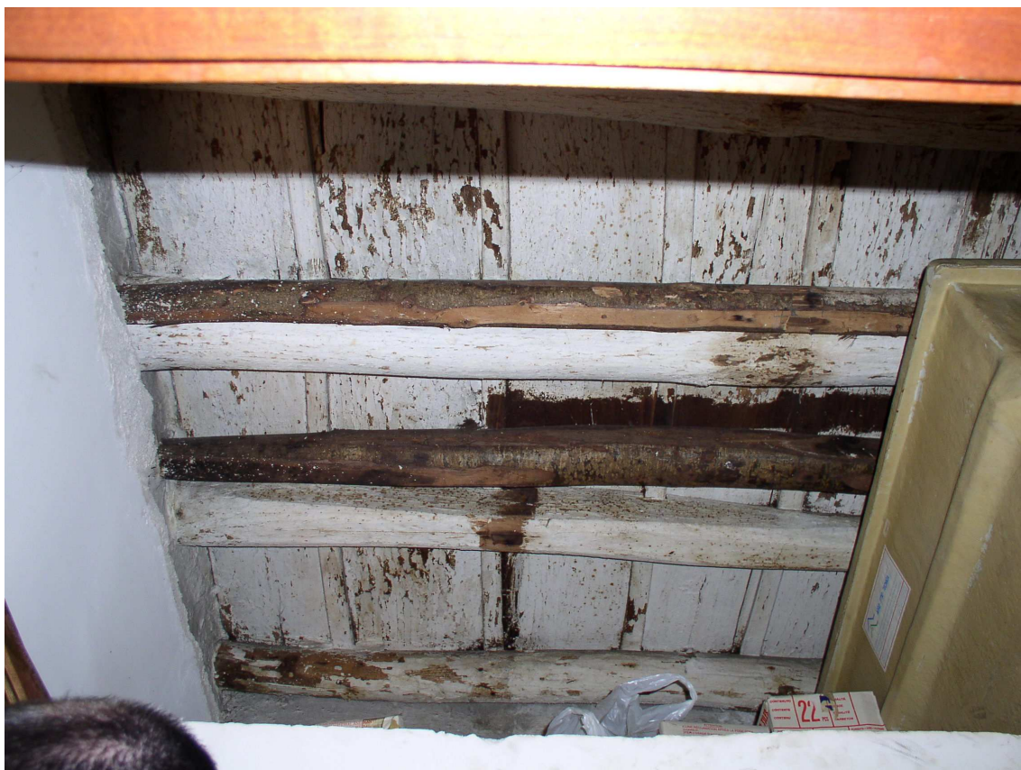
Solaio a piano terra
