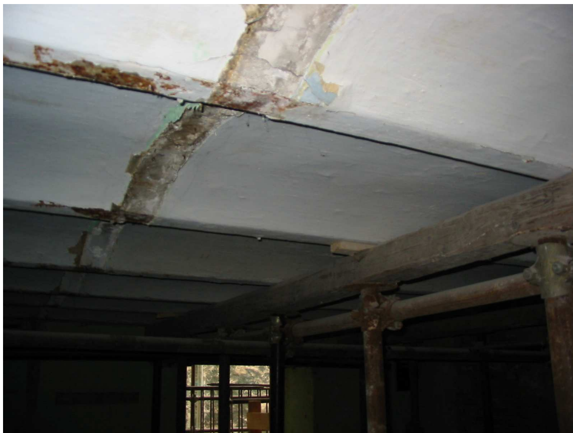
Particolare del solaio in ferro
