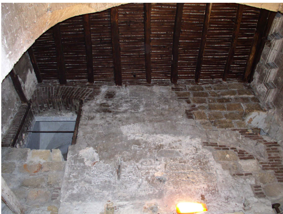
Solaio di piano terra
