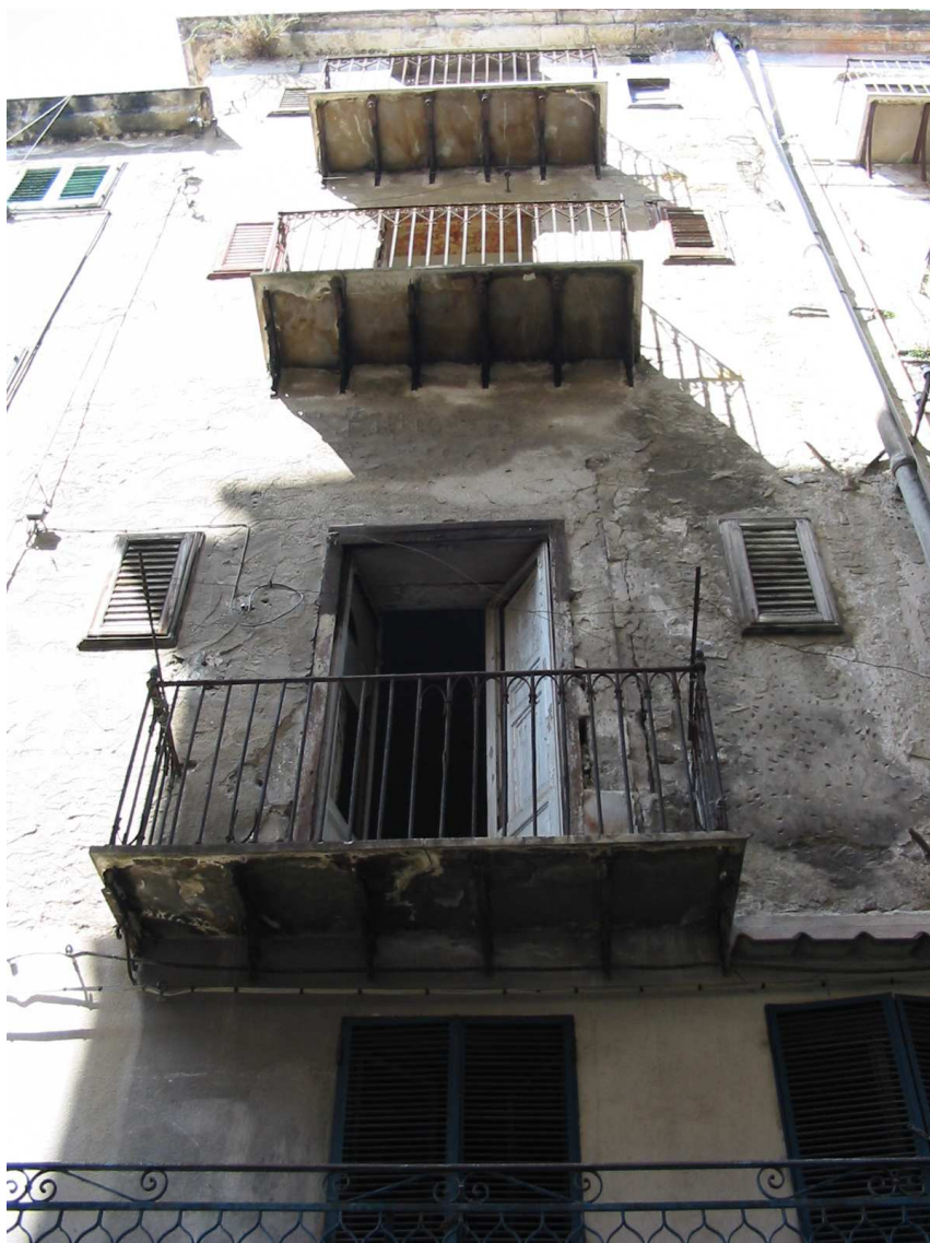
Prospetto su via Coltelleri
