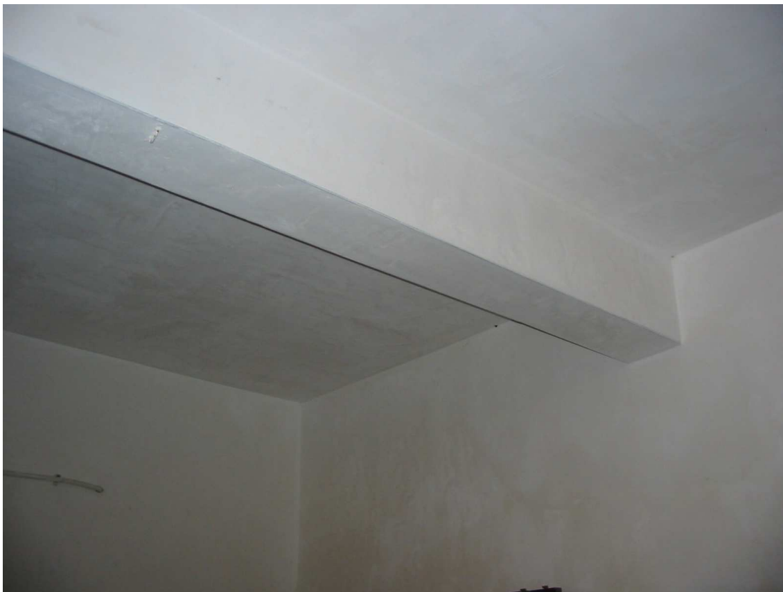
Piano cantinato (particolare del solaio)
