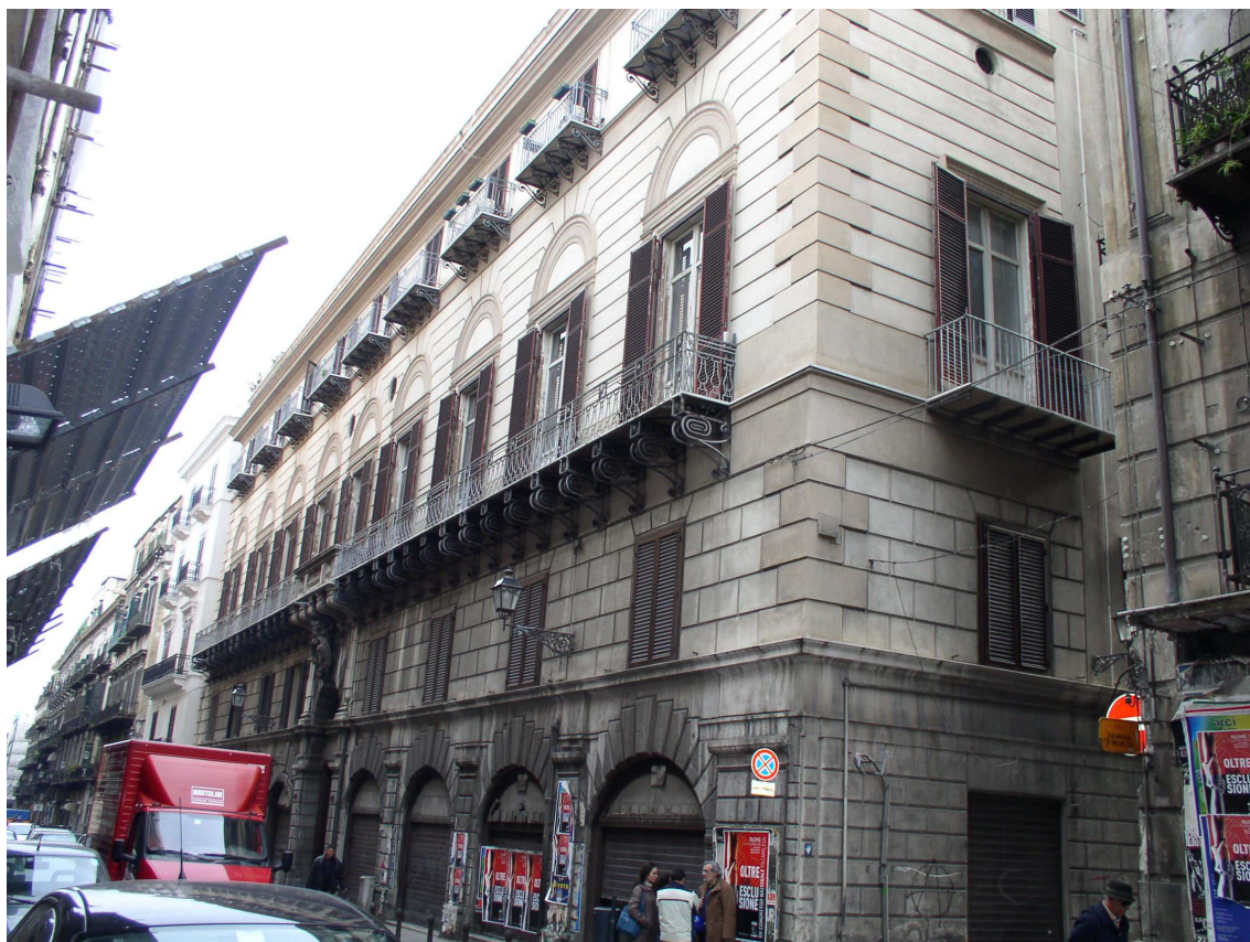
Prospetto su Corso Vittorio Emanuele
