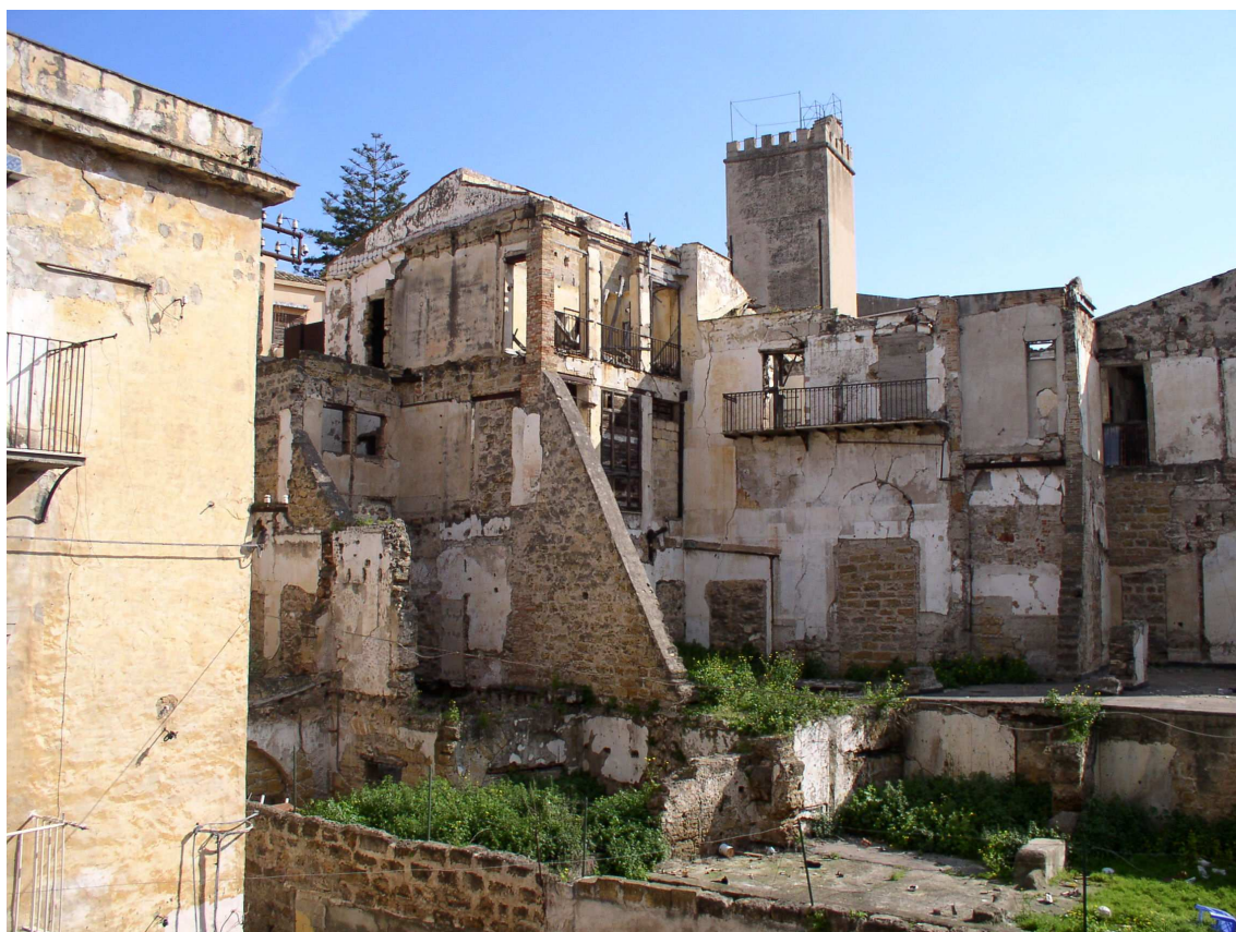
Vista dall'alto dei resti dell'immobile
