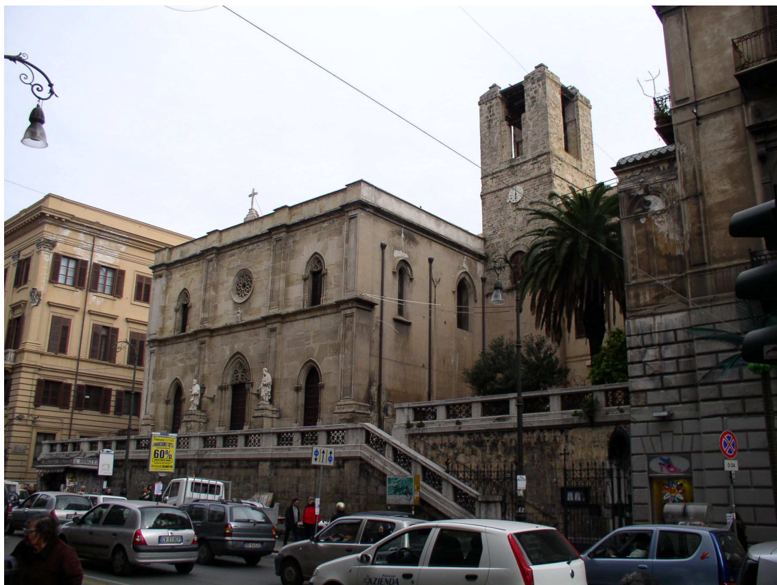
Prospetto su via Roma
