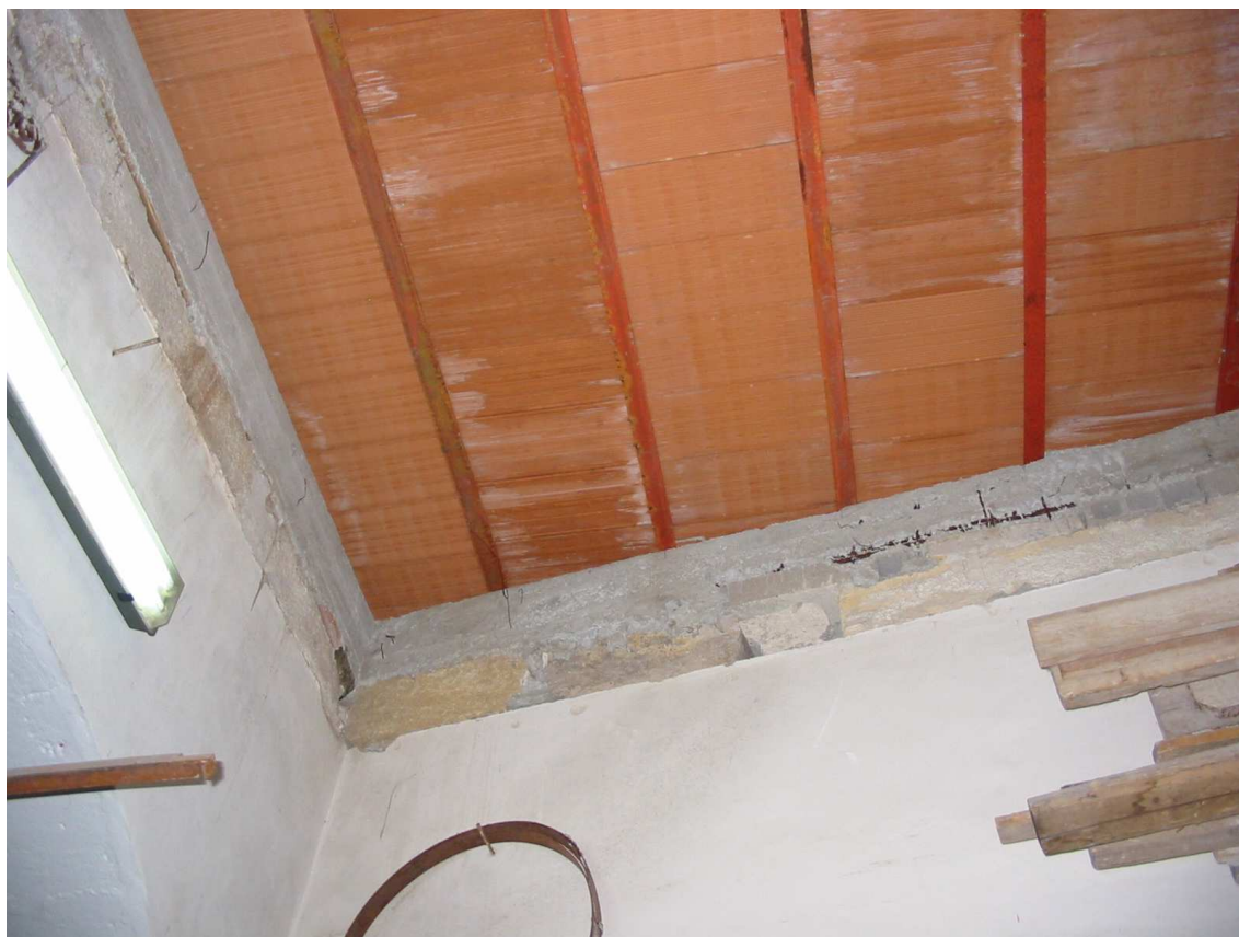
Particolare del solaio di copertura in ferro e laterizi
