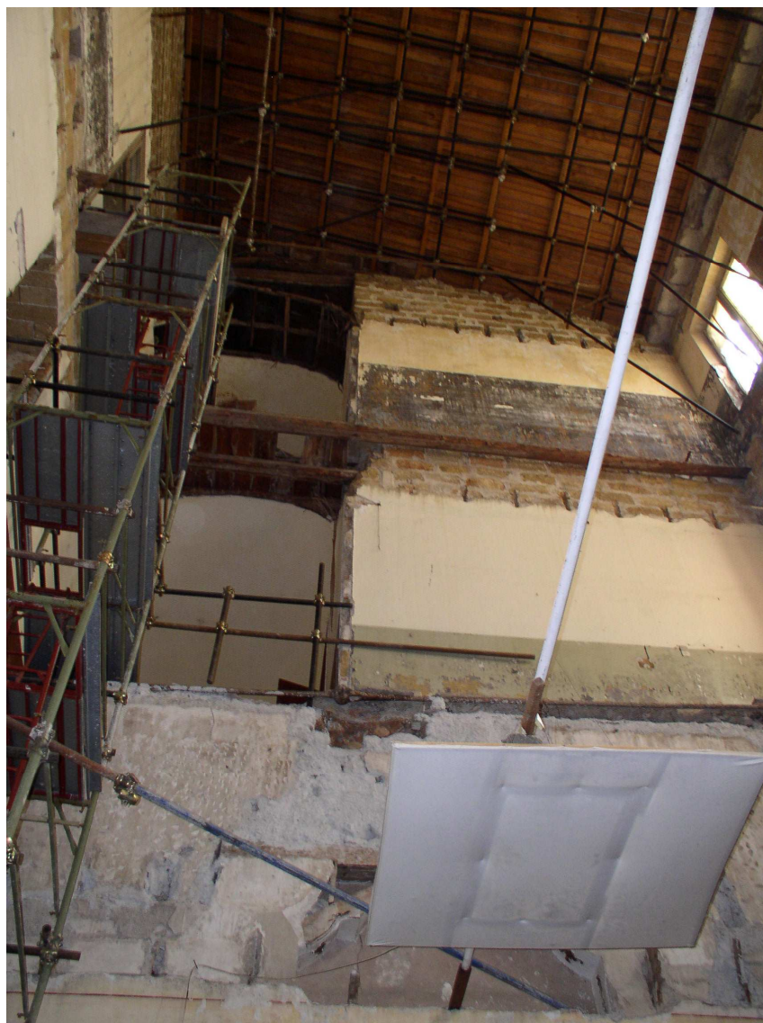
Vista dal piano terra dei vani sovrastanti
