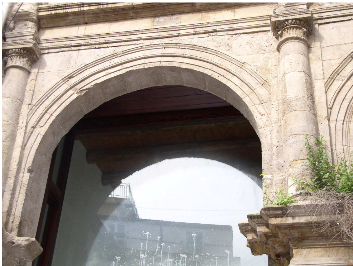
Solaio a primo piano
