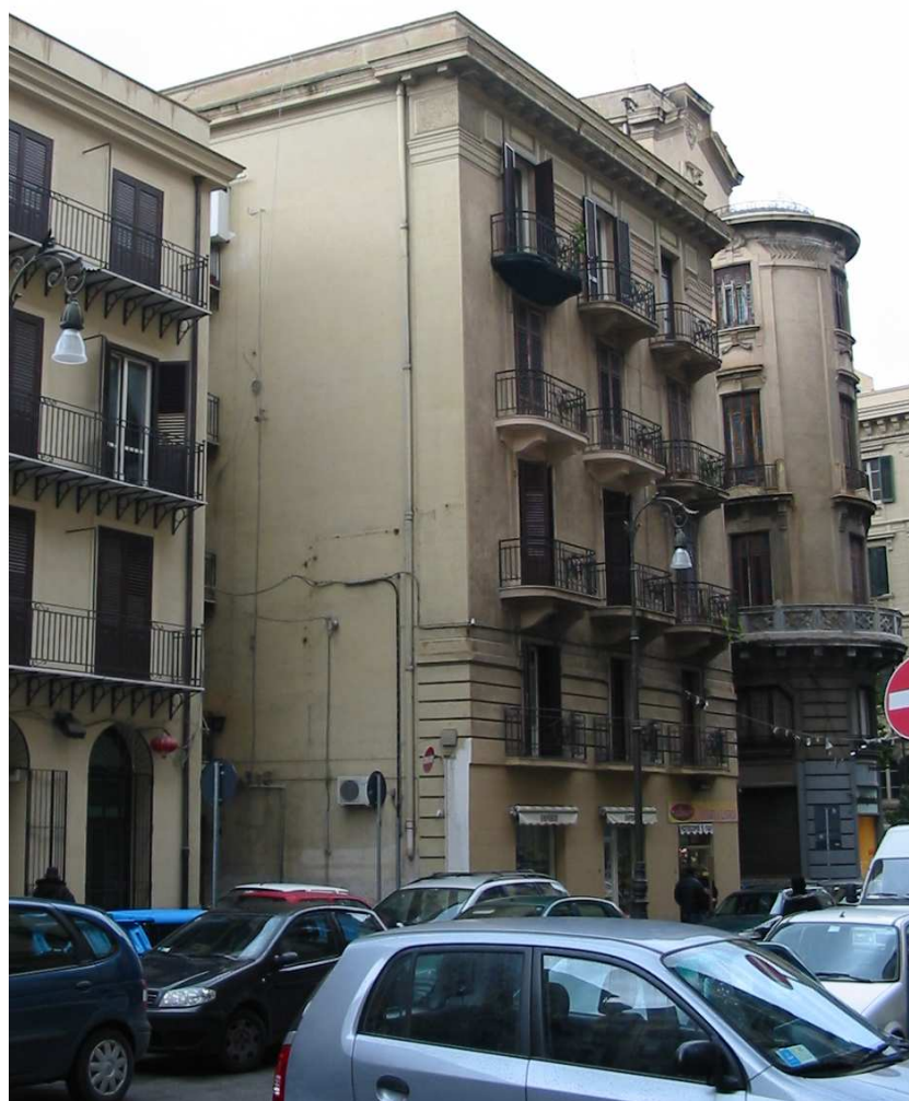
Prospetto su via Torino
