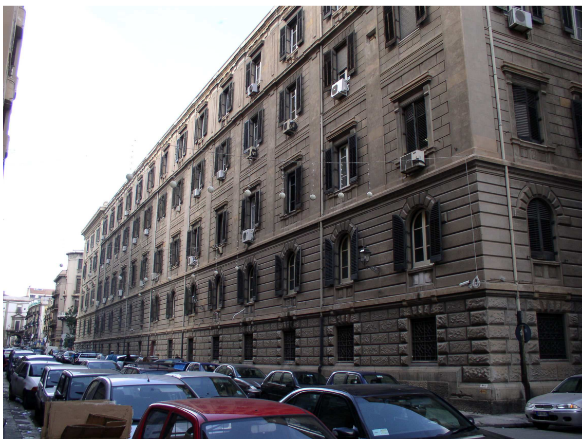
Prospetto su via Milano
