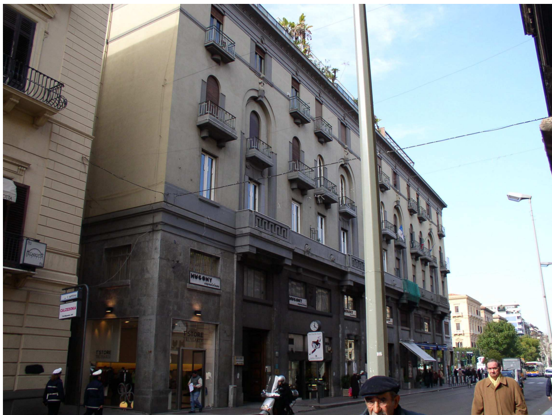
Prospetto su via R. Settimo
