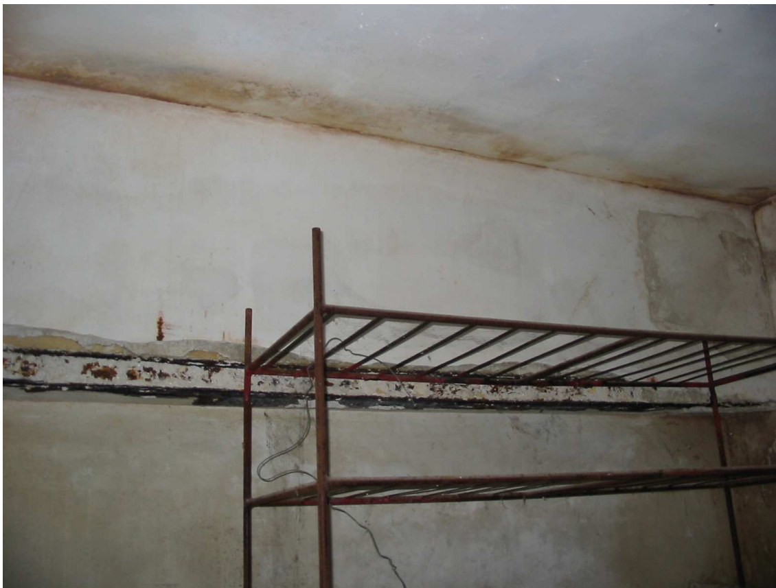
Piano cantinato (particolare di una trave in c.a.)
