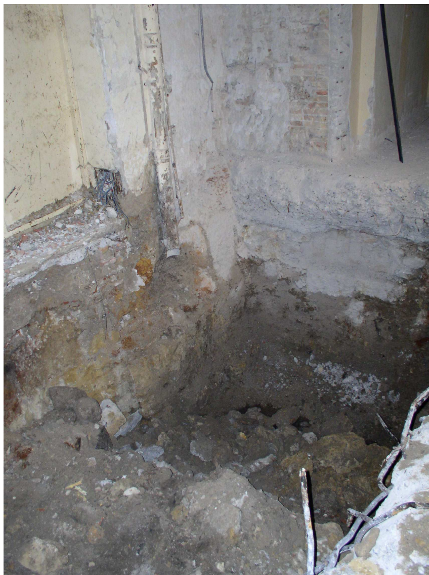
Pozzetto geognostico in prossimità delle fondazioni
