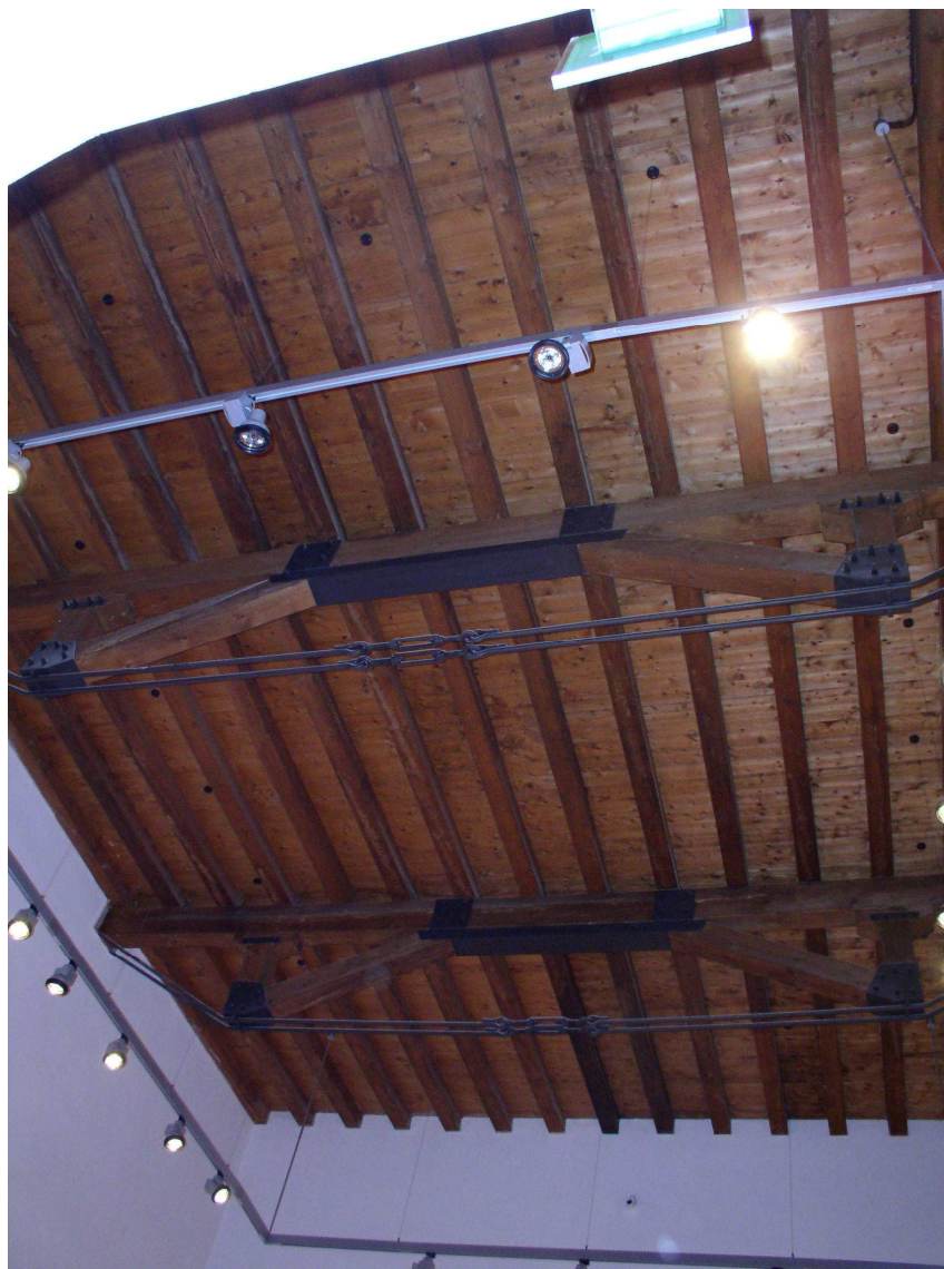
Intradosso del solaio ligneo a piano terra
