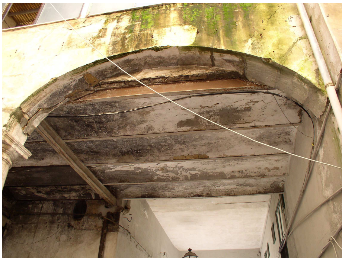
Solaio in ferro e voltine di mattoni
