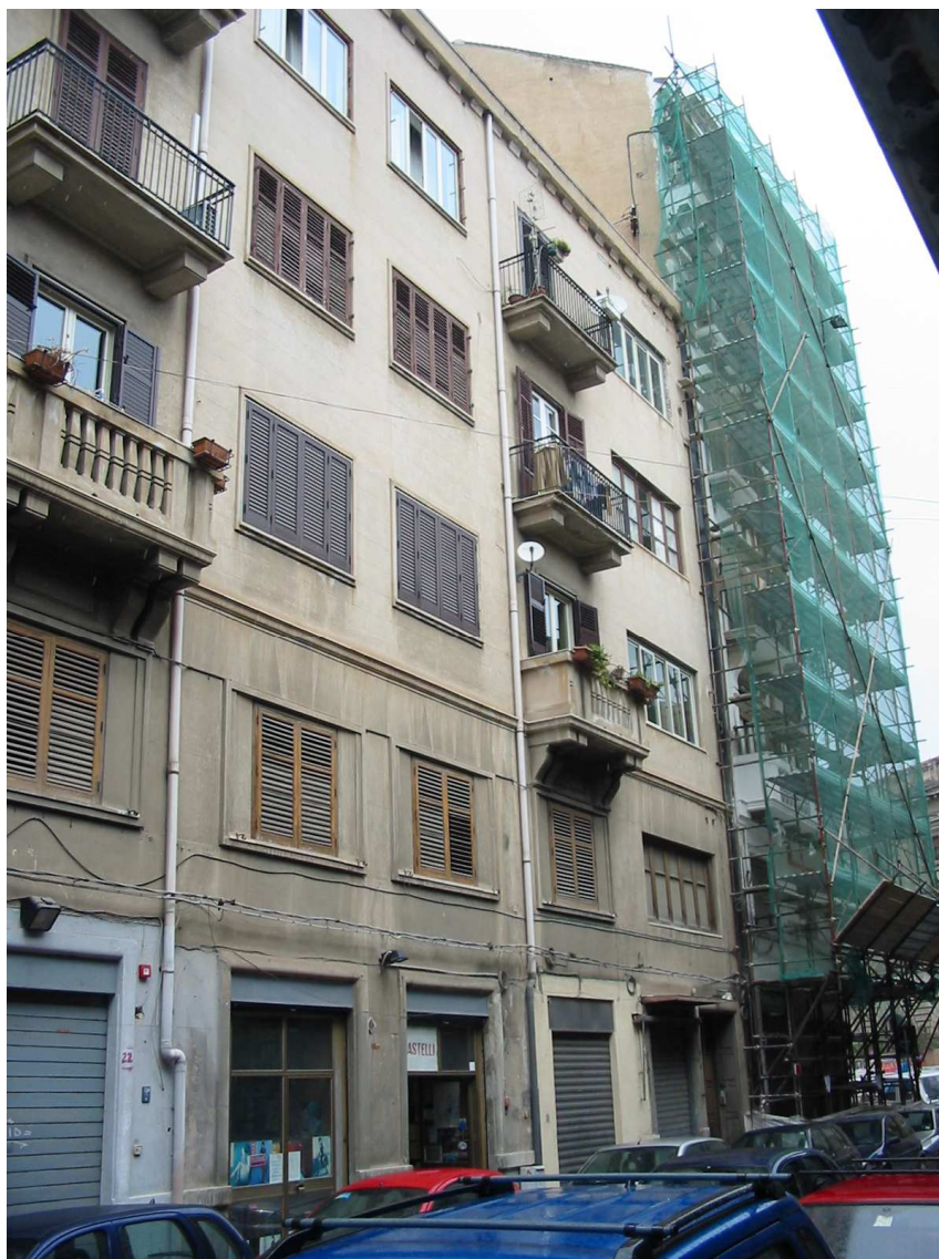
Prospetto su via Lattarini Grande
