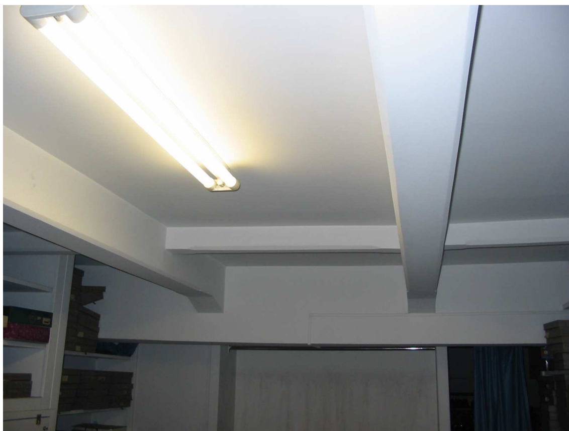
Piano terra (particolare del solaio)
