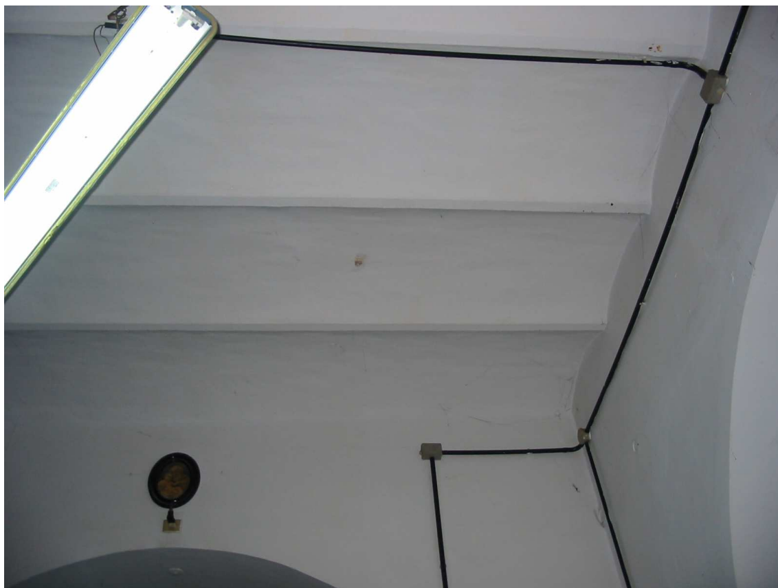
Piano terra (particolare del solaio)
