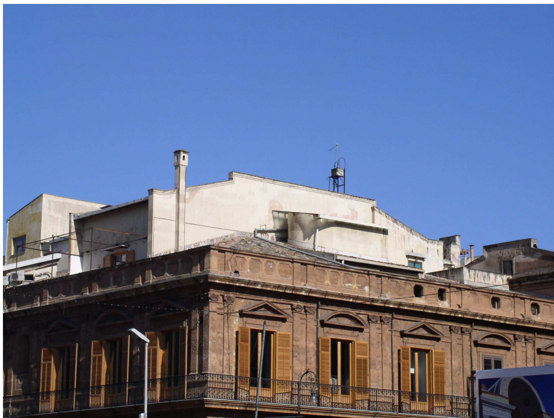
Corpo aggiuntivo (sopraelevazione)
