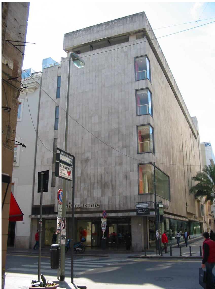
Prospetto su via Ruggero Settimo
