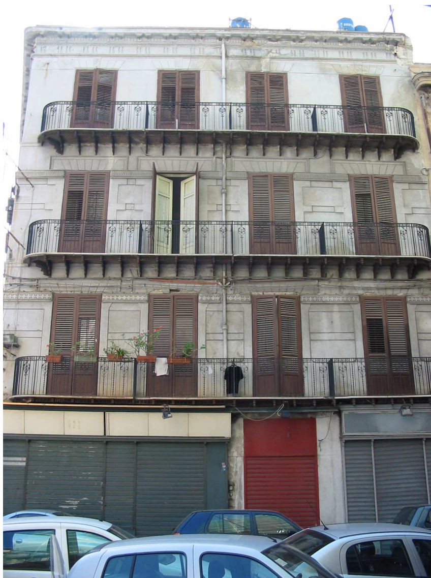
Prospetto su via Lattarini Grande
