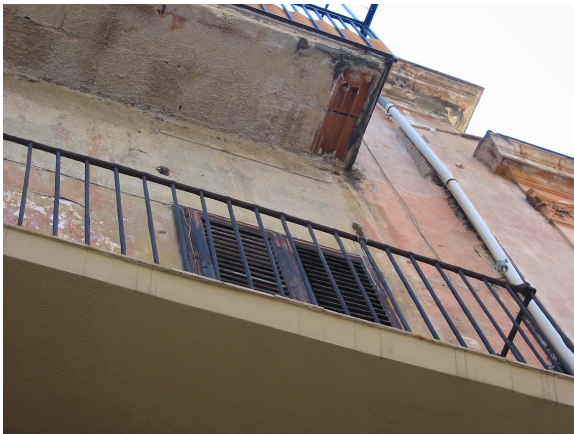
Particolare dei balconi latero-cementizi
