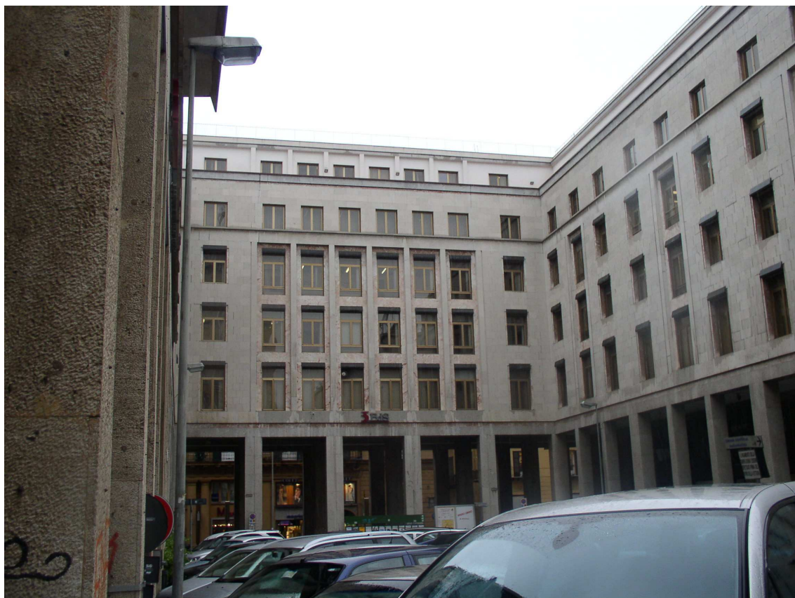
Retroprospetto su Piazzale Ungheria
