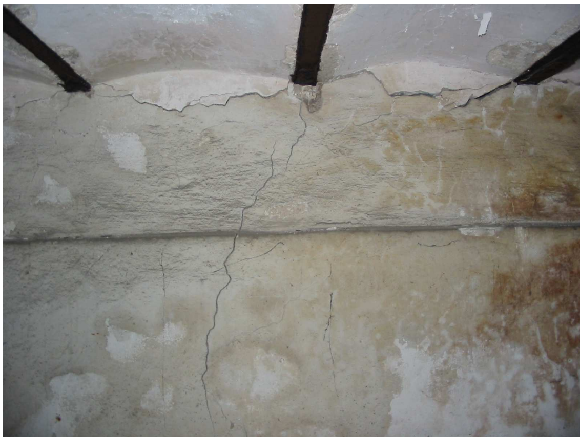
Piano cantinato (particolare del solaio in ferro e voltine)
