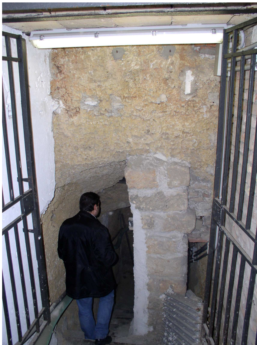
Accesso ai locali interrati
