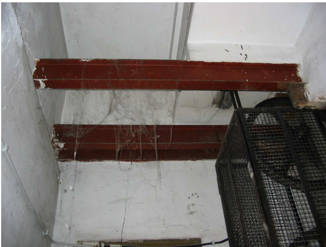
Locale ascensore (particolare di travi in acciaio)
