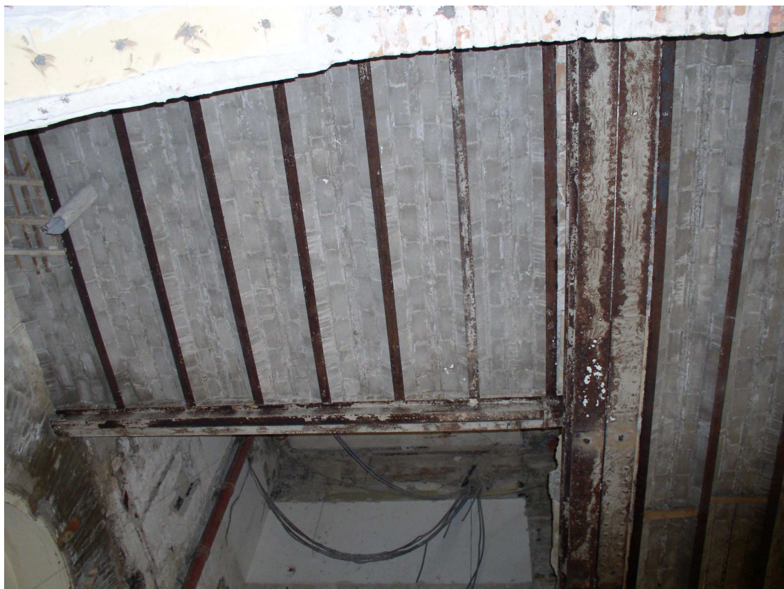
Solaio in ferro e voltine di mattoni
