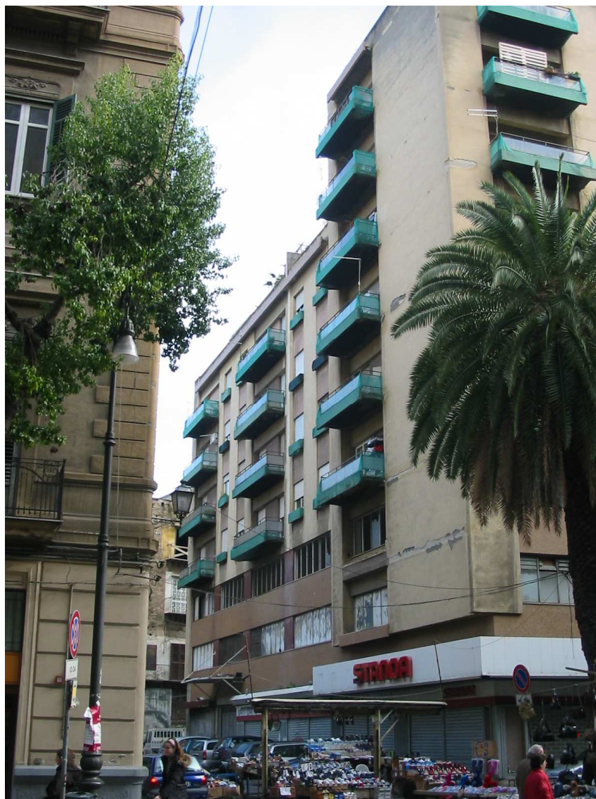
Prospetto su via Divisi
