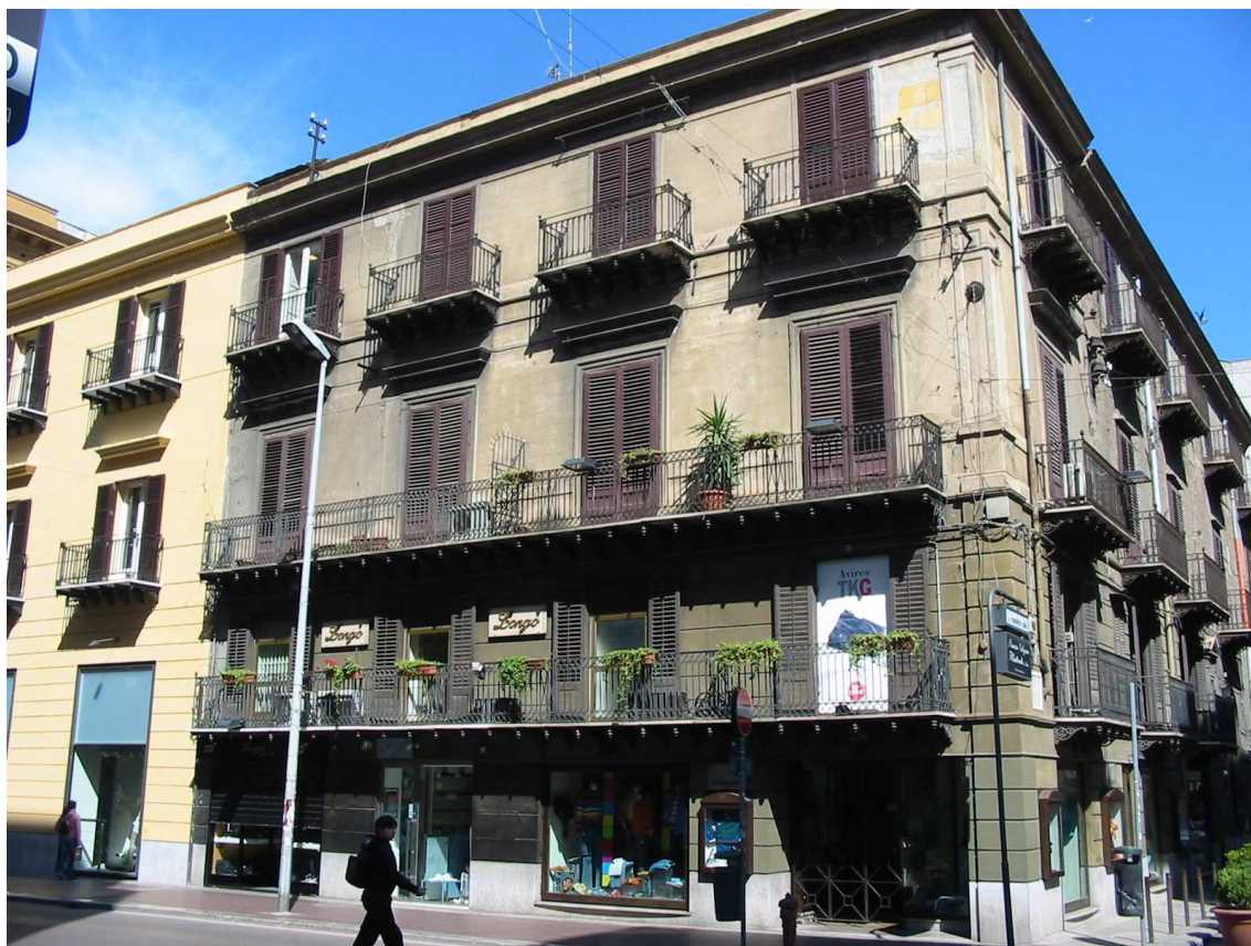
Prospetto su via Ruggero Settimo
