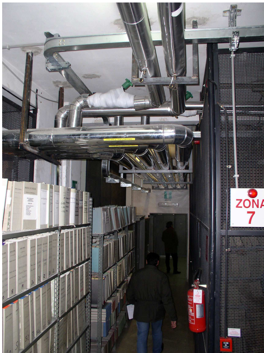
Locali del primo seminterrato
