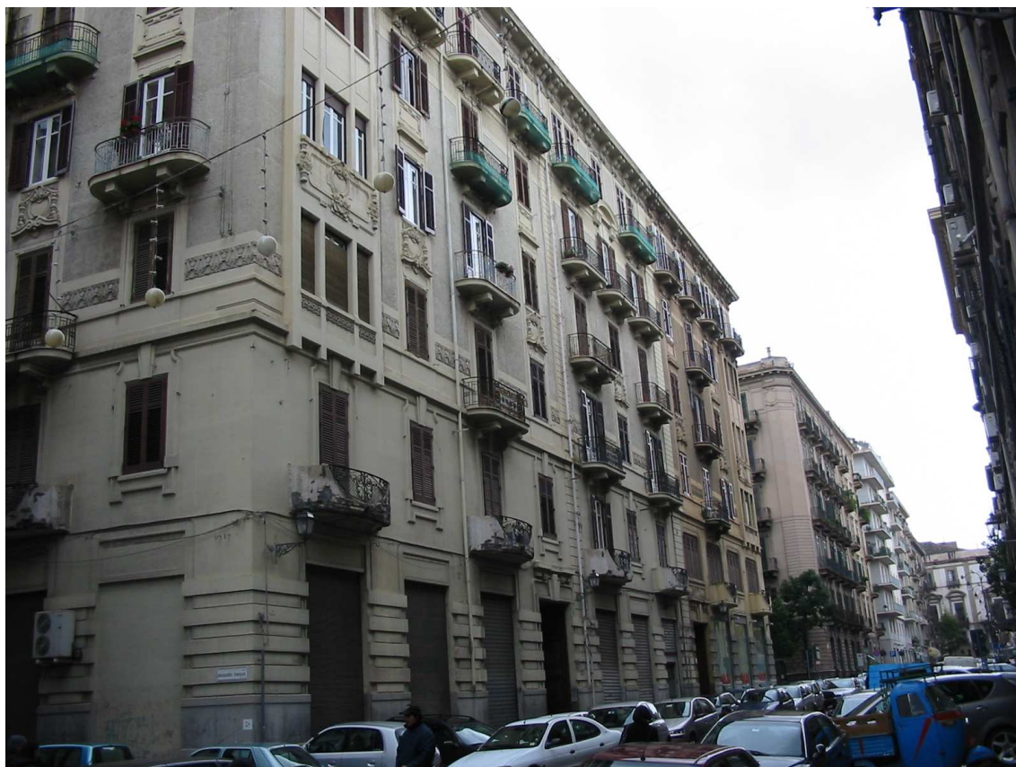
Prospetto su via Milano
