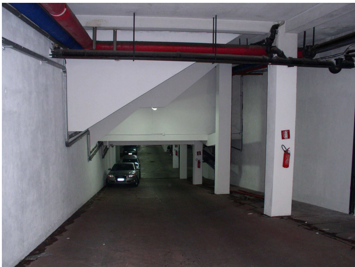
Ingresso ai locali del secondo seminterrato
