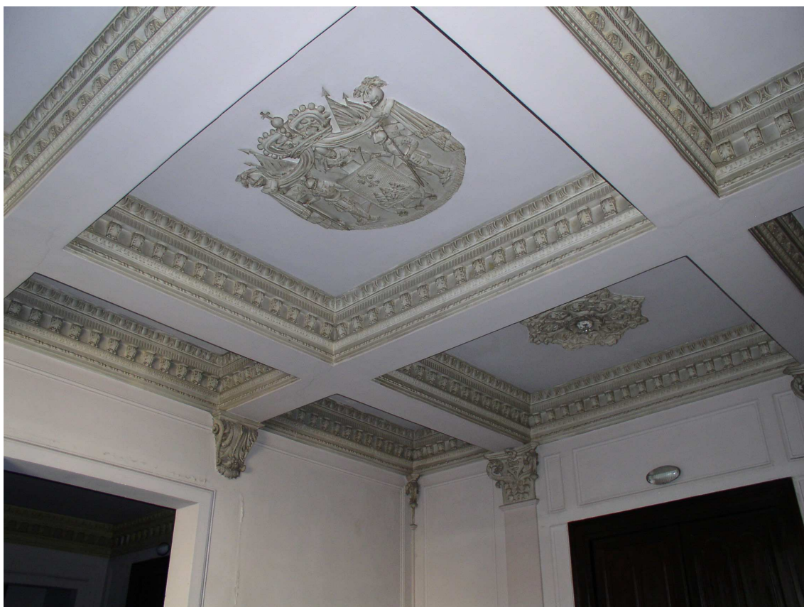
Solaio primo piano
