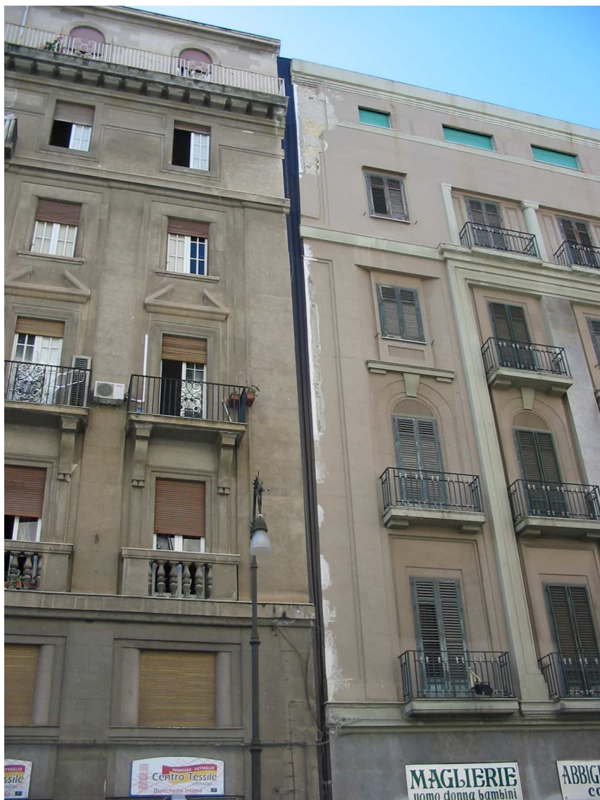
Prospetto su via Malta (particolare del giunto di dilatazione)
