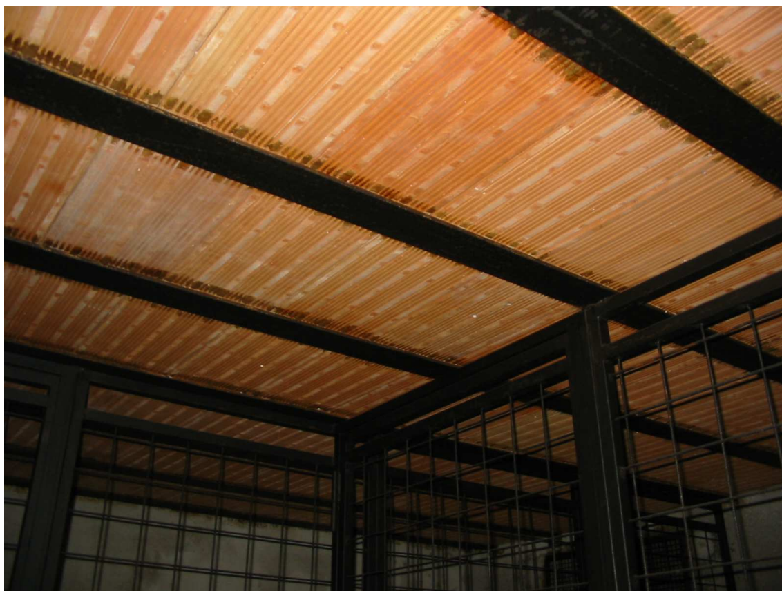
Piano cantinato (particolare del solaio in ferro e tavelloni)
