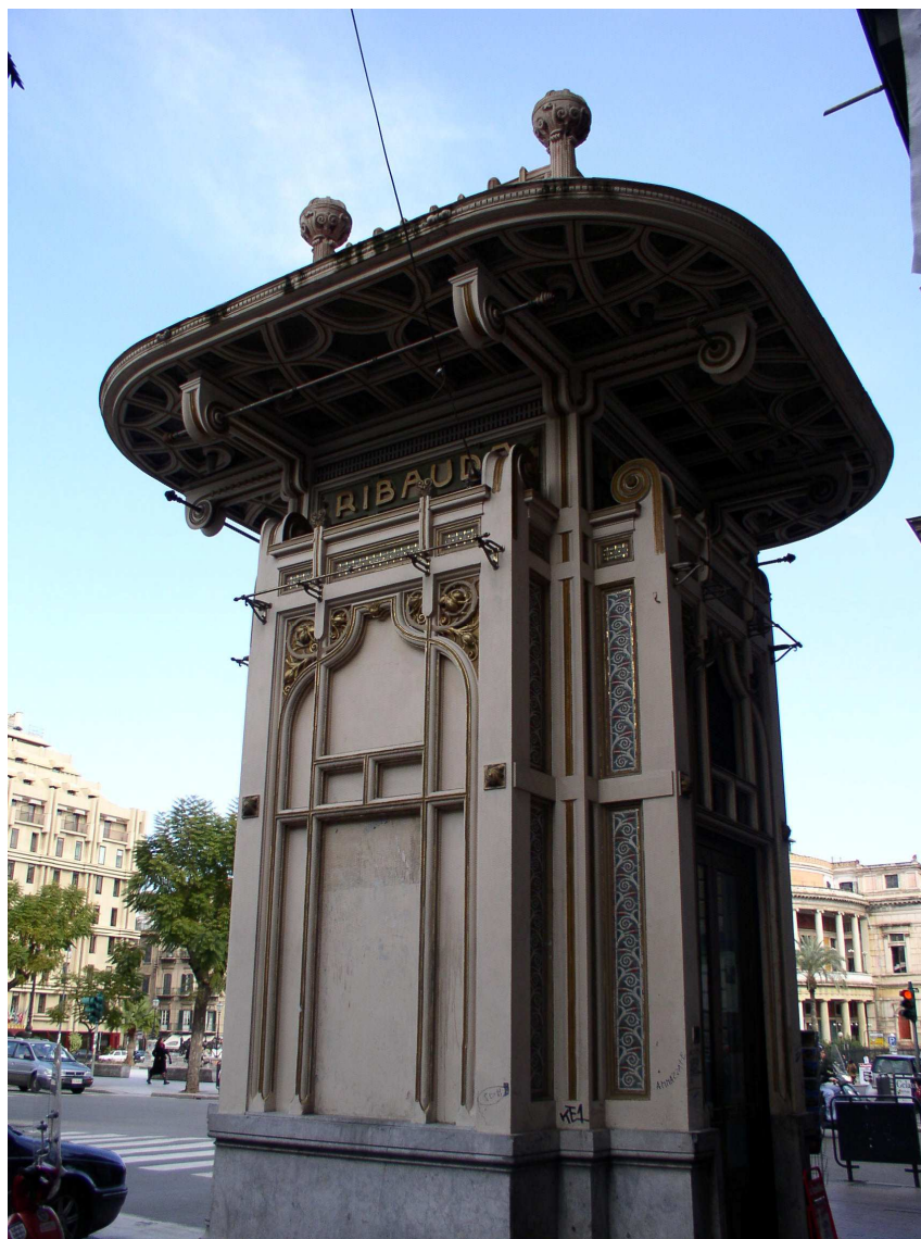
Prospetto su Piazza Castelnuovo
