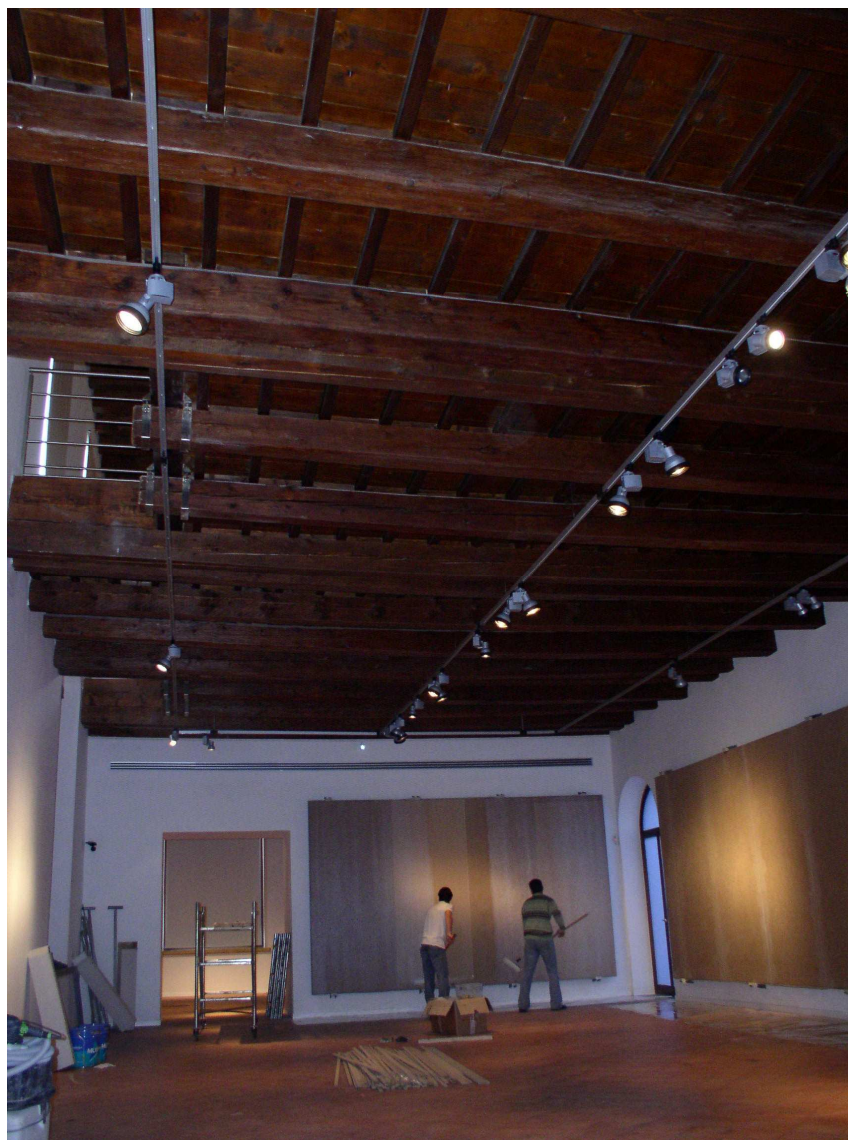
Solaio a primo piano
