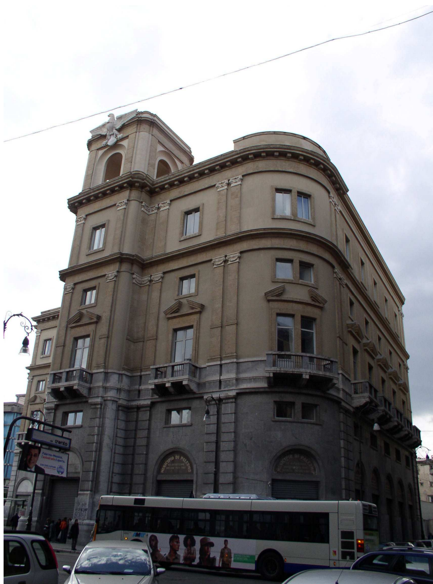
Prospetto su via Roma e su via Trieste
