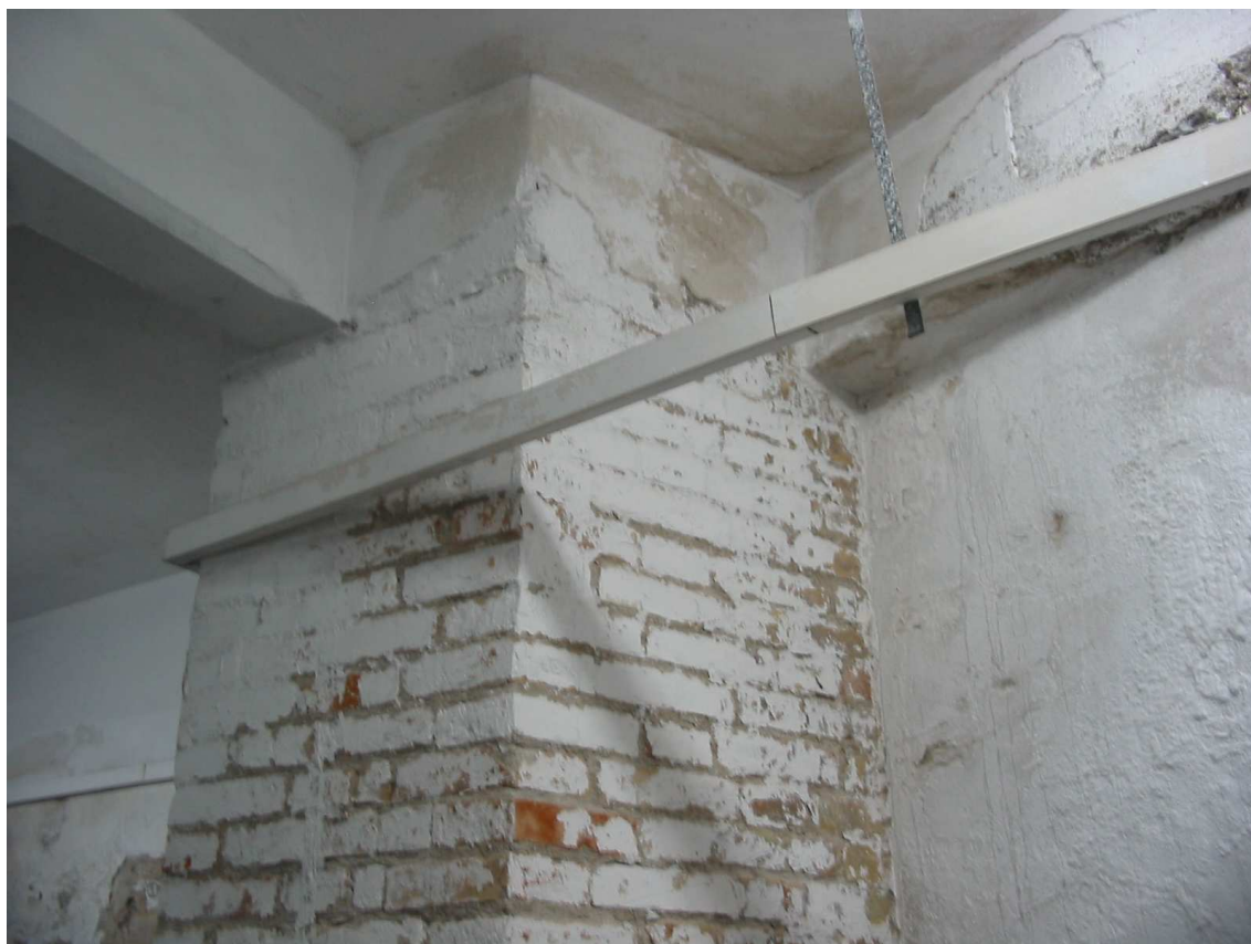
Piano cantinato (particolare del nodo pilastro in mattoni - trave in c.a.)
