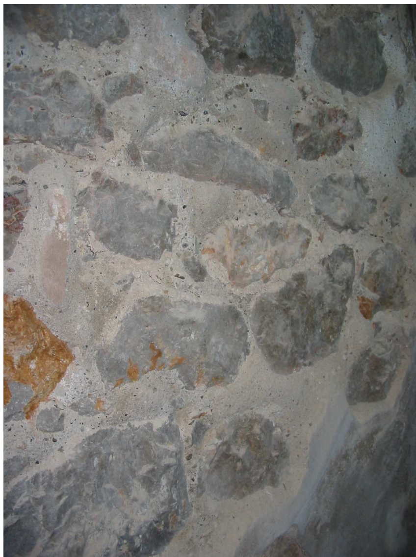
Locale cantinato (particolare della fondazione in muratura)
