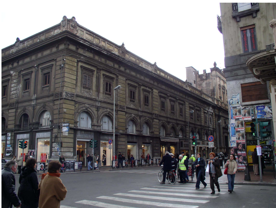
Prospetto su via R. Settimo
