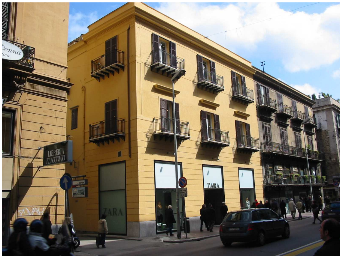
Prospetto su via Ruggero Settimo
