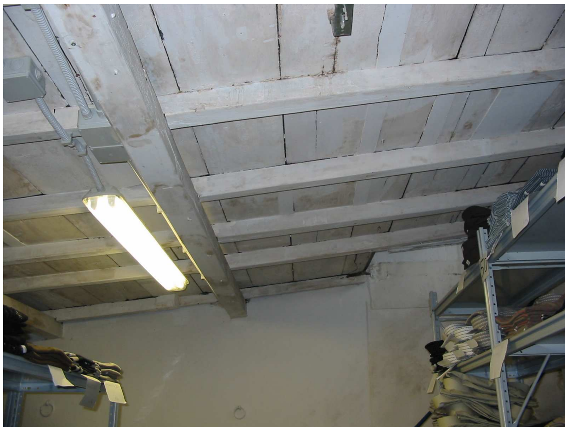
Quarto piano (particolare del solaio di copertura)
