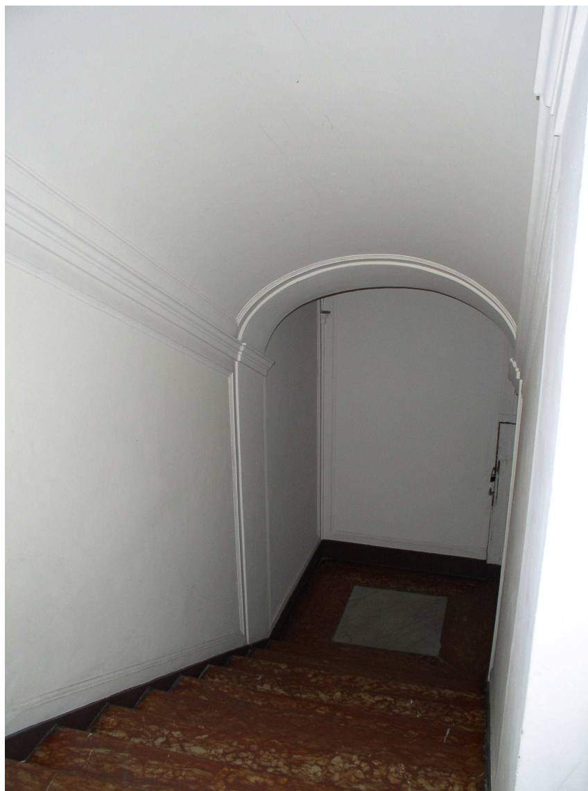
Scala interna in muratura portante
