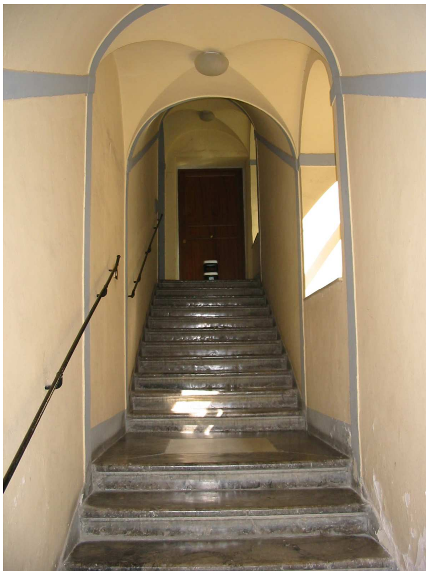
Una delle due scale condominiali
