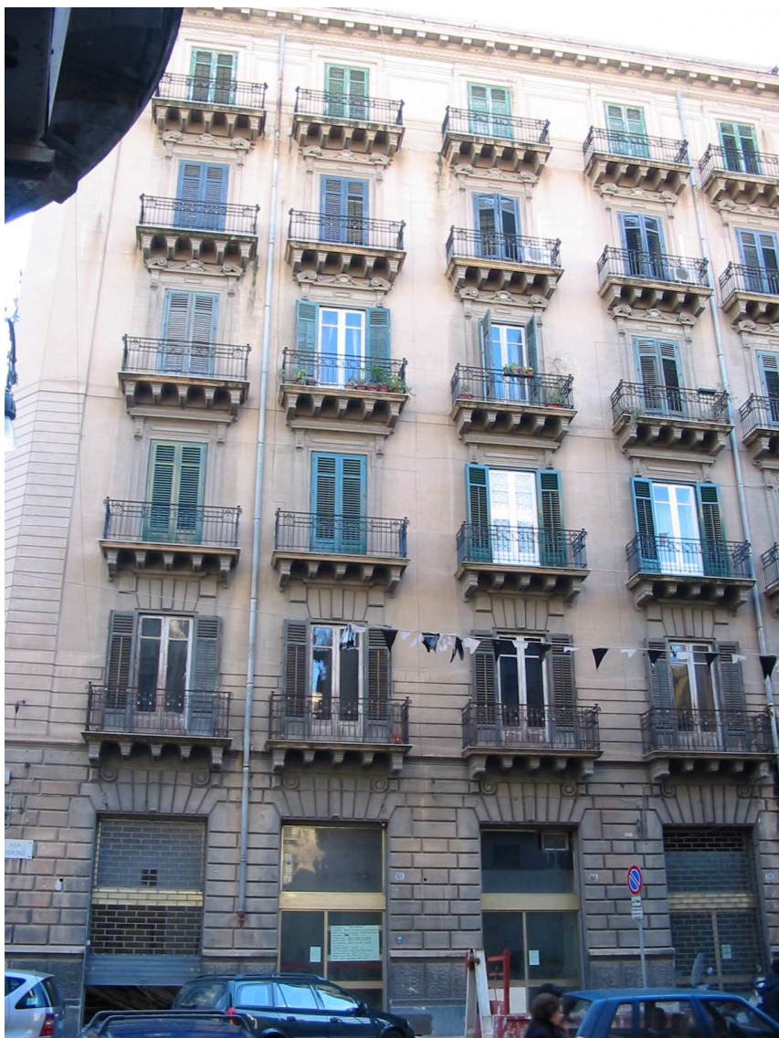
Prospetto su via Torino
