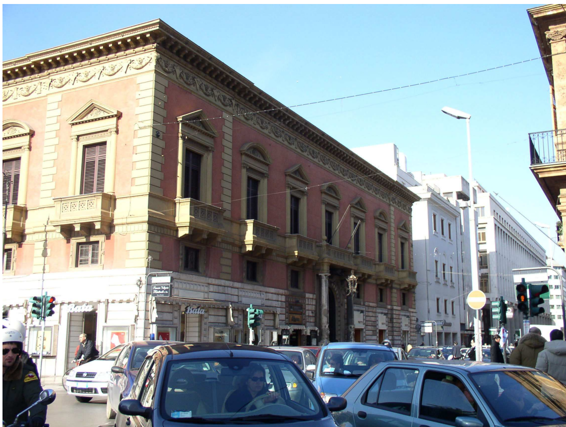
Prospetto su via R. Settimo
