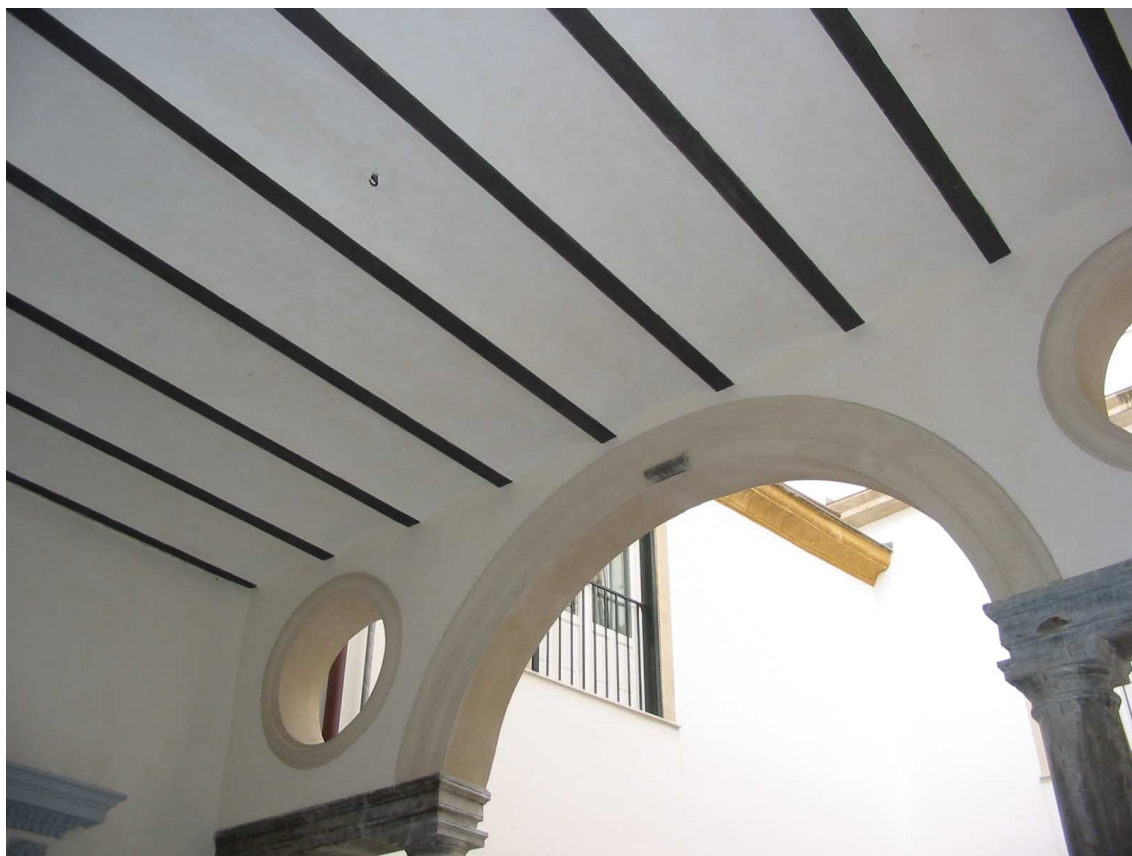
Primo piano (particolare del solaio in ferro e voltine)
