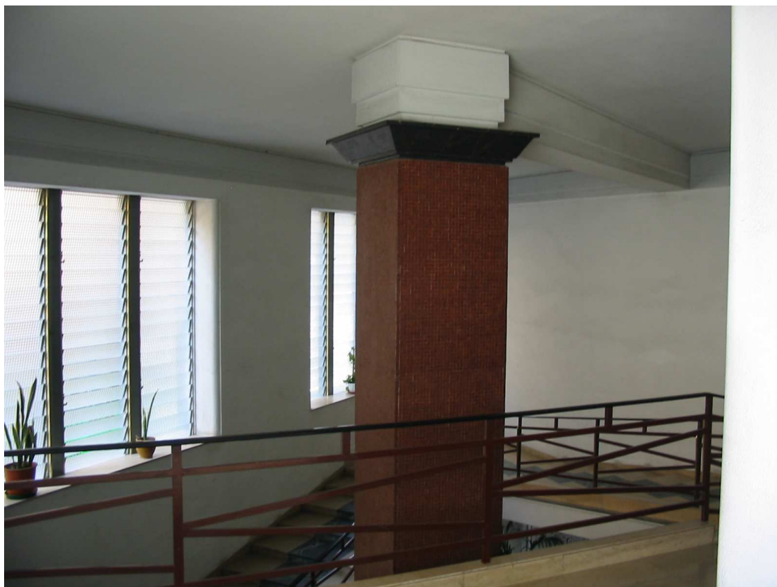
Corpo scala di ingresso al piano ammezzato
