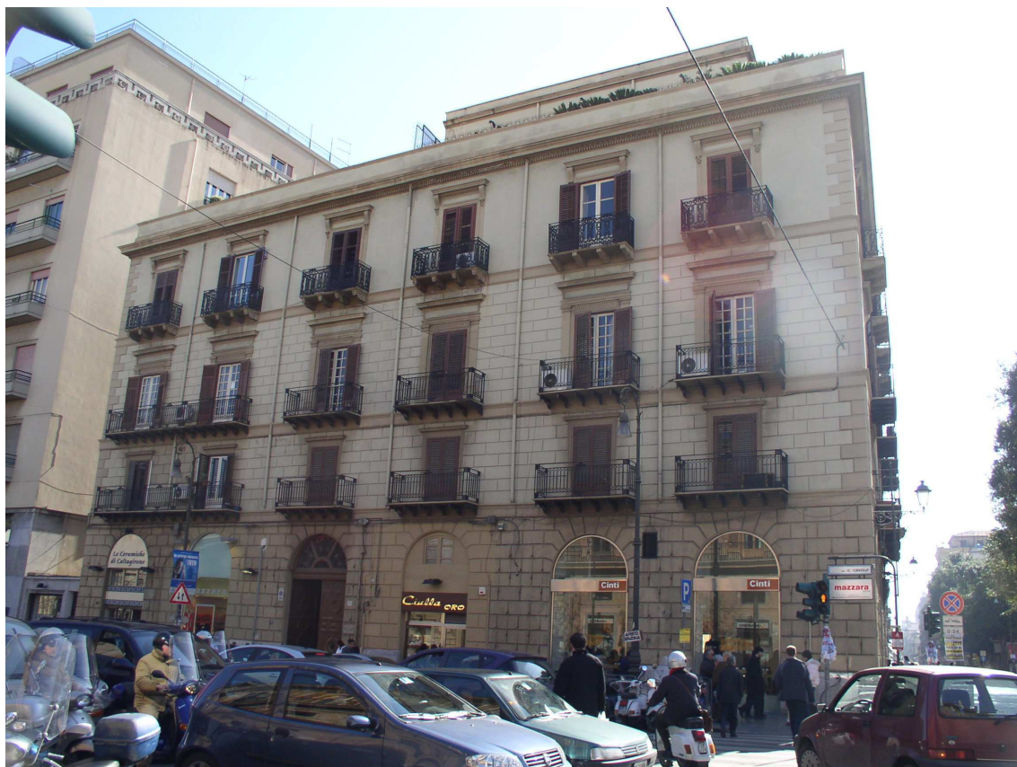
Prospetto su via Cavour
