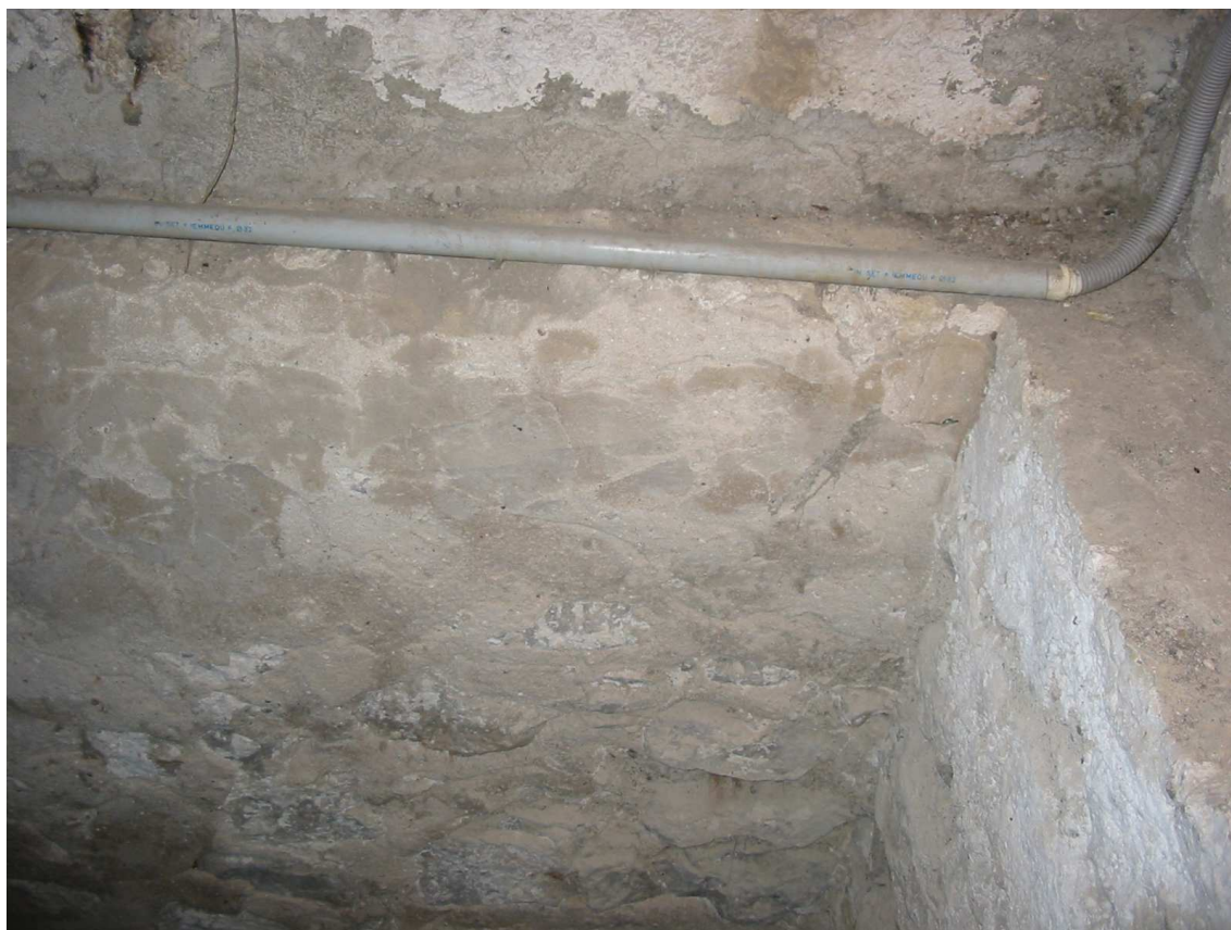
Piano cantinato (particolare della fondazione in muratura)
