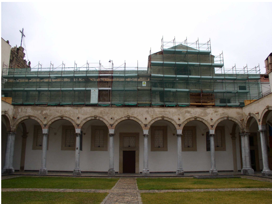
Parte superiore del prospetto laterale (inglobato dal ponteggio) visto dal chiostro del Convento di S. Anna
