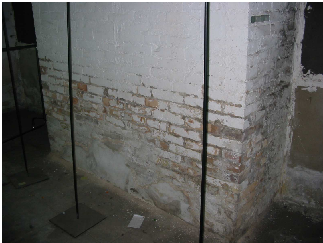
Piano cantinato (particolare di un pilastro in mattoni)
