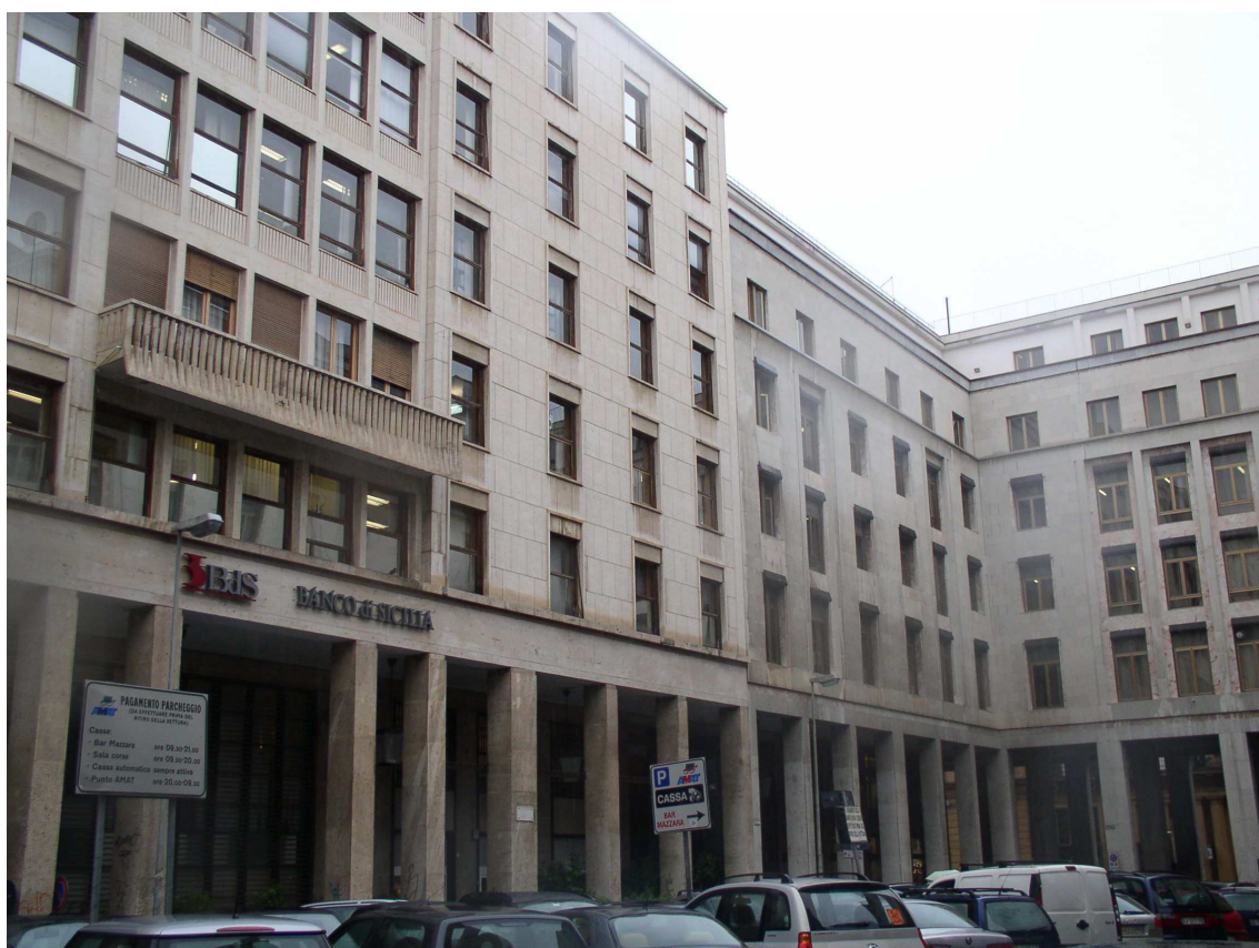
Retroprospetto su Piazzale Ungheria
