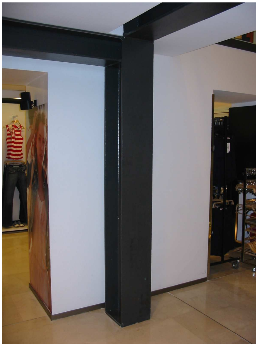
Particolare della struttura in acciaio
