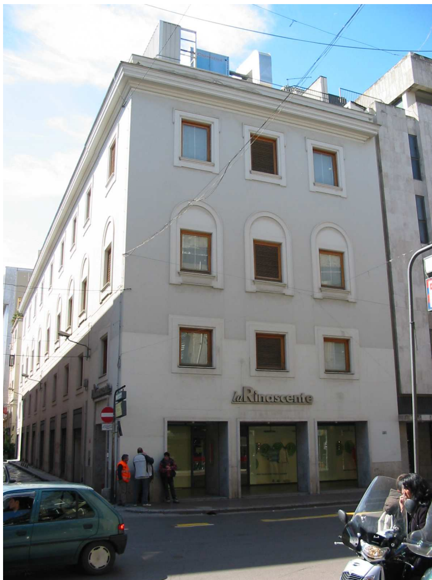
Prospetto su via Ruggero Settimo
