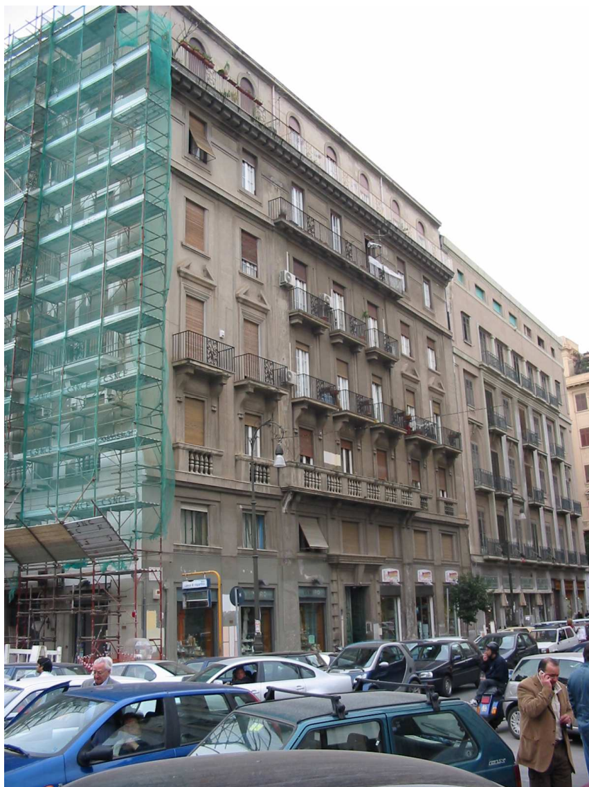
Prospetto su via Malta
