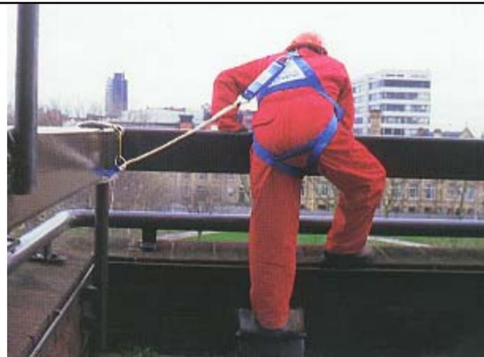
I cordini specifici incorporano un assorbitore di energia con funzione di limitare le forze esercitate sul corpo in caso di caduta.
