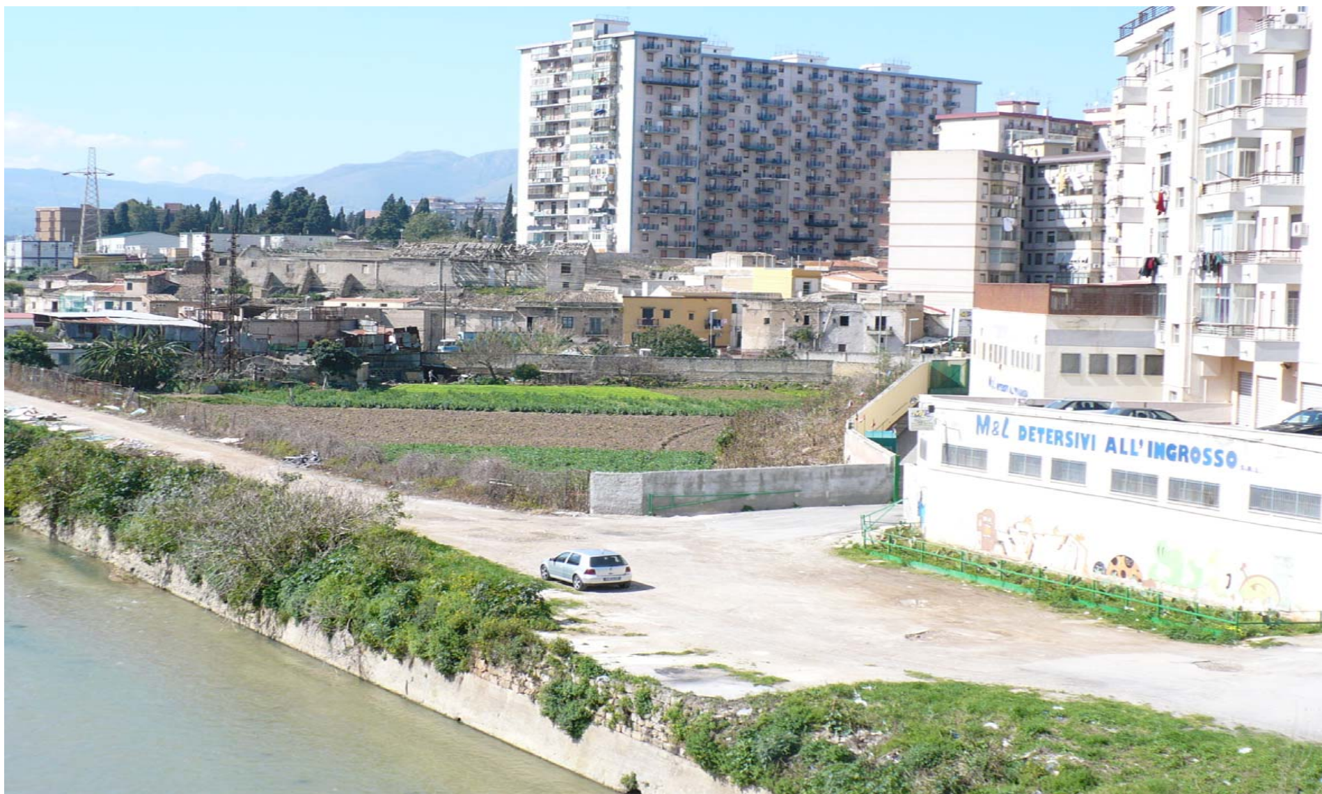
Figura 5.- Dalla sponda dx del fiume Oreto alla stazione Oreto Nord. Aspetto dell'assetto dell'area interessata dal tracciato della metropolitana.
