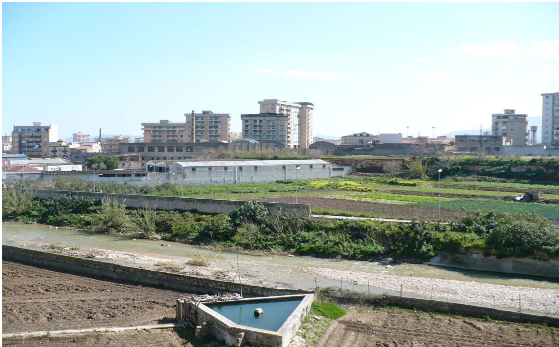
Figura 4.-Aspetto della trasformazione in canale di scolo del tratto terminale del fiume Oreto interessato dal tracciato della metro a causa della cementificazione dell'alveo e dell'uso improprio delle golene.
