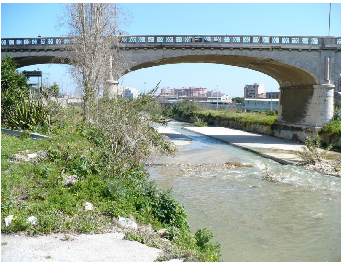
Fig. 13.- Aspetto degli effetti della cementificazione sui valori naturalistici del tratto fluviale dal ponte Oreto alla foce, evidenziati dalla canalizzazione dell'alveo, dall'assenza di vegetazione lotica, dal carattere ruderale della vegetazione delle rive e dalla presenza di specie esotiche invasive.
